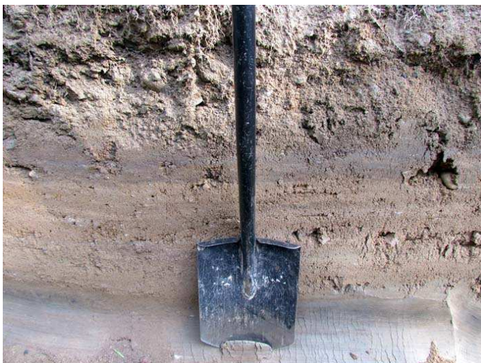
Kuva 3. Tyypillinen maannos kaapelikaivannossa, jossa ei havaittavissa historialliseen tiehen liittyviä kerrostumia. (kuva Hämeenkyrö Jaakonpolku 2014: 3)
