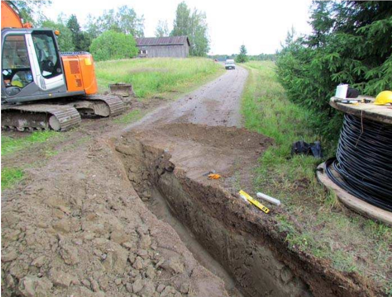
Kuva 11. Tien viistosti poikittava kaivanto 2 kuvattuna etelästä. (kuva Hämeenkyrö Jaakonpolku 2014: 11)
