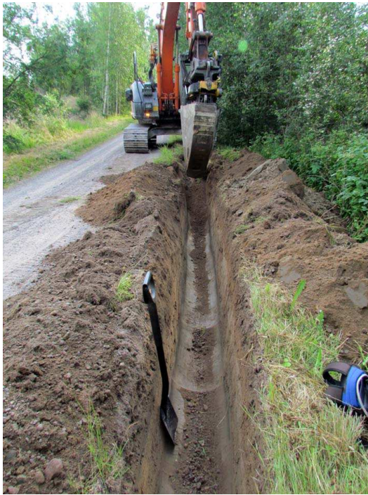
Kuva 1. Tiensuuntainen kaapeliura sijaitti tien länsi- tai eteläreunassa. Kuvattu luoteesta. (kuva Hämeenkyrö Jaakonpolku 2014: 1)
