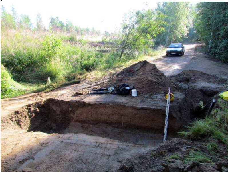
Kuva 8. Kaivanto 1, kuvattu lännestä. (kuva Hämeenkyrö Jaakonpolku 2014: 8)
