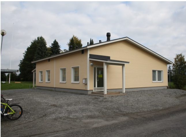
Koulun pihapiirissä oleva väliaikainen rakennus.
