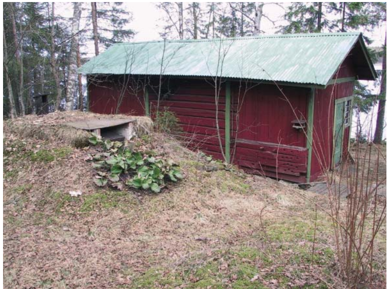
Maakellari ja sauna eteläpuolelta. Seinässä näkyy länkien taivutukseen käytetty rakenne.
