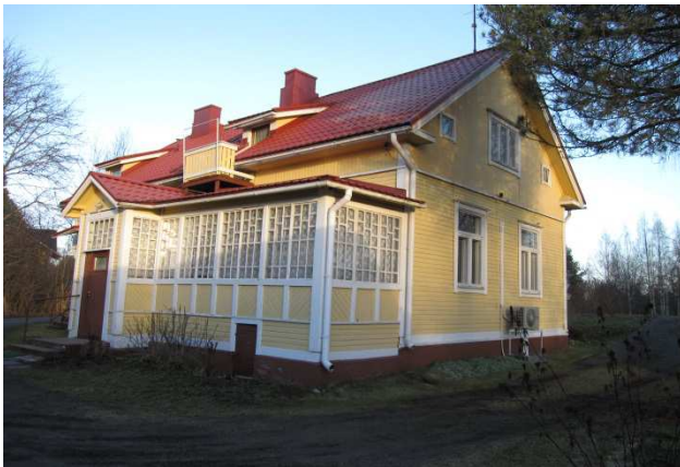
Asuinliikerakennus pihan puolelta, lounaan suunnasta.
