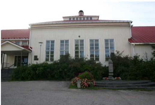
Suojan talon itäjulkisivua vuonna 2013. Edustalla on sotaveteraanimuistomerkki eduskiveyksineen.
