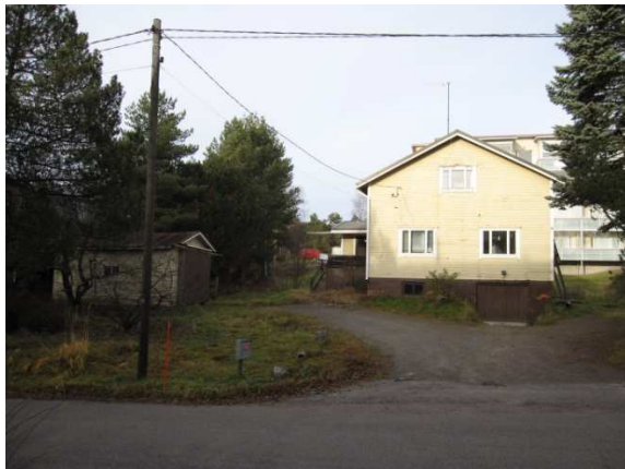
Veikkola asuinrakennuksen eteläpäätä ja vasemmalla pieni talousrakennus, näkymä Koluntien suunnasta.
