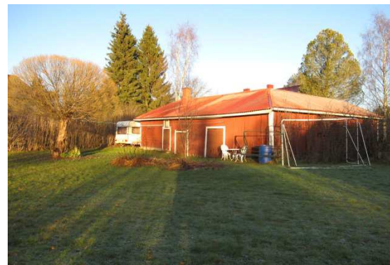
Ulkorakennus (rakennus 2), lounaan suunnasta.
