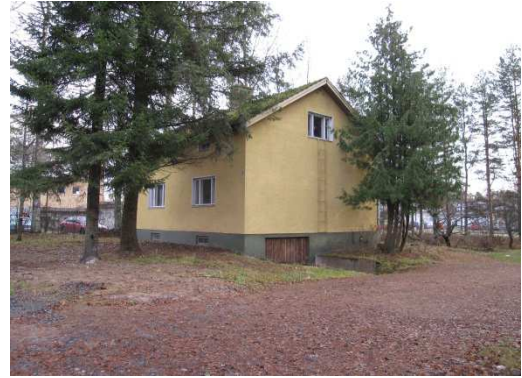
Saario vuonna 1958 valmistunut, rapattu asuinrakennus luoteen suunnasta.
