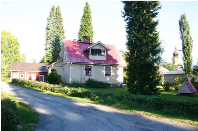
Seitonen Latokujalta länsi-luoteen suunnasta. Asuinrakennus on valmistunut vuonna 1932.
