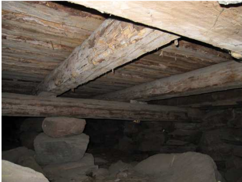
Makasiinin alapohjan kantavia hirsirakenteita.
