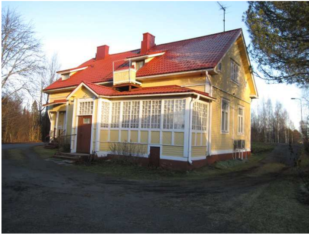
Aikalan asuin-liikerakennuksen pihan puoli, länsisivua ja eteläpäätä.
