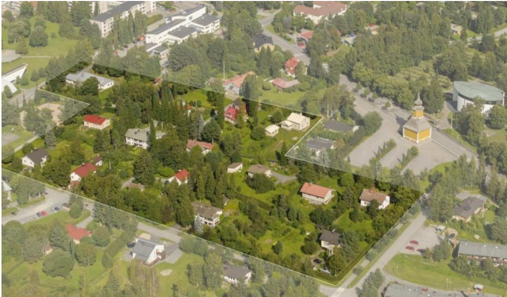
Ote viistoilmakuvasta, lounaan suunnasta. Latokujan ja Tapulintien yhtenäisen rakennuskannan alue on kuvassa korostettuna. (kuva: Lentokuva Vallas 2013, om. Oriveden kaupunki, kuvankäsittely Kristiina Kokko)
