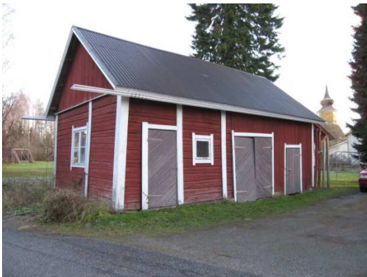
Seitosen talousrakennuksen pohjoispääty on hirsirakenteinen ja vuoraamaton.
