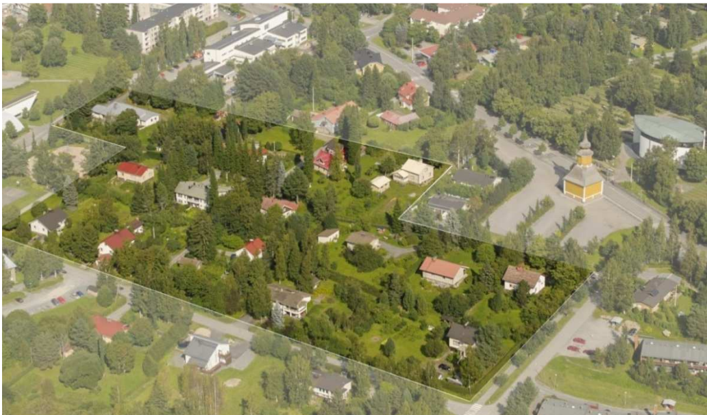
Ote viistoilmakuvasta, lounaan suunnasta. Latokujan ja Tapulintien yhtenäisen rakennuskannan alue on kuvassa korostettuna. (kuva: Lentokuva Vallas 2013, om. Oriveden kaupunki, kuvankäsittely Kristiina Kokko)
