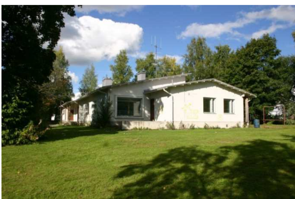
Entinen kunnanlääkärintalo nähtynä Tapulintien ja Kääjänpuiston kulmalta, lounaan suunnasta. 1950-luvun lopulla suunniteltu, vuonna 1960 valmistunut, kunnanlääkärintalo (myöhemmin päiväkotia) liittyy ulkoasultaan alueen 1950-luvulla rakennettuihin rapattuihin, loivakattoisiin pientaloihin.
