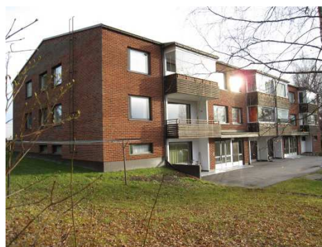
Kuvassa on vuonna 1982 rakennettu As Oy Koluntie luoteen suunnasta 2013. Kaksikerroksisen asuinkerrostalon julkisivut on muurattu tiilestä.
