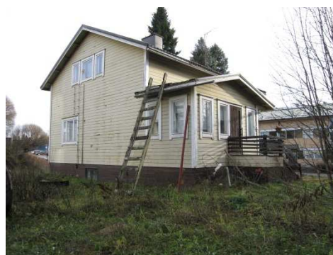
Veikkolan noin vuonna 1955 valmistunut, rankorakenteinen asuinrakennus luoteen suunnasta.
