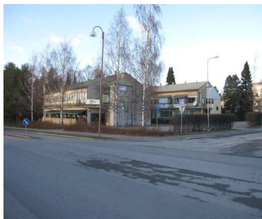
Ahtian Liiketalo Oy valmistui vuonna 1987. Kaksikerroksisen liiketoimistorakennuksen julkisivut ovat tiililaattapintaisia betonielementtejä. Takana Kiinteistö Oy Seetinkulma, mikä sai rakennusluvan vuonna 1988.
