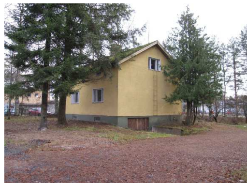
Saario vuonna 1958 valmistunut, rapattu asuinrakennus luoteen suunnasta.
