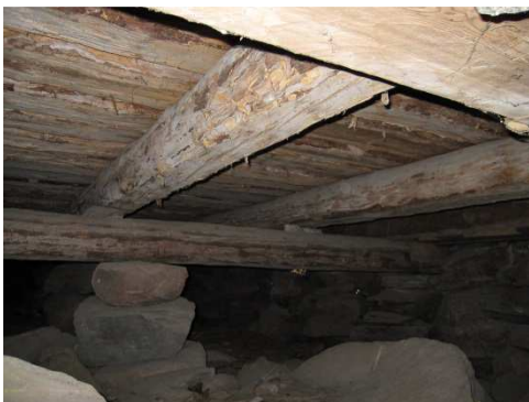
Makasiinin alapohjan kantavia hirsirakenteita.
