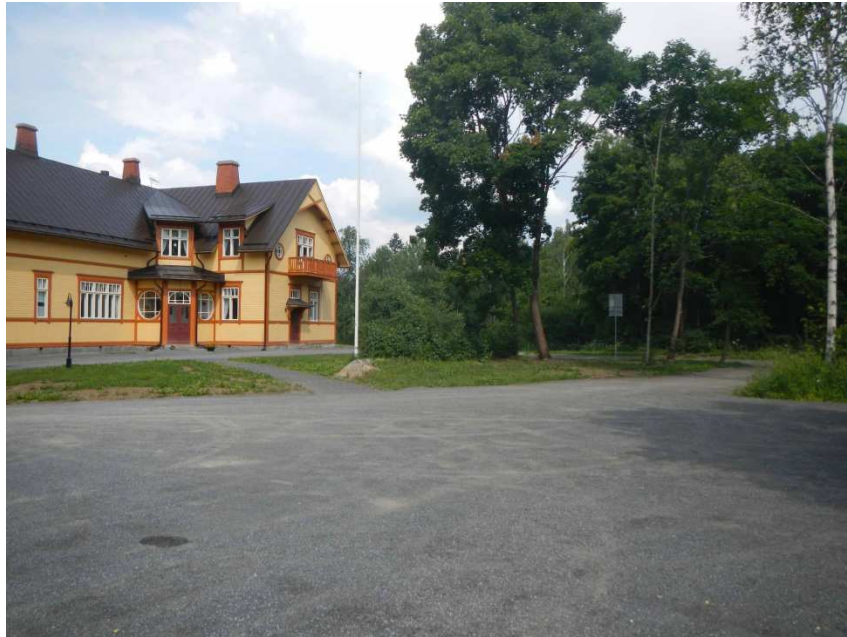
Kuva 19. Pappilan pihapiiriä. Muinaisjäänös sijaitsee kuvan oikeassa laidassa olevassa metsälampareessa. (Kuva: Lempäälä, Kuokkalan Hakkarin Herralan osayleiskaavan laajennusalueen arkeologinen inventointi 2013: 7)
