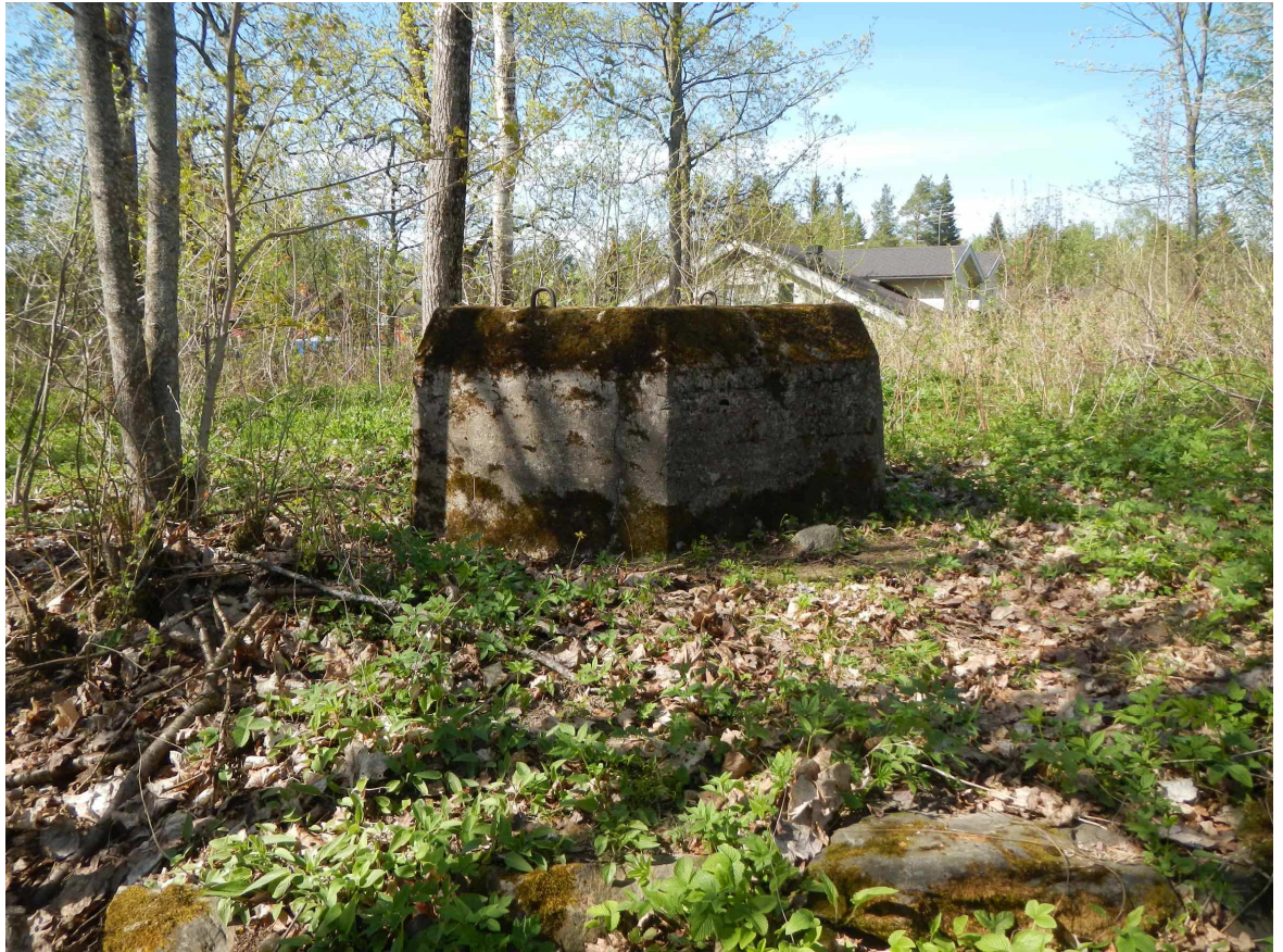
Kuva 43. Hollon sahan isännöitsijän talon vanhalla sijaintipaikalla oleva betoniperustus. (Kuva: Lempäälä, Kuokkalan Hakkarin Herralan osayleiskaavan laajennusalueen arkeologinen inventointi 2013: 23)
