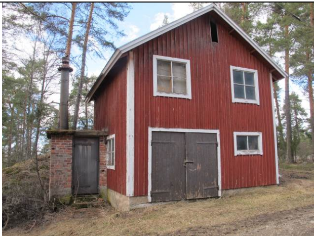
635-426-3-41 Väinölä kuivuri 4 etelästä 2013
