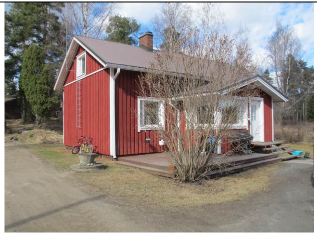
635-426-3-41 Väinölä päärakennus 1 etelästä 2013
