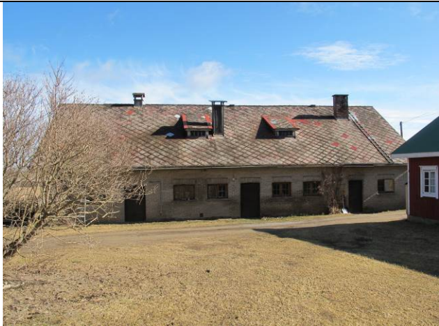
424-2-128 Yli-Hiissa navetta-varasto 3 etelästä 2013
