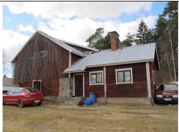
424-4-36 Talo-Rohola karjarakennus 4 koillisesta 2013
