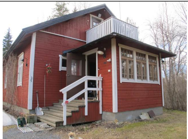
424-4-8 Joenkallio II asuinrakennus 1 pohjoisesta 2013
