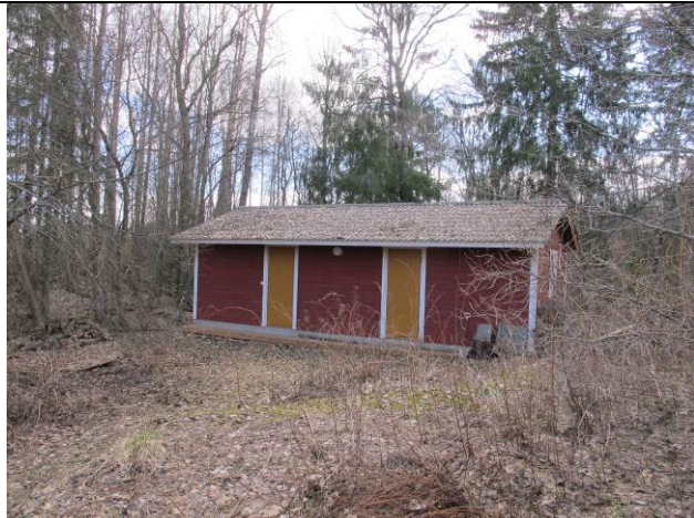
424-4-8 Joenkallio II ulkorakennus 5 luoteesta 2013
