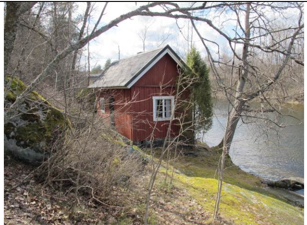
424-4-8 Joenkallio II sauna 2 koillisesta 2013
