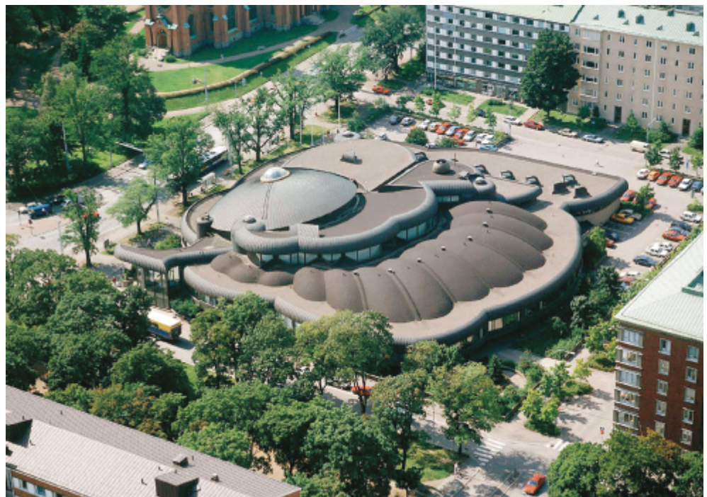
TAMPEREEN PÄÄKIRJASTO METSO / RAKENNUSINVENTOINTI
