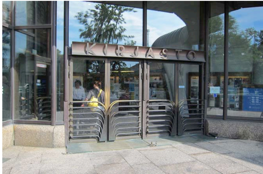
Kuva 16. Pääsisäänkäynnin ovi- ja ikkunarakenteita
