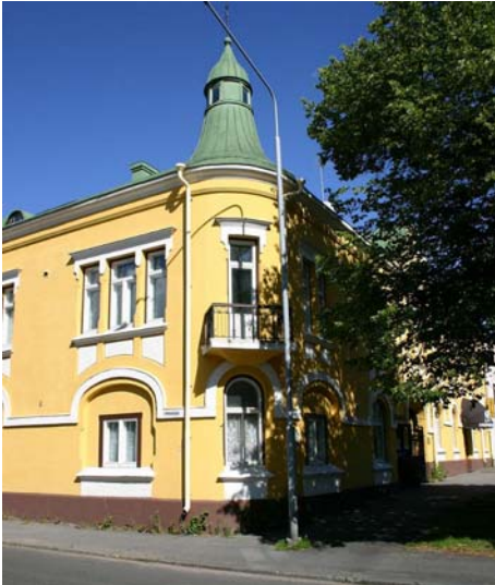
KUVA 4 Lidmanin talon kulma Väinölänskadun ja Peltokadun risteyksessä. Lähde: Tampereen kaupungin rakennusval- vonnan kuva-arkisto
