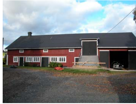
Alkuperäiset piirteet ovat hyvin säilyneet julkisivukunnostuksessa. Menkala.
