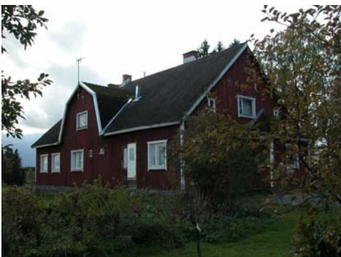
Takasivu voi olla talon näkyvin julkisivu. Uusitalo Halmeenmäellä.
