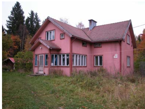
1940- ja 1950-luvun vaikutus näkyy uusissa ikkunamuodoissa ja heleänä ulkoväriytyksenä. Mustiaistenmäki
