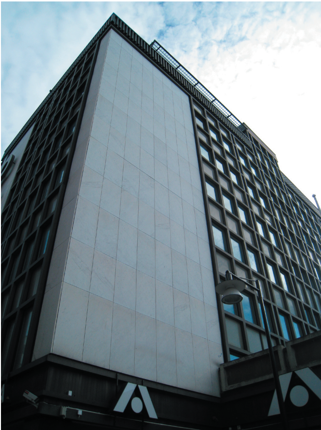
Hämeenkatu 6:n julkisivukäsittelyä, alumiiniprofiili ja valkoinen marmori.
