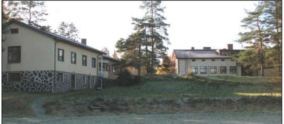
Kuva: oppilasasuntola Kipinä ja opistorakennus pohjoispuolelta kuvattuna.
