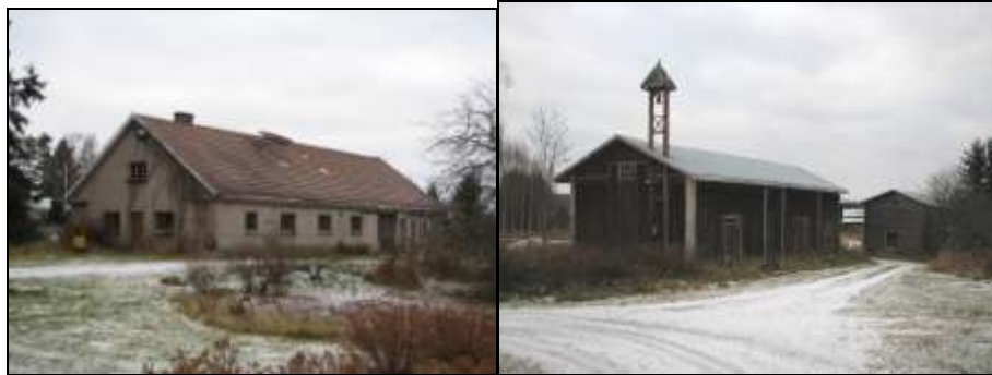
Kuvat: pihapiirin navetta ja hirsiset talusrakennukset
