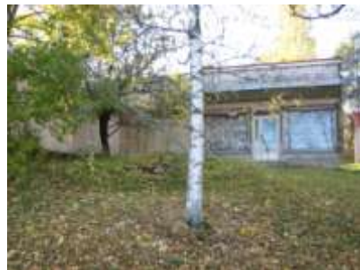
Hankala, Vahannan kaupparakennus
