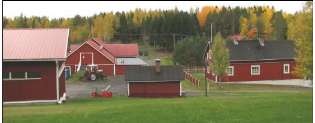
Kuva: Härkilevon rakennuskantaa, varasto navetta/museotila, talousrakennus ja asuinrakennus.
