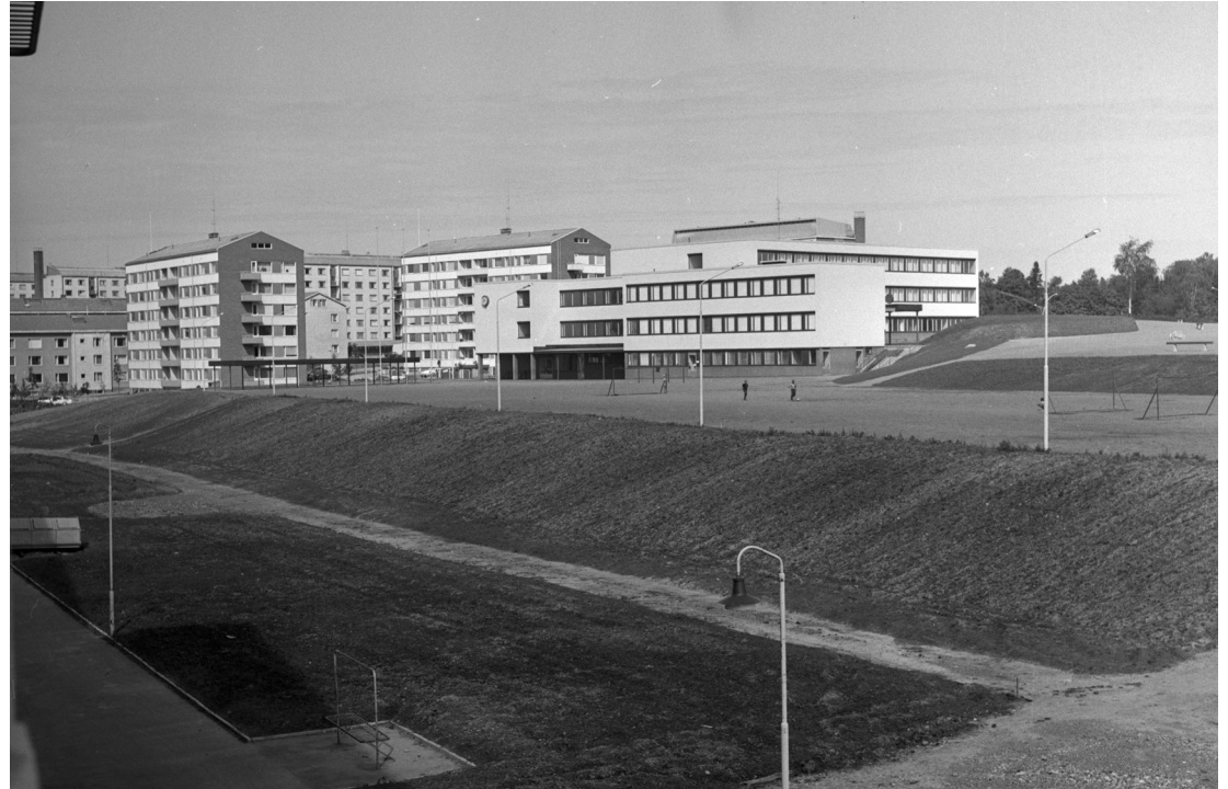
Kuvat 4.3: Koulurakennus ympäristöineen kaakosta vuonna 1965
