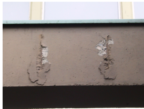
Kuva 5.1: Eteläjulkisivua ja itäjulkisivun sisäänkäyntikatoksen raudoituksia
