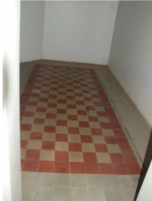
2. kerroksen holvin lattia.
