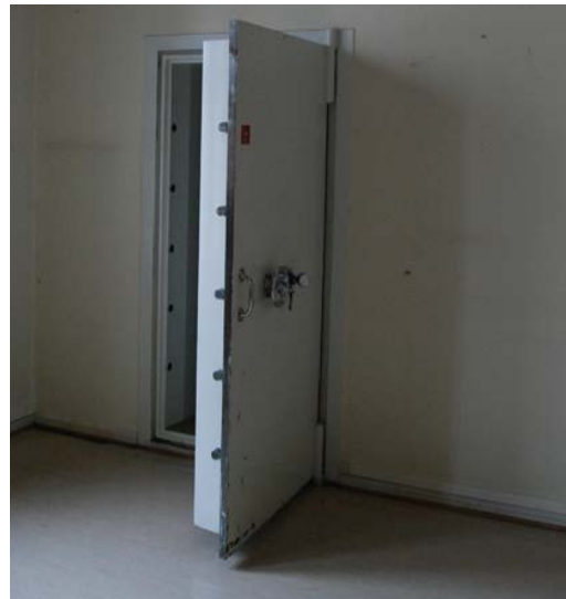
2. kerroksen holvin ovi.
