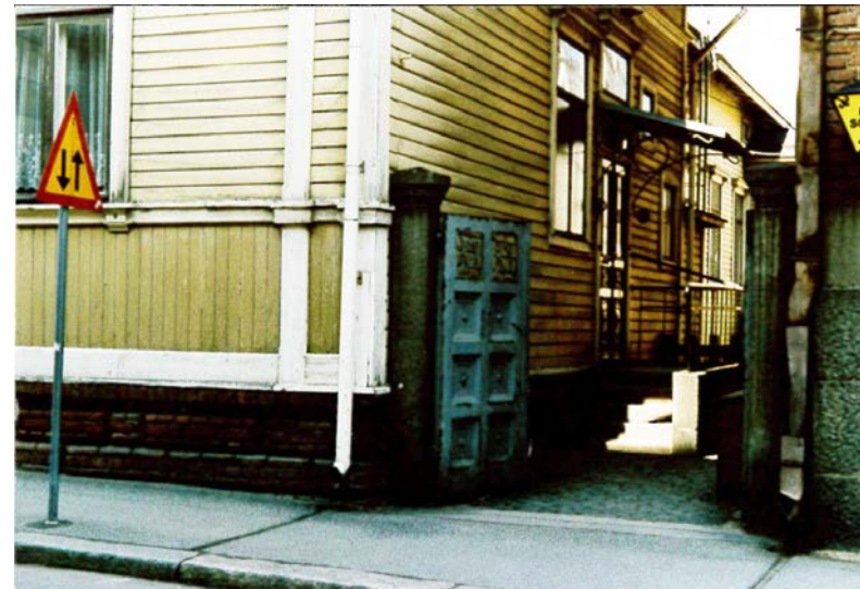
Portti vuonna 1987 ennen peruskorjausta. SRK.
