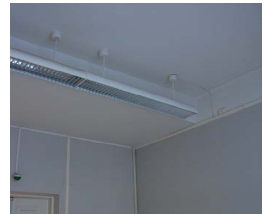
Nykyistä katto- ja seinäpintaa.
