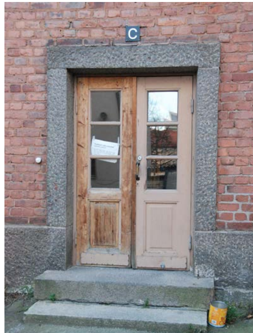
Kivitalon 2. rakennusvaiheen ulko-ovi.
