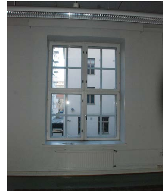
Uusi ikkuna-aukko vuodelta 1970.
