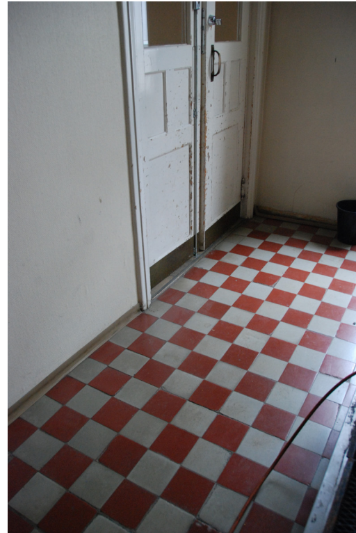
Säilynyt lattiapinta ja asunnon ulko-ovi muutettuna.
