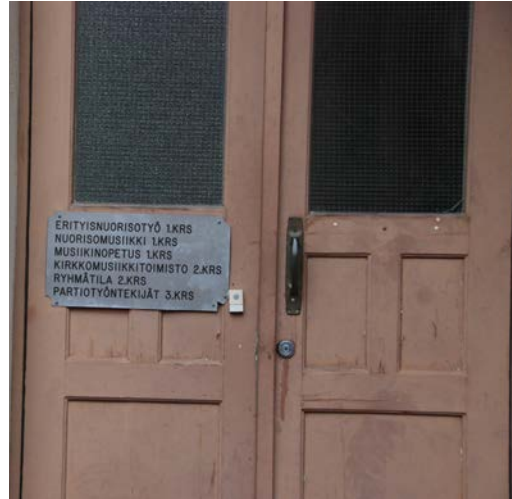
Kivitalon 1. rakennusvaiheen ulko-ovi.
