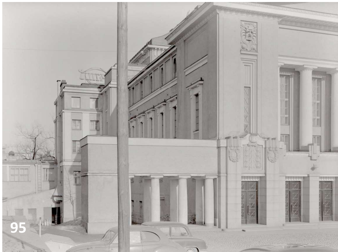
Kuva 95: Tampereen Teatteri kuvattuna lännestä 1950-luvulla. Ennen peruskorjauksen aikaista laajennusta rakennuksen pohjoisjulkisivu oli erinäköinen kuin nykyään, muun muassa pilasterien välistä pääsi kulkemaan läpi henkilökunnan ovelle. Kuva: Juhani Riekkola/ Vapriikin kuva-arkisto.
