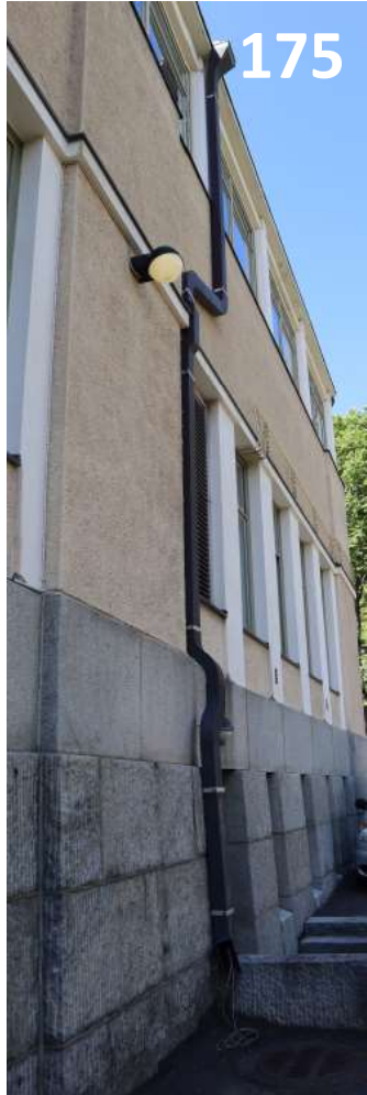
175. Mustat, peltiset syöksytorvet vaikuttavat uusitun. 176. Syöksytorvi kulkee rakennuksen julkisivun tasassa. 177. Yksityiskohtakuva syöksytorvesta. 178. Sadevesikaivo on metallia.
