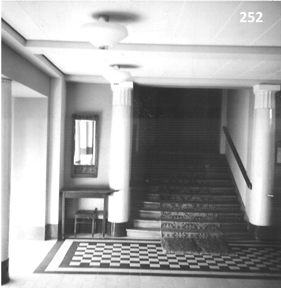
Kuva 251. Eteishalli kuvattuna kohti pohjoista. Kuva 252. Eteishalli kuvattuna kohti pohjoista 1960-luvulla. Seinät ovat vaaleat, pylväissä on kiiltävä vaalea maalipinta. Katossa on levytys, valaisimet ovat mahdollisesti 1950-luvulta.
