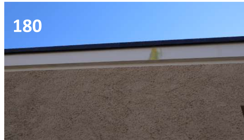
179. Teatterin räystäät ovat lyhyet. 180. Laajennusosassa räystästä ei näy.
