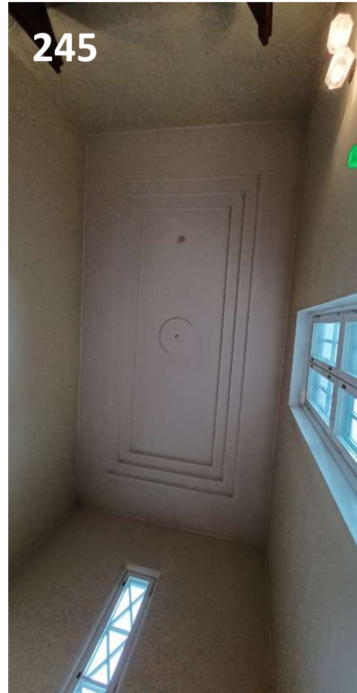
Kuva 241. Suuren lämpöön verholaudat ovat tummaksi petsattua puuta. Kuva 242. Näyttämön yläpuolella olevat koristeet. Koristeista ei saanut kuvaa selvityshetkellä edessä oelvien lavasteiden vuoksi. Kuva 243. Näyttämön manuaalinen ohjaimisto, jolla psytyy nostamaan ja laskemaan lavasteita. Kuva 244. Portaikon koristeellinen, alkuperäinen puuikkuna. 245. Portaikon katto, joka profiloitu.
