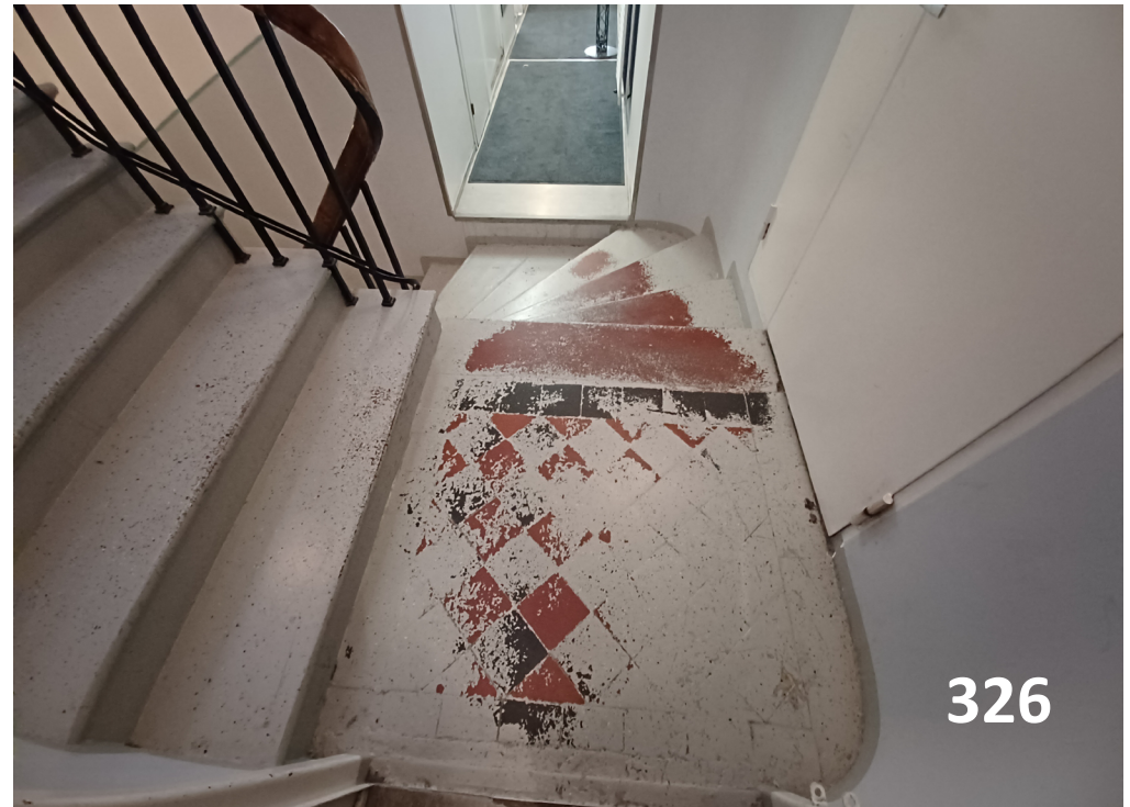
Kuva 324. Puuseppien ja maalareiden porraskäytävä rakennuksen pohjoispuolella on muita porraskäytäviä vaatimattomampi, mutta yksinkertaisuudessaan tyylikäs. Porraskivetyksien pinta on paikka paikoin kulunut. Kuva 325. Kaiteet ja käsijohtimet ovat sirot. Kuva 326. Ensimmäisen kerroksen porrastasanteen punamusta maalaus on kulunut.
