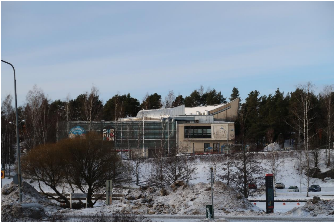
Kuva 34. Korttelahden yli katsottuna rakennuksen alkuperäinen kattomuoto hahmottuu kohtuullisen hyvin.
