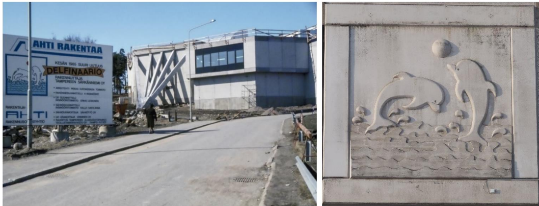
Kuva 9. Delfinaario rakenteilla. Ikkunan takana on delfiinien kotiallas. Työmaakyltissä on sama delfiinikuva, joka on toteutettu rakennuksen seinään betonielementtireliefinä. Vasen kuva Vapriikin kuva-arkisto.
