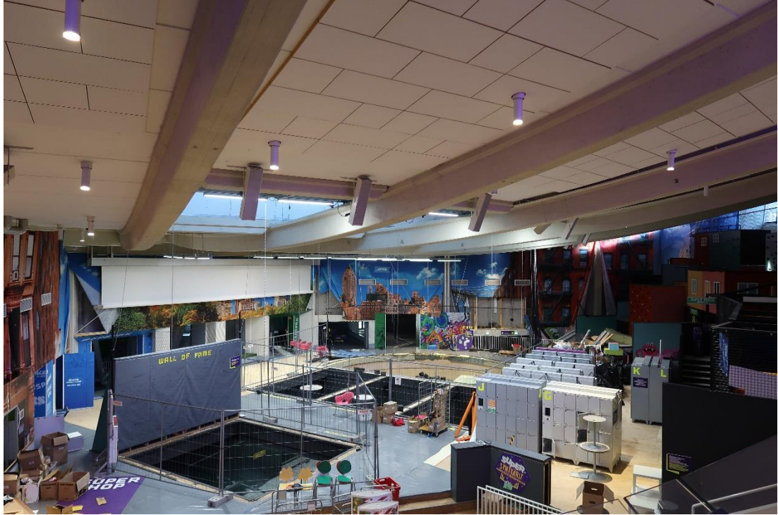
Kuva 25. Pääsali, jossa betonirakenteet ovat säilyneet ja mahdollisesti laatoitus lattiassa altaan ympärillä nykyisten rakenteiden alla.
