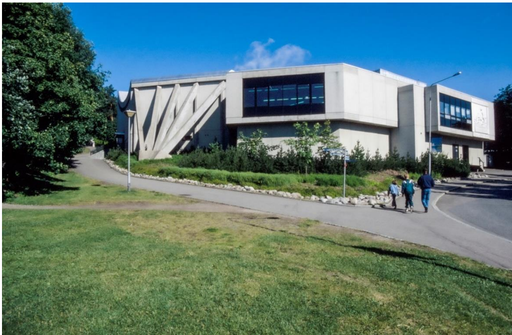
Kuva 4. Henkilökunnan työtilat ja delfiinien kotiallas erottuvat julkisivussa ulokkeina, joiden päädyissä on tummat ikkunat. Laajennuksen myötä toinen päätyikkuna purettiin, koska se jäi laajennuksen sisälle. Kuvaaja Kari Nieminen, kuva Vapriikin kuva-arkisto.
