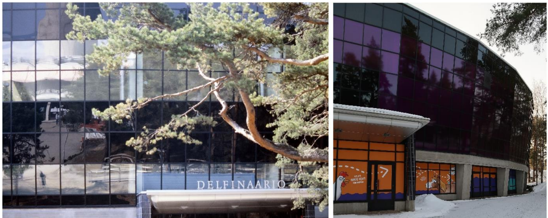
Kuva 32. Vasemmalla kuvassa alkuperäinen lasijulkisivu sekä lipan päällä ollut DELFINAARIO -teksti. Lasijulkisivu vuonna 2024, kun kirkkaan lasit on teipattu SuperParkin rakentamisen yhteydessä violeteiksi ja alaosan ovet on peitetty oranssilla teippauksella. Vasen kuva Vapriikin kuva-arkisto, kuvaaja Kari Nieminen.
