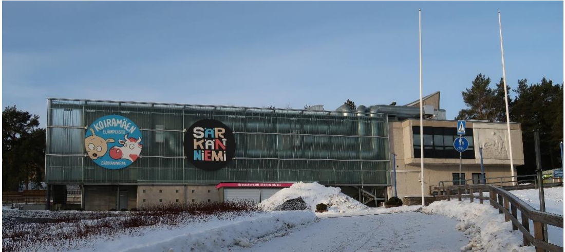
Kuva 31. Kaupungin suuntaan oleva julkisivu lasilankkuineen on laajennuksen aikaisessa asussa. Ensimmäisen vaiheen julkisivusta näkyvissä on aputilojen pääty ikkunoineen ja delfiiniireliefi seinässä.
