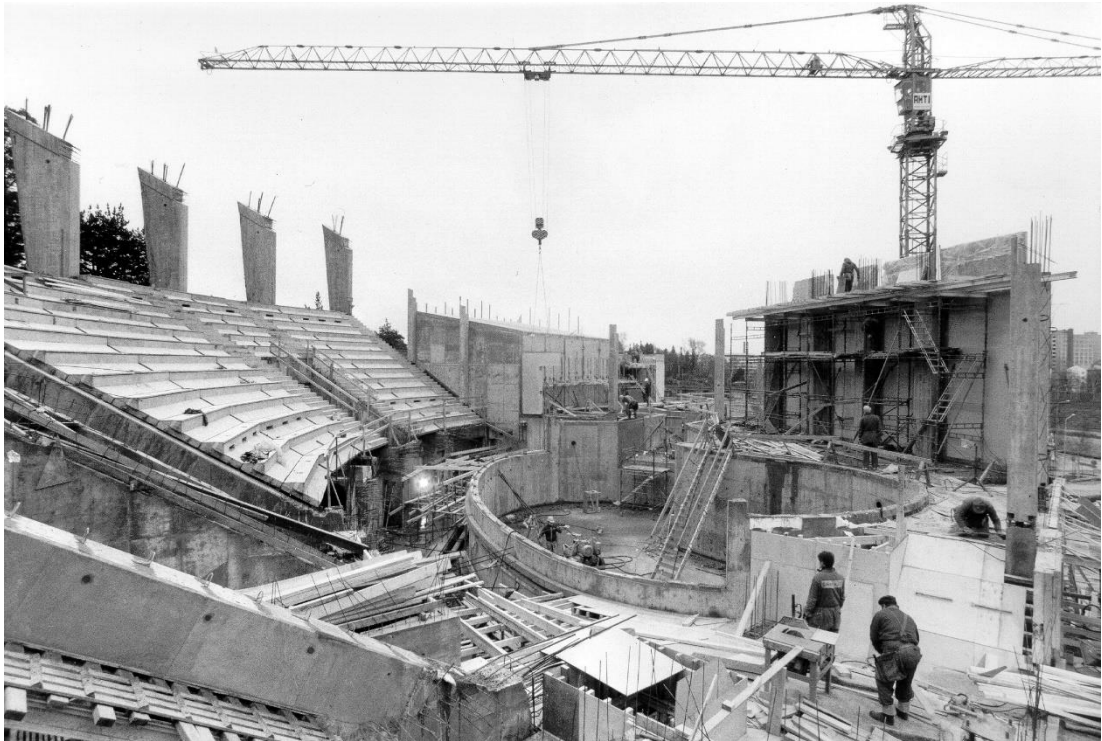
Kuva 7. Delfinaarion työmaa. Betonirakentamisen eri tekniikoita käytössä. Keskellä hahmottuu näytösallas ja vasemmalla rakentuu katsomo. Kuva Särkänniemen arkisto.
