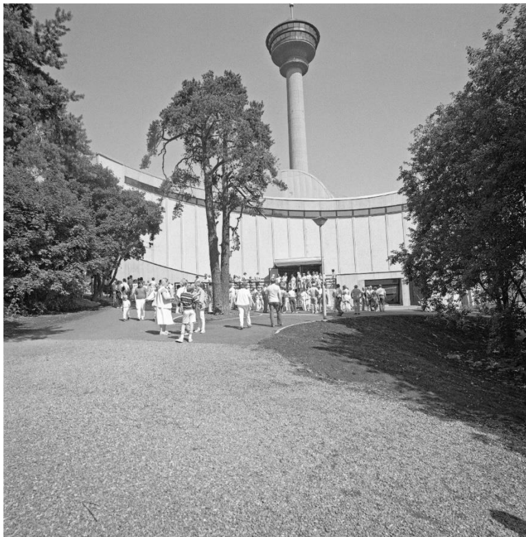
Kuva 14. Pääsalin julkisivu ja yleisön uloskäynti sekä ikkuna näytösaltaaseen. Näkymä, jota nykyisin ei enää ole. Kuvaaja Teuvo Kanerva, kuva Museoviraston kuva-arkisto. (CC BY 4.0)
