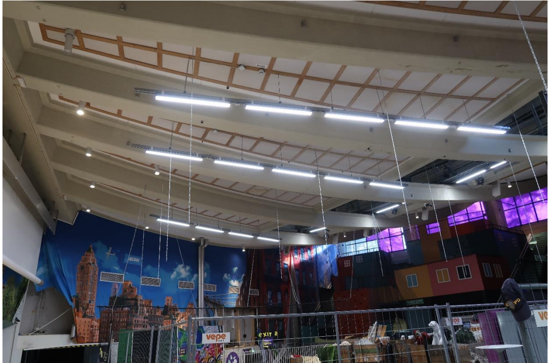
Kuva 27. Kattorakenteet ovat säilyneet, mutta hahmottuvat huonosti roikkuvien valaisimien lomasta.
