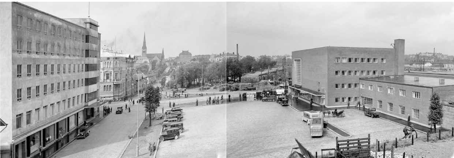
Kuva 47. Rautatieasema ja asema-aukio sekä Hotelli Emmaus juuri valmistuneena vuonna 1936. Taustalla Tammelan sillan purku käynnissä. Panoorama kahdesta kuvasta. E.M.Staf. VKA.
