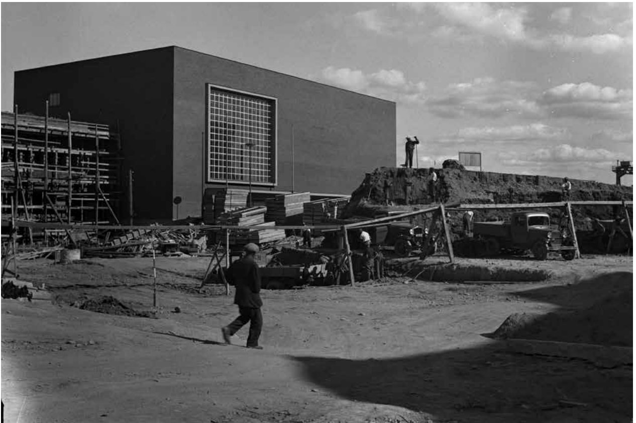
Kuva 43. 20.6.1936. Tampereen rautatieaseman rakennustyömaa, aseman edustalla kulkenutta siltaluiskaa raivataan uusien katulinjausten tieltä. K.O.Lumme. VKA.
