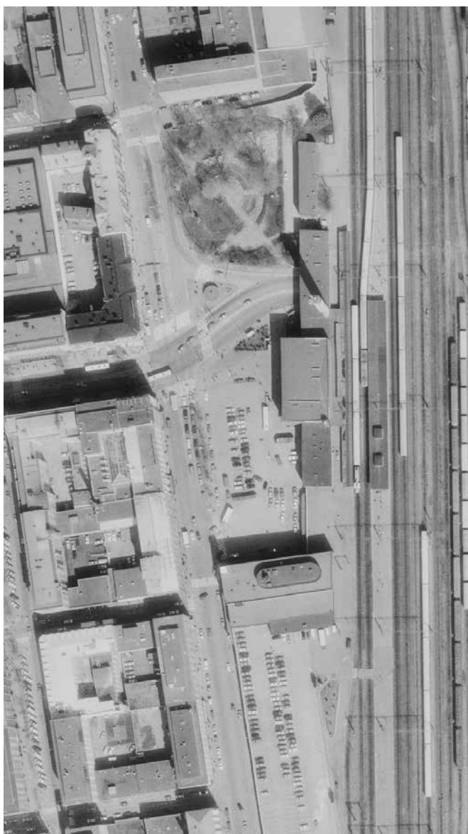
Kuva 64. Näkymä Rautatienkadulta vuonna 1960. Rautatienkadun leventäminen aloitettu, ratapihan alueelta on leikattu maata. Levennystyö tehtiin 1960-1963. Foto Ervi. SRMA.
