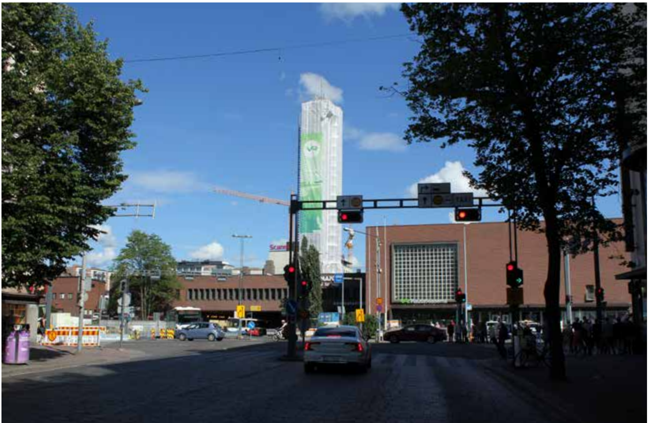
Kuva 90. Sama alue vuonna 2017 on suhteellisen säilynyt, vaikka alue onkin työmaan takia myllerryksessä. Liikennelaitteet hallitsevat näkymää. NA.
