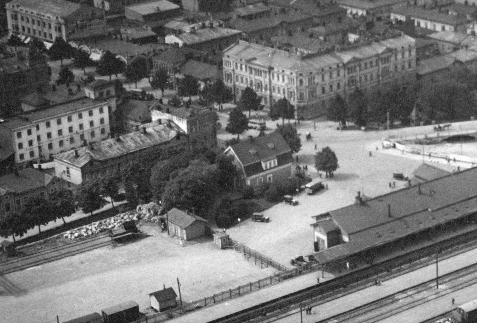
Kuva 32. Viistoilmakuva 1932. Aseman edustalta, sillan eteläpuolelta on poistettu jo puusto tulevaa tunnelia varten. Tunnelitöitä aloitettu jo ratapihallakin. Aseman edustalla näkyy rautatieläisten kauppa. Sillan pohjoispuolelle jäänyt asemapuutarha näyttäytyy kuvassa hyvin puustoisena. Puut ovat jo kookkaita. VKA.
