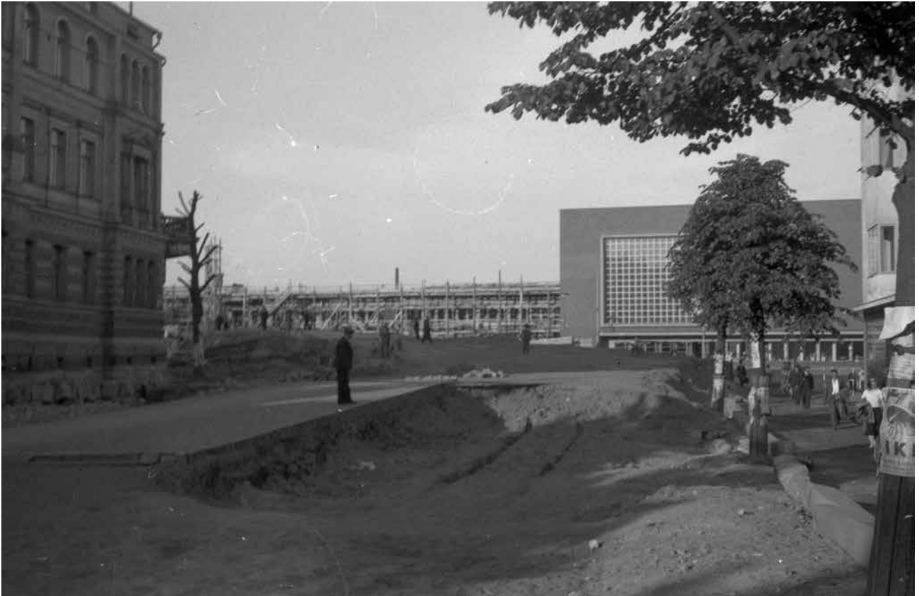
Kuva 44. Hämeenkadun itäpään madaltaminen käynnissä vuonna 1936. Madaltaminen tehtiin vaiheissa, Emmauksen rakentamisen yhteydessä oikea puoli kadusta madallettiin. Tässä kuvassa sen puolen puutkin jo istutettu takaisin uuteen korkoon. Toisella puolella tietä tyvistetyt puut odottavat vielä siirtoa. G.W.Gestrin. VKA.
