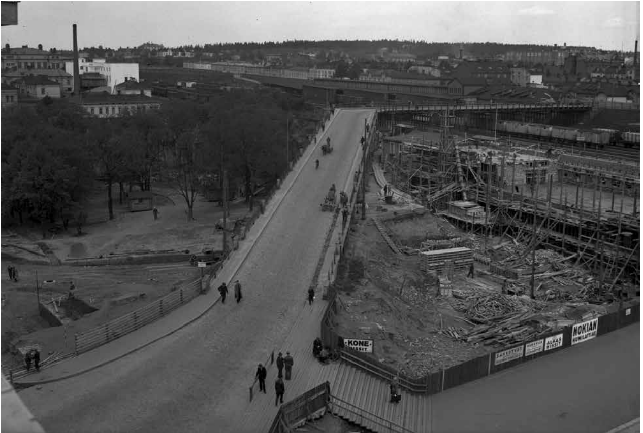
Kuva 42. 1936. Uuden rautatieaseman toisen vaiheen rakentaminen käynnissä Tammelan sillan kupeessa. Sillan vierellä, puistossa näkyy pieniä harjakattoisia rakennuksia, jotka liittyivät mahdollisesti aseman rakennustyömaahan. E.M.Staf. VKA.
