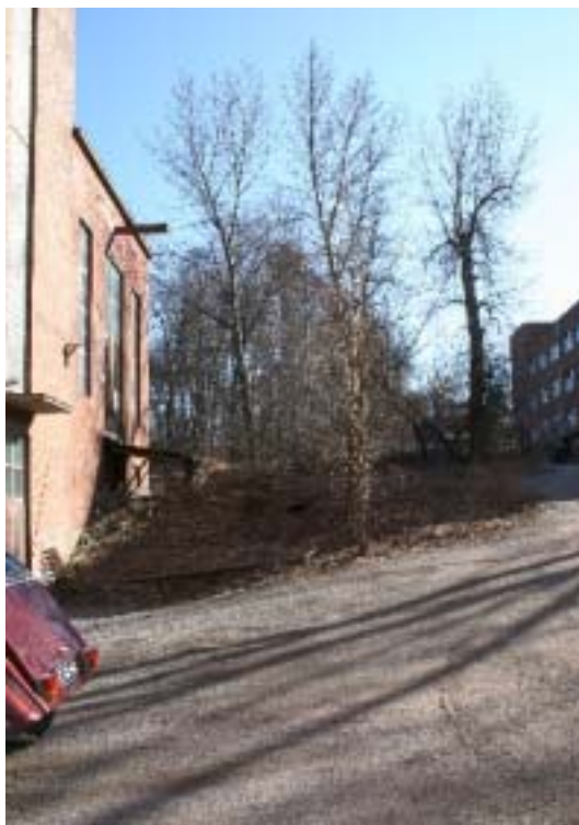
Kuva 65. Voimalan edustan maasto on jyrkkää. Kuva 10-2005.
