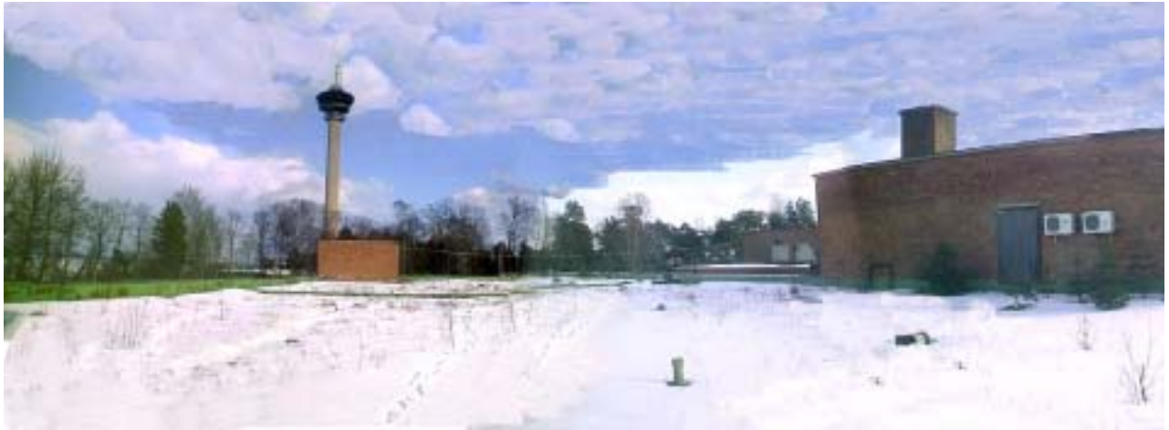
Kuva 55. Kattoterassi soveltuisi parhaiten ravintolakäyttöön sen suomien komeiden maisemien vuoksi. Yhteys Näsinneulaan. Kuva 03-2005.
