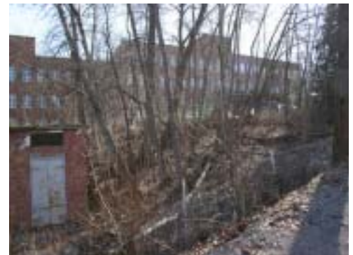
Kuva 32. Komea Suomen Trikon rakennus - kaikelta piilossa. Tontin maastoero Voimalan edustan maastoon on 10 metriä. Kuva 04-2005.
