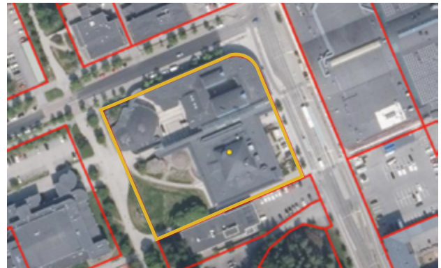
Kuva 3. Kirjistorakennuksen sijainti ortoilmakuvassa, rakennus yhdistyy terveyskeskukseen katosrakenteella. (MML Paikkatietoikkuna 2023.)
