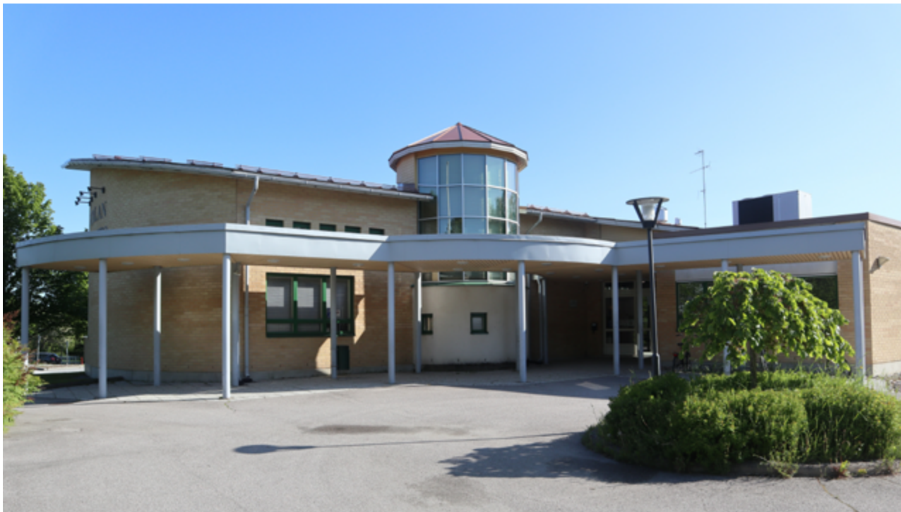
Kuva 1. Viialan kirjasto Vilkun pääjulkisivu.
