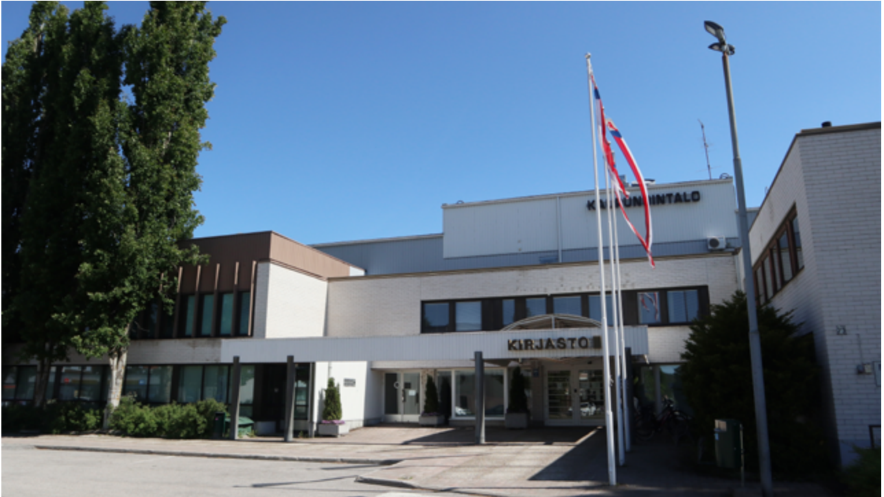
Kuva 1. Oriveden kaupungintalon pääjulkisivu Keskustien suunnasta. Käynti kirjastoon on kaupungintalon pääaulasta.
