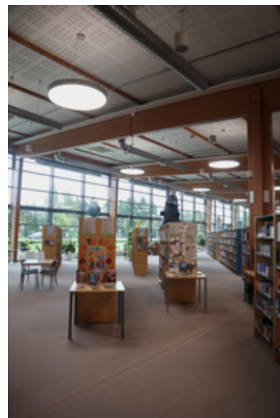
Kuva 12. Kirjastosalin hyllyt on asetettu vinottain julkisivuun nähden. Katon liimapuupalkit ja harmaat ilmanvaihtoputket erottuvat valkeasta alakatosta selkeinä.
