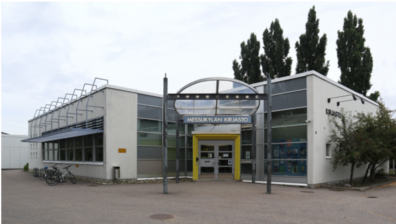
Kuva 1. Messukylän kirjaston pääsisäänkäynti kuvattuna kaakosta.
