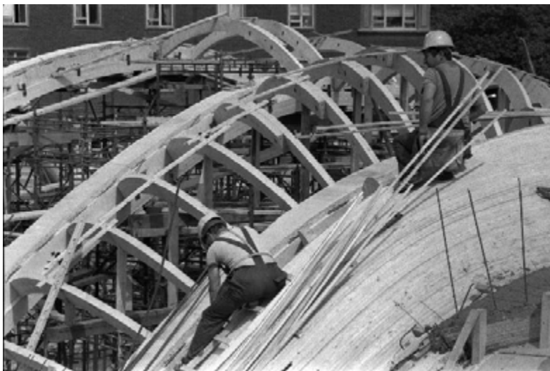
Kuva 9. Metson katon valumuotit. (Ikka Laitinen, Tampereen museot.)
