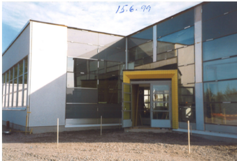
Kuva 5. Messukylän kirjastoa rakennetaan: sisäänkäynnin laatoitus on valmis kesäkuussa 1999. (Messukylän kirjaston arkisto.)
