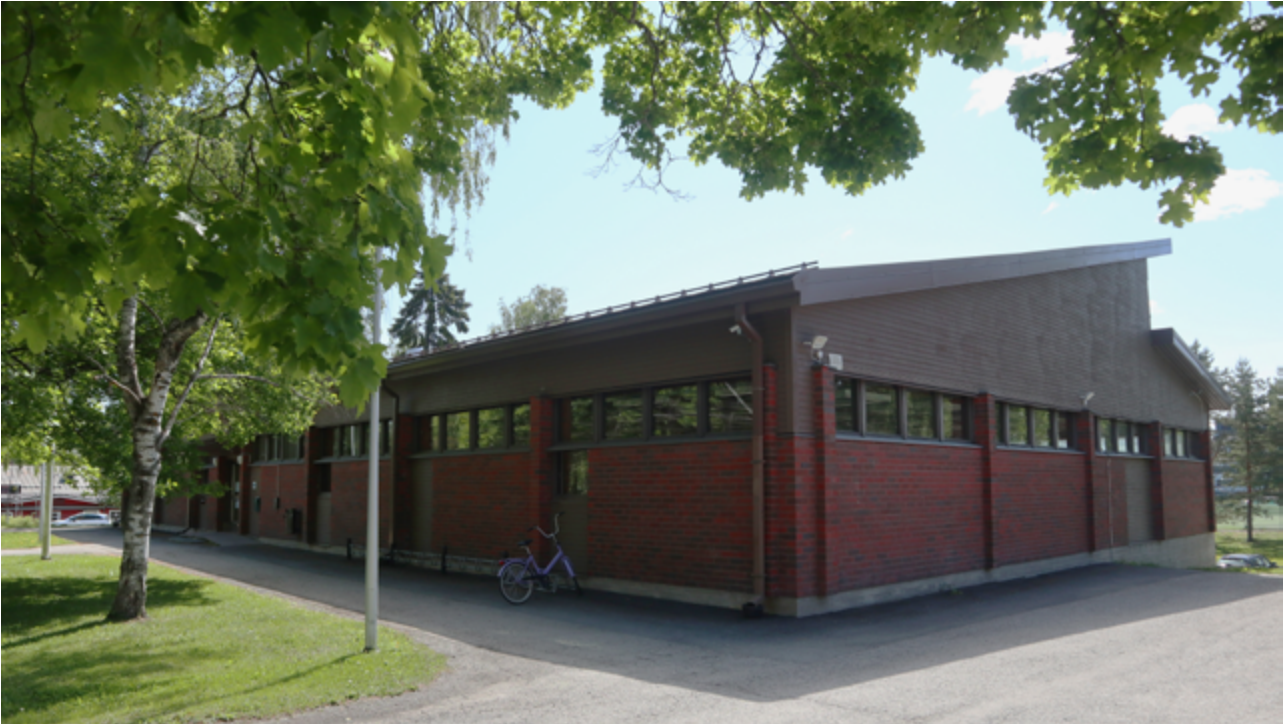
Kuva 1. Akaan pääkirjasto kuvattuna luoteispuolelta Köyvärintien suunnasta.
