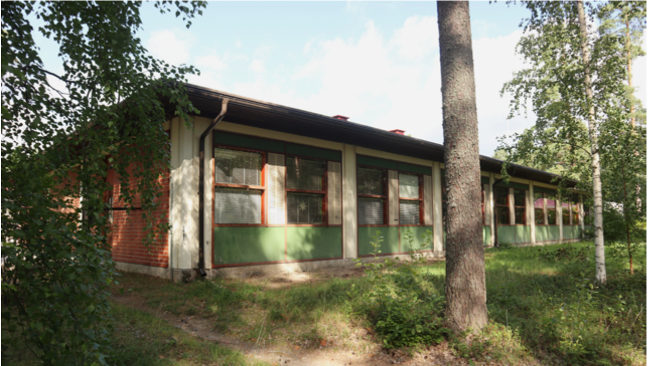
Kuva 1. Ruoveden kirjaston itäjulkisivu.
