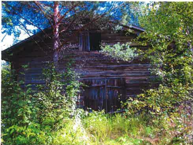
Luoteispääty ja sisäänkäynti
