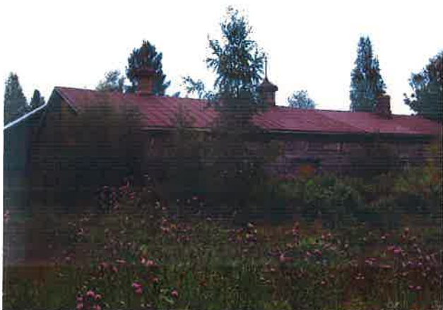
Etelästä, rakennuksen takaa
