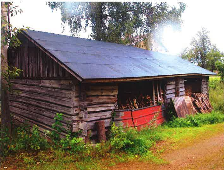
Pohjoisnurkalta, taustalla näkyy vanha päärakennus.
