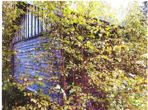
Pohjoisesta, riihelle menevältä tieltä katsoen.
