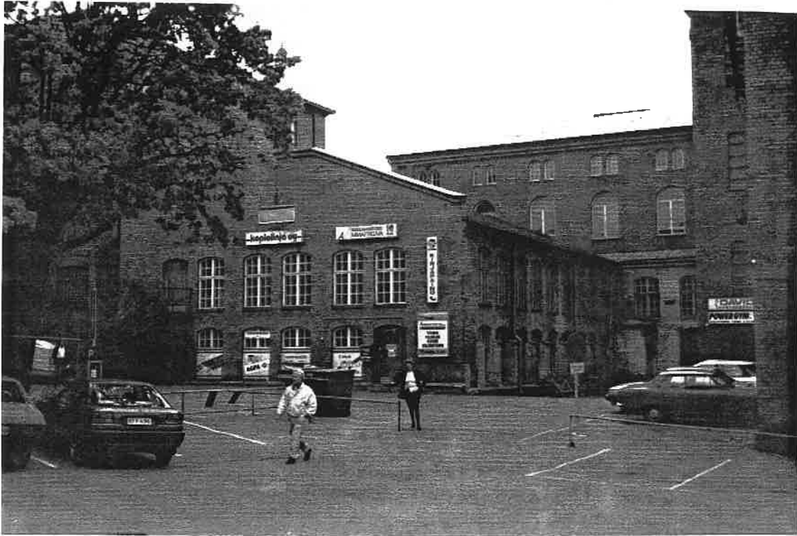
Kuva 55. TR 32 ja 33, ulkokuva
