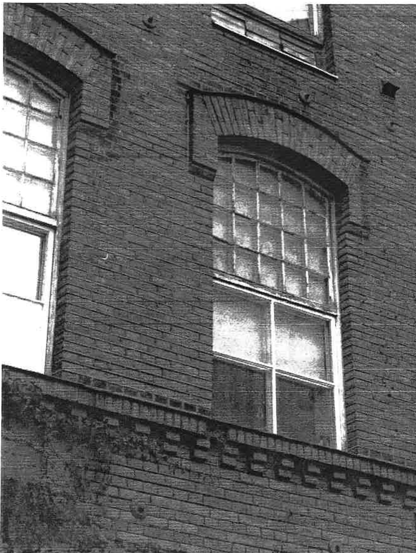
Kuva 85. Yksityiskohta TR 31 julkisivumuurauksesta
