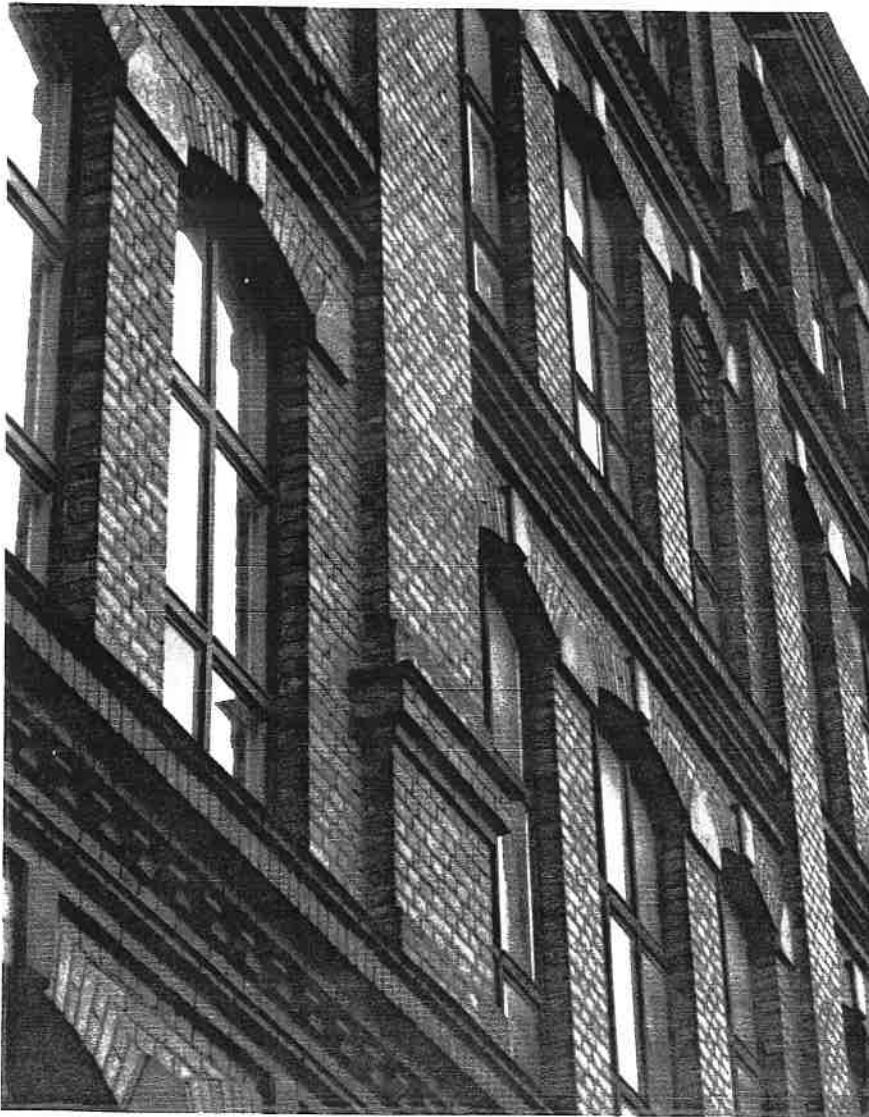
Kuva 93. TR 37, Siperia, julkisivumuurausta
