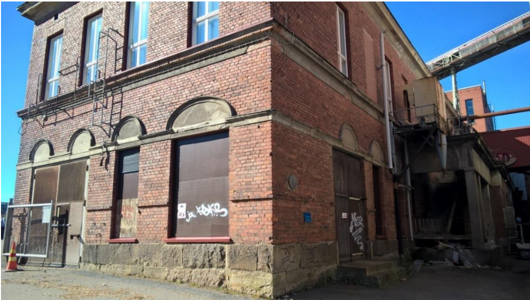
Verstasrakennuksen pääty oli keskeinen kohtaamispaikka tehdasalueella. Käynti keskusvarastolle ja pajaan alhaalta vasemmalta. Yläkerran puuverstaalle mentiin sivun betoniportaikkoa pitkin.
