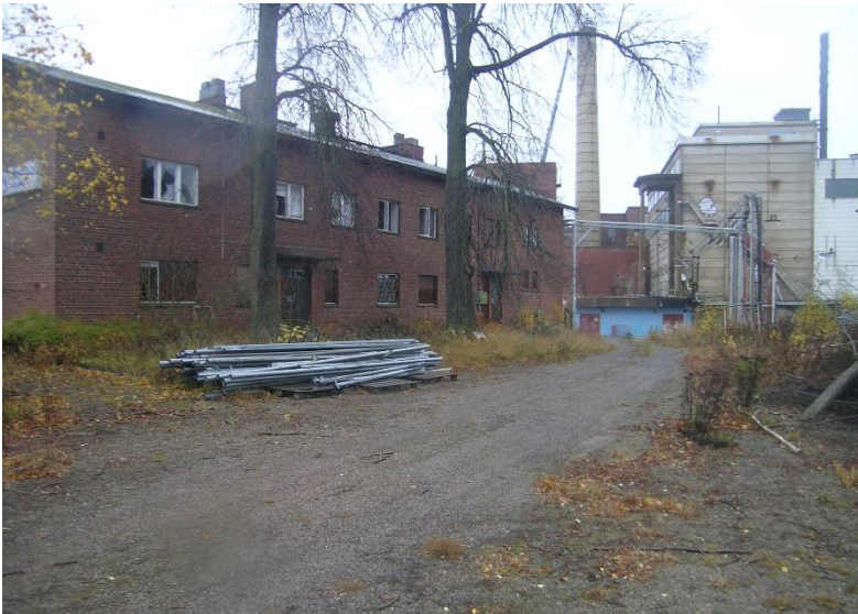
Rakennus toimi viimeksi lakkautetun ligniinitehtaan konttorina. Rakennus sijaitsee Lielahden keskiaikaisella kylätontin alueella. KUVA Sami Raninen/Vapriikin kuva-arkisto 2015.
