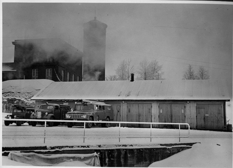
Vanha puurakenteinen paloasema hiukan ylempänä rinteessä, ilmeisesti nykyisen ruokalarakennuksen kupeessa. KUVA Reino Branthin 1964 /Vapriikin kuva-arkisto
