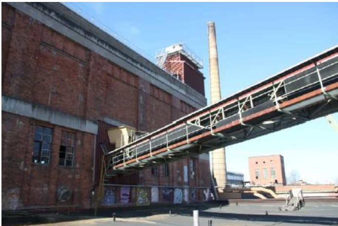
Mekaaniset, yläilmoissa kulkevat kuljettimet ovat tunnusomainen osa puunjalostustehtaan miljöötä. Lielahdessa on säilynyt keittämöstä hiertämöön kulkeva purukuljetin.
