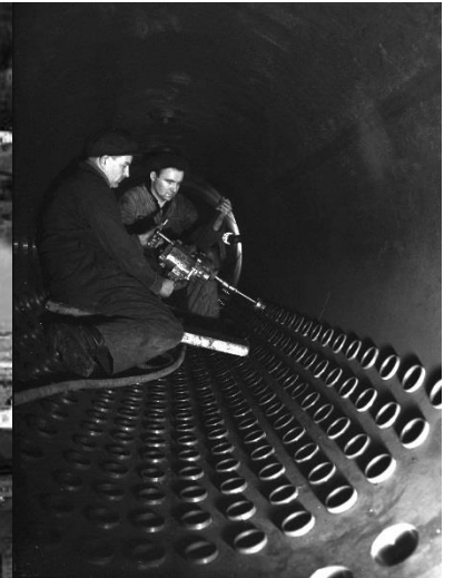
Voimalassa käytettiin Tampellan kattiloita. Tampellan asentajat voimalan laajennustyömaalla 1951. KUVA Veikko Kanninen/Vapriikin kuva-arkisto
