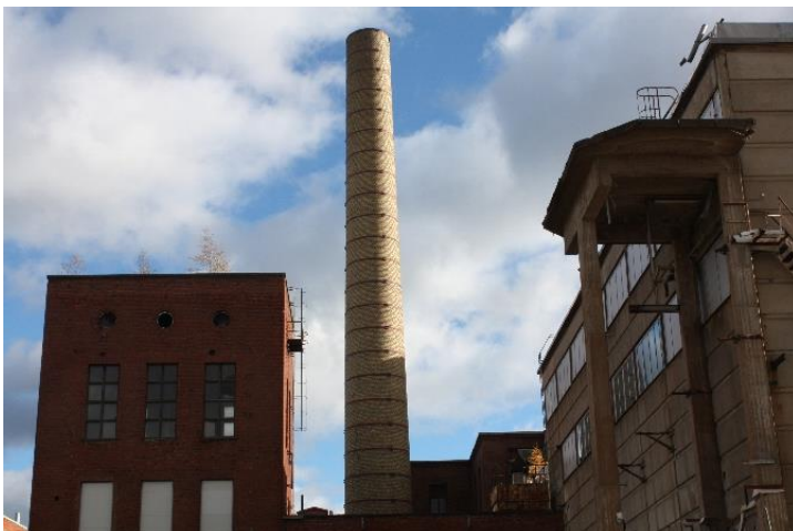
Näkymä etelästä. Vasemmalla spritehdas ja oikealla voimalaitos. Piippu kunnostettiin vuonna 2015. Rapautunutta yläosaa purettiin 23 metriä. KUVA Katja Vaulio
