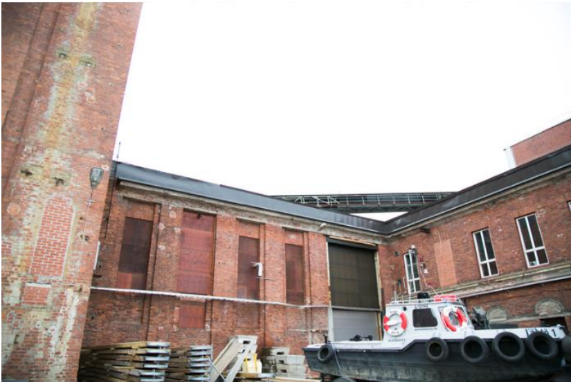
Käynti itäiseltä tehdaspihalta sihtiosastolle. Oviaukkoa on korotettu trukki liikenteen tarpeisiin. KUVA Tampereen kaupunki/ Väliaikainen Hiedanranta 2015
