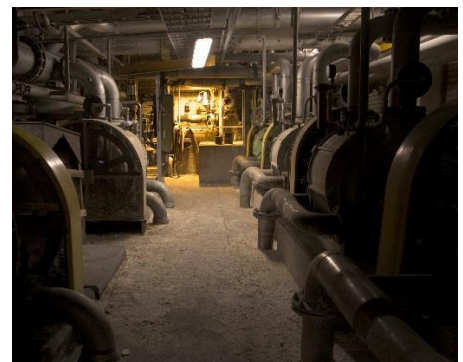
Kuivauskoneen alapuoliset imupumput ennen koneen purkamista 2008. KUVA Marika Tamminen/Vapriikin kuva-arkisto
