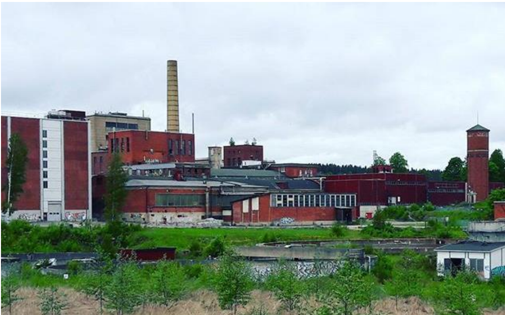
Hiertämö (vasemmalla) on tehtaan uudempaa rakennuskantaa, joka ei ehtinyt muuttua moneen otteeseen. Rakennus erottuu selkeänä kuutiona tehdasalueen pohjoisesta siluetista. KUVA Janne Nieminen
