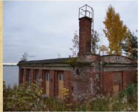
Pumppaamo syksyllä 2015. Sittenmin rakennuksen huonokuntoinen piippu on purettu. KUVA Kirsi Niukko/Kulttuuriympäristöpalvelut Heiskanen & Luoto
