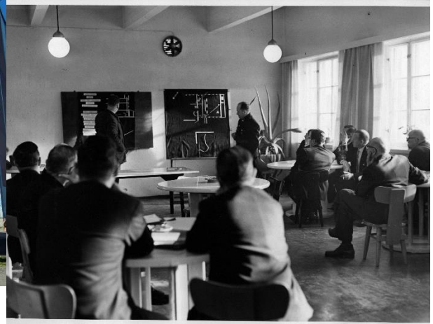
Paloharjoituksen jälkipuintia rakennuksen yläkerrassa 1963. KUVA Vapriikin kuva-arkisto
