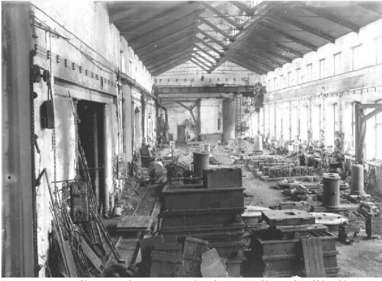
Purettu valimorakennus sisältä. Valimohalli oli yhtä suurta työtilaa, ja lattia hiekan peitossa.
