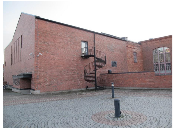
Museokeskuksen takajulkisivua valimon kohdalta Vasemmalta alkaen saneerauksenaikaista tiilimurausta, pala 1800-luvun seinää ja 1920-luvun ikkunaseinä.
