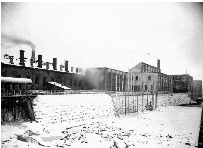
Rakennustyömaa 1927. Vasemmalla pajarakennus piippuineen.
