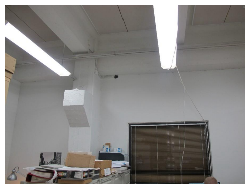
Kokoelmatyöhuoneen seinäpalkissa on uloke nosturikiskoa varten.
