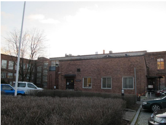
Kuva-arkiston 1960-luvulla saneerattu rakennusosa sulautuu vanhempaan tiilipintaan ja ympäröiviin muotoihin.
