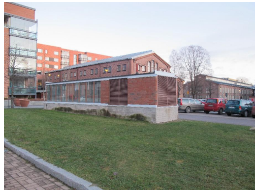
Vapriikin takapihaa. Etualalla museokeskuksen saneerauksessa rakennettu uloskäynti johtaa puretun valimorakennuksen alaiseen kellariin (rakennus 108).
