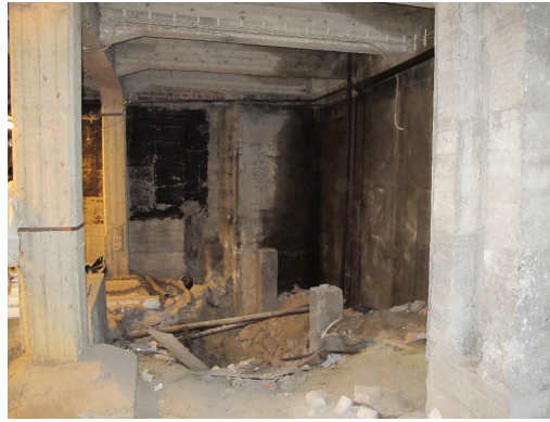
Betonirakenteita kosken puolella.
