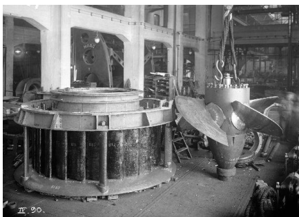
Kaplan-turbiinin juoksupyörä (oik.) Karhulan voimalaitokselle. Kuva rakennusosasta W13.
