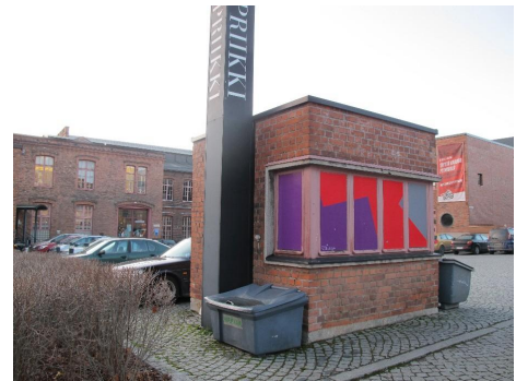
Konepajan oma portinvartijankoppi rakennettiin kesällä 1939.
