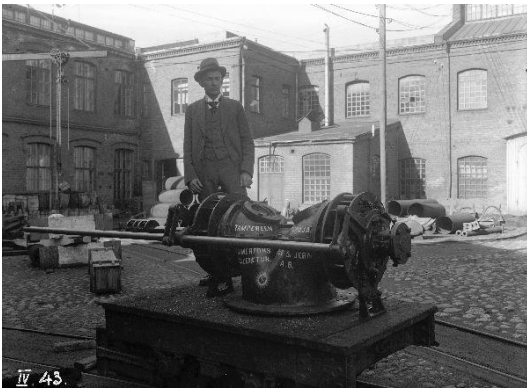
Näkymä nykyiseltä Veturiaukiolta pääsisäänkäynnille, ennen 103:n rakentamista. Etualalla Pohjankartanon voimalaan valmistettu kaksoisturbiini. 1910- /1920-luku.
