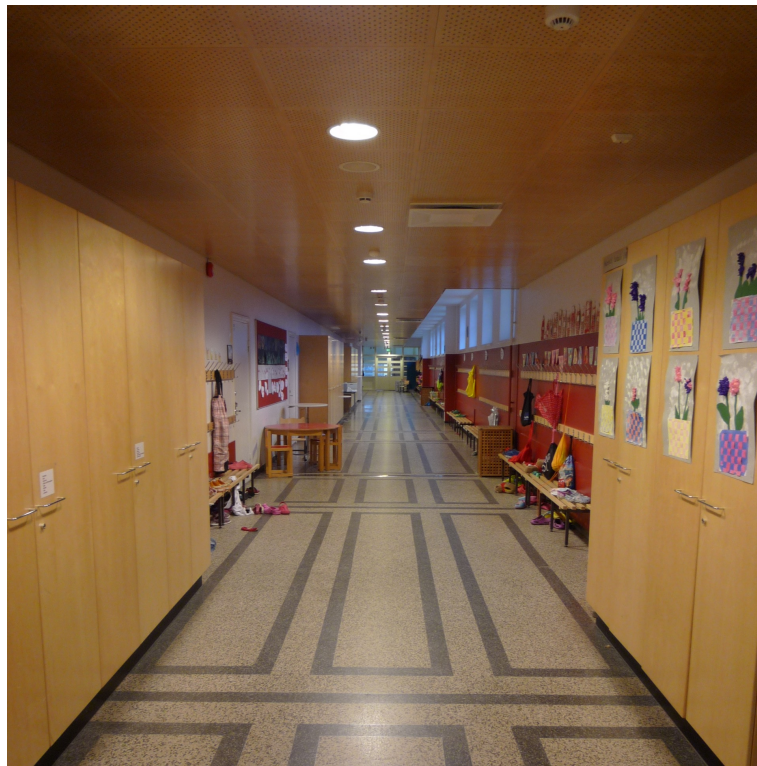
Luokkahuoneisiin johtava käytävä 2. kerroksessa. Mosaiikkibetonilattia 1950-luvulta, viilupintainen alakatto 2000-luvulta.
