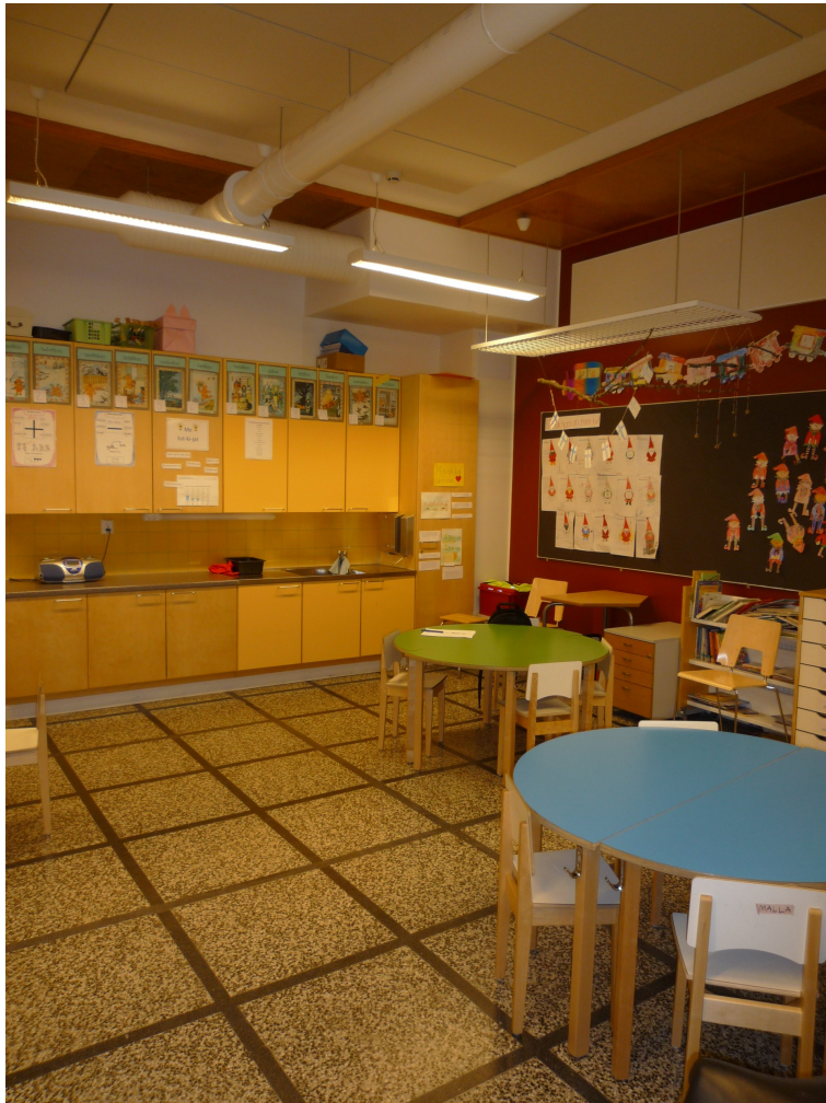
3. kerroksen luokkahuone. Tilassa ollut alun perin lääkärin, hammaslääkärin ja terveydenhoitajan tilat. Mosaiikkibetonilattia 1930-luvulta.
