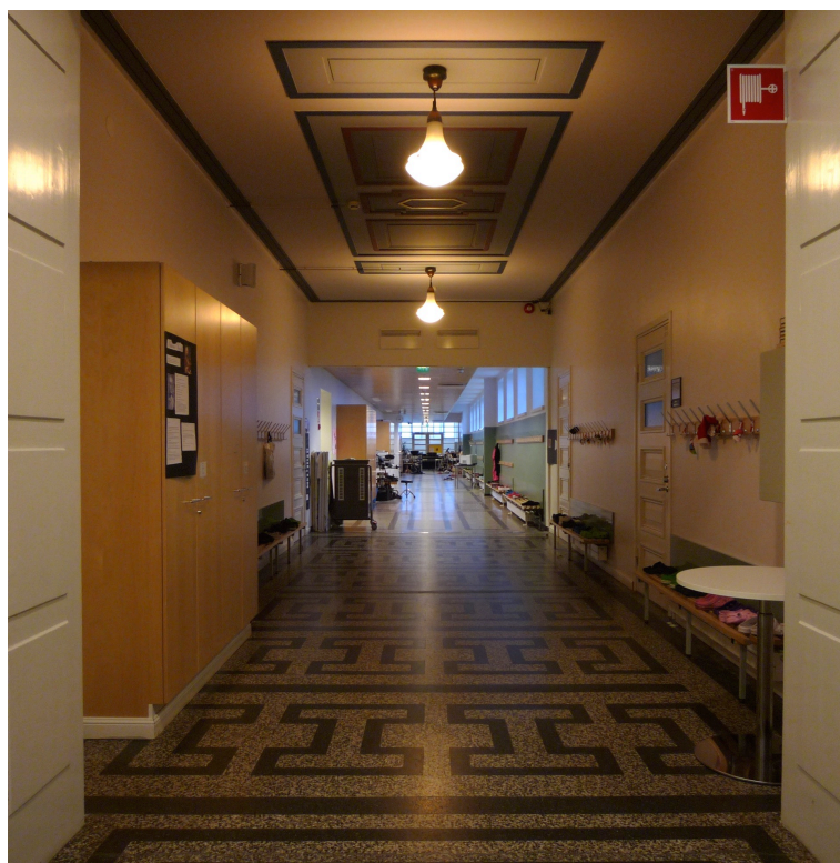
Luokkahuoneisiin johtava käytävä 3. kerroksessa. Etuosa 1930-luvulta, mosaiikkibetonilattia ja kattokasetointi sekä valkoiseksi maalatut peiliovet alkuperäiset. Taka-alalla 1950-luvun laajennus.
