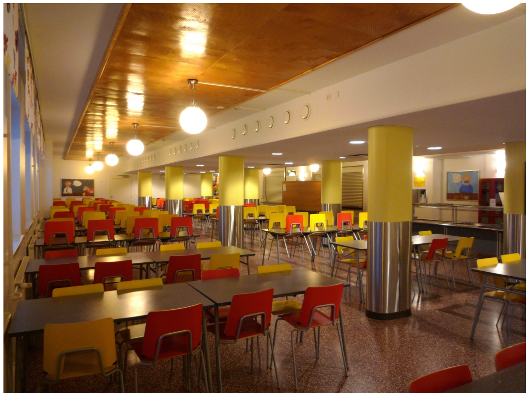
1. kerroksen ruokasali. Mosaiikkibetonilattia ja katon vaneripintaiset akustointilevyt alkuperäiset 1950-luvulta. Pilareiden välinen alaslasku 2000-luvulta.
