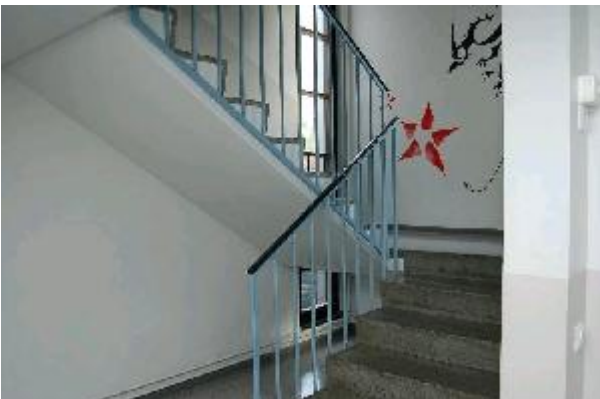
Sisäkuva kantasairaalan Y-rakennuksen porraskäytävästä. 25.9.2006, Minna Halonen.
