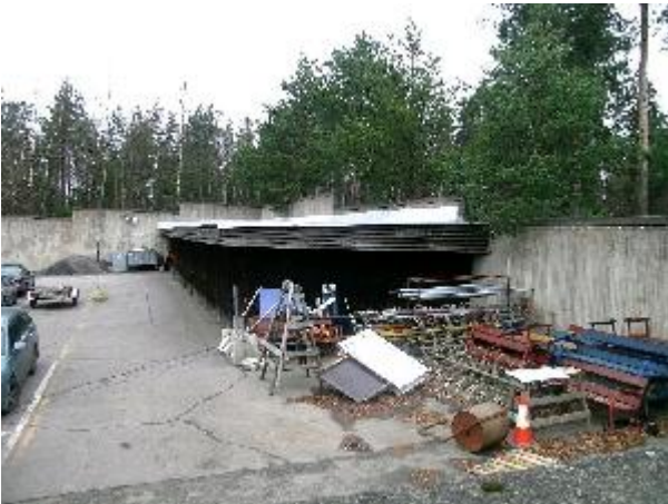
Kantasairaalan G-rakennuksen pihaa, betonimuureja ja varastorakennus kaakosta. 4.11.2008, Miia Hinnerichsen.
