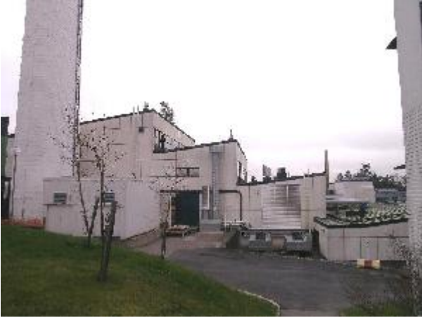
Tays:n kantasairaalan G-rakennus, voimalaitos luoteesta. 4.11.2008, Miia Hinnerichsen.
