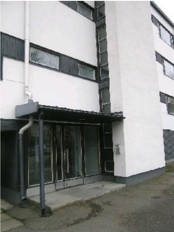
Kantasairaalan Y-rakennuksen E-rapun porraskäytävän ovi ja julkisivun materiaaleja. 4.11.2008, Miia Hinnerichsen.
