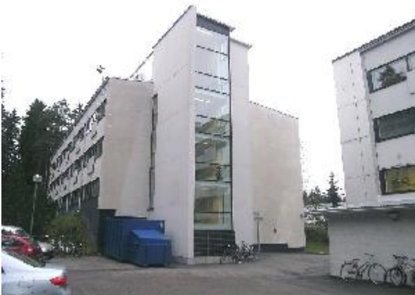
Kantasairaalan Z3-rakennuksen lounaispäädyn uusi porrashuone. 4.11.2008, Miia Hinnerichsen.
