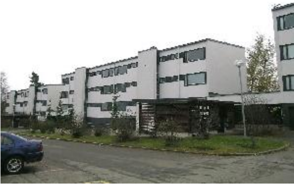
Kantasairaalan Y-rakennuksen koillissivua. 4.11.2008, Miia Hinnerichsen.
