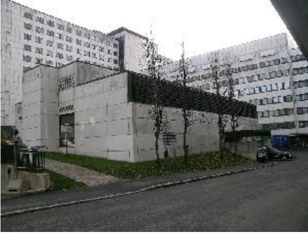
Tays:n kantasairaalan O-rakennus, obduktiorakennus pohjoisesta. 30.10.2008, Miia Hinnerichsen.
