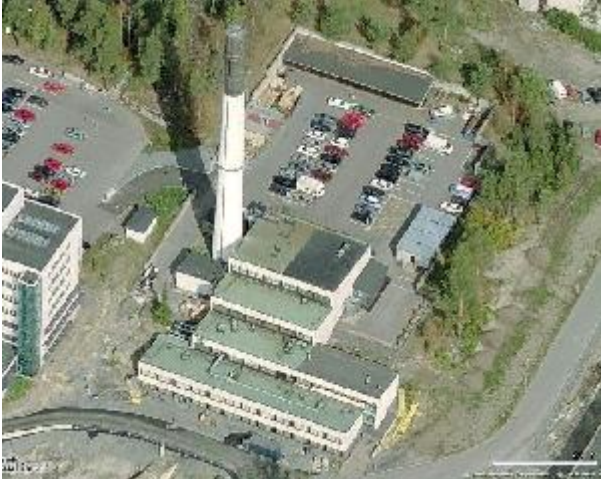
Viistoilmakuva kantasairaalan G-rakennuksesta etelästä (2006). Kuva: Microsoft Live Search Maps.
