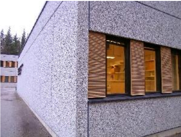
Hoito- ja terveystieteen laitoksen ikkuna ja julkisivumateriaaleja. 4.11.2008, Miia Hinnerichsen.
