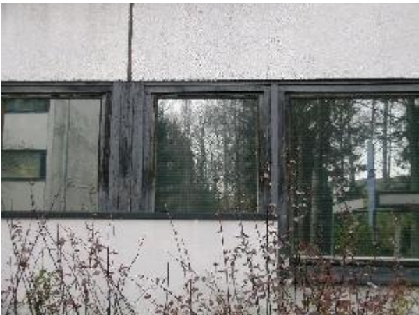
Kantasairaalan Z-rakennusten ikkuna ja julkisivu materiaaleja. Kuvassa Z4-rakennusta. 4.11.2008, Miia Hinnerichsen.
