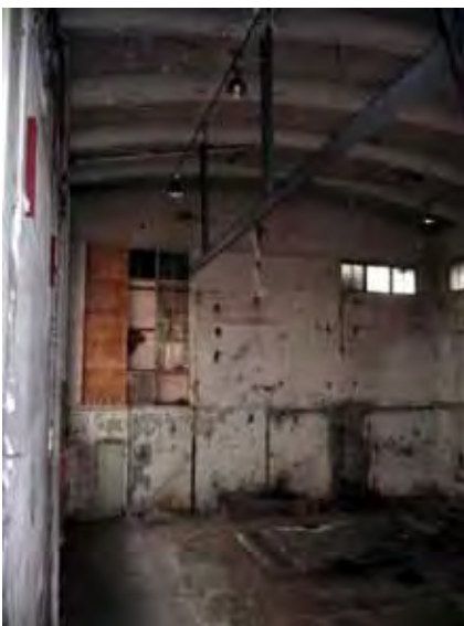
Pannuhuone sisältä nykyasussaan, lämpökattilat on poistettu
