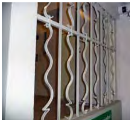
Pohjoissiiven porrashuoneen koristeellinen suojakaide 1930-luvulta
