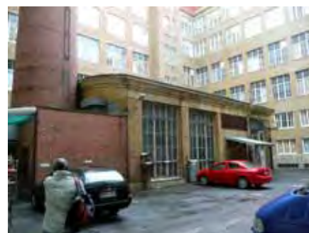
Ylempi kuva: pannuhuoneen itäsiivu ja porttikäytävä Satamakadulle
