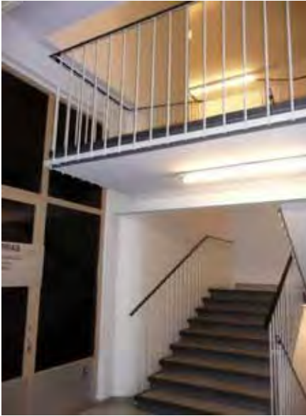
Pohjoissiiven länsipäädyn portaikko, joka 1960-luvulla oli avoportaitko sosiaalivirastotalon pääaulan yhteydessä.
