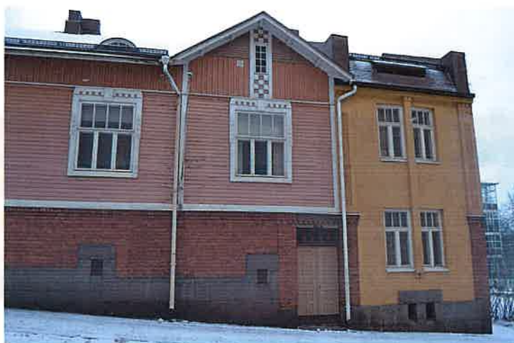
Tiilirunkoinen pääty eroaa väreiltään ja materiaaleiltaan puisesta, mutta mitoitus ja yksityiskohdat ovat sopusoinnussa.
