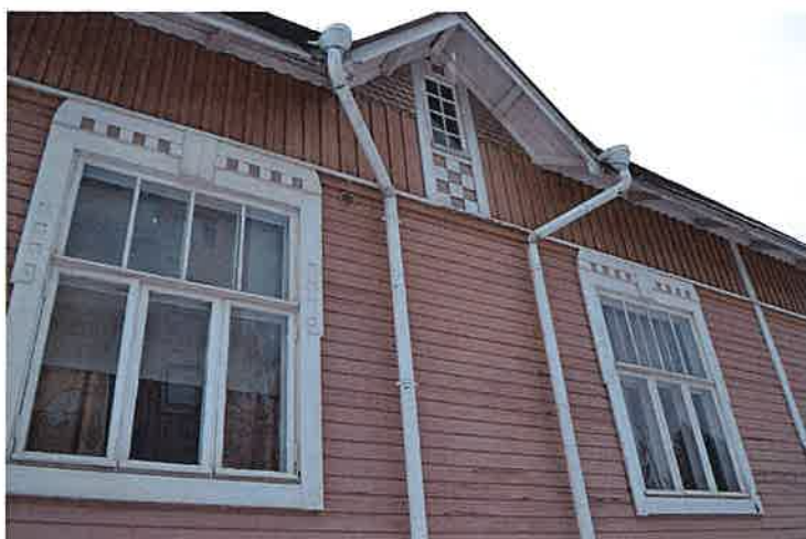
Yksityiskohtia julkisivusta: ruutuaihe, paanulaudoitus ja pyöristetyt ikkunapuitteiden kulmat.
