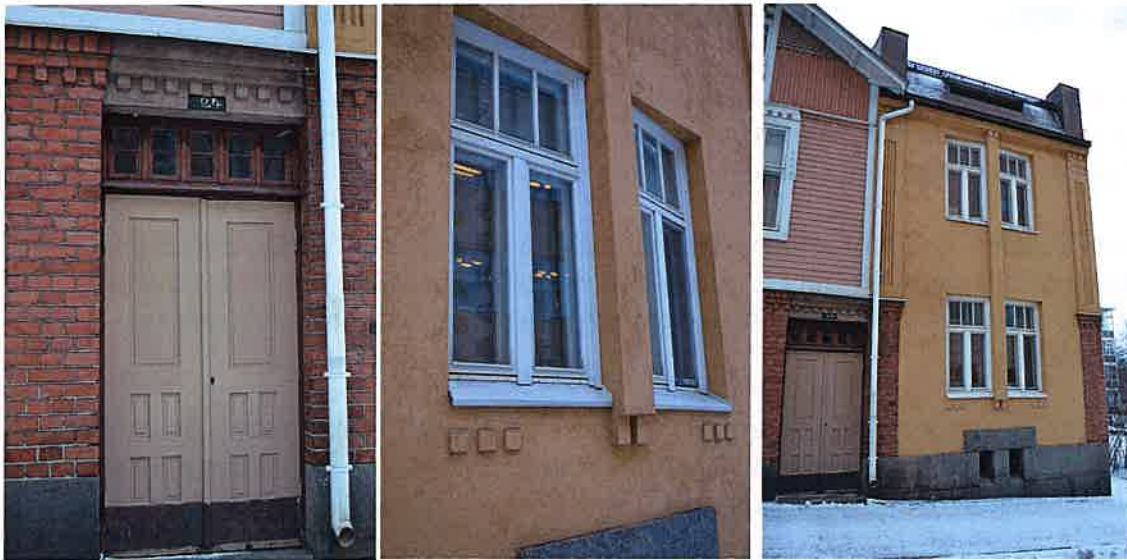
Yksityiskohtia puu- ja kiviosasta. Ruutuaihe toistuu eri materiaaleissa. Kiviosan ikkunat ovat hienovaraisesti viistotut. Kiviosan ikkunat on uusittu, puuosassa alkuperäiset.
