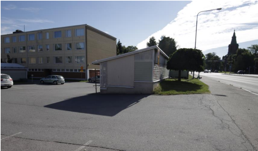
Kuva 69. Pihaliittymä TOAS:n kortteliin liikerakennuksen kaakkoispuolelta. Etualalla katua ja pihaa erottava autokatos.
