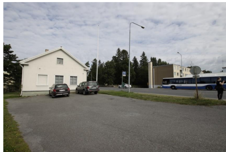
Kuva 75. Messukylän entinen kunnantalo ja sen kaakkoispuolinen pysäköintialue. Pysäköintialue erottaa kadusta vain kapea nurmikaistale.
