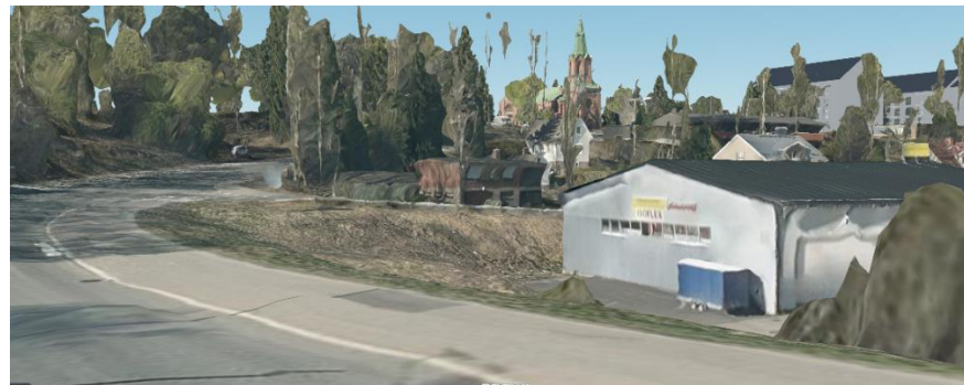
Kuva 109. Puusto peittää todennäköisesti näkymiä Ristinarkuntien sillalta etelään. xD Twin (Tampereen kaupunki) mallin ote.
