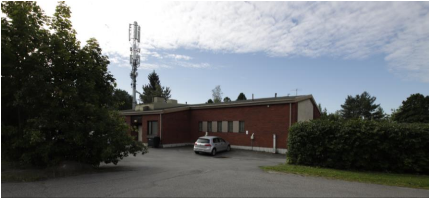
Kuva 38. Vuonna 1959 Messukylänkadun eteläpuolelle valmistunut rakennus.
