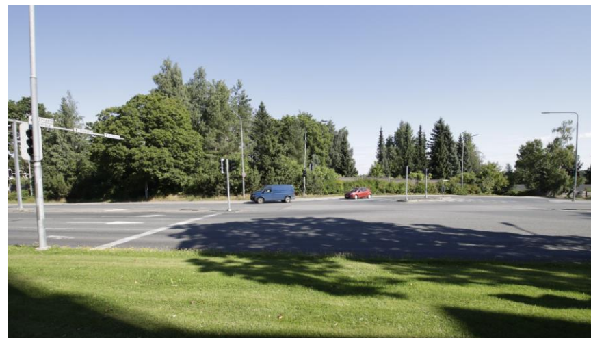
Kuva 73. Yksikerroksinen päiväkotirakennus jää Messukylän uuden kirkon edestä katsottuna meluvallin ja kasvillisuuden taakse näkymättömiin.
