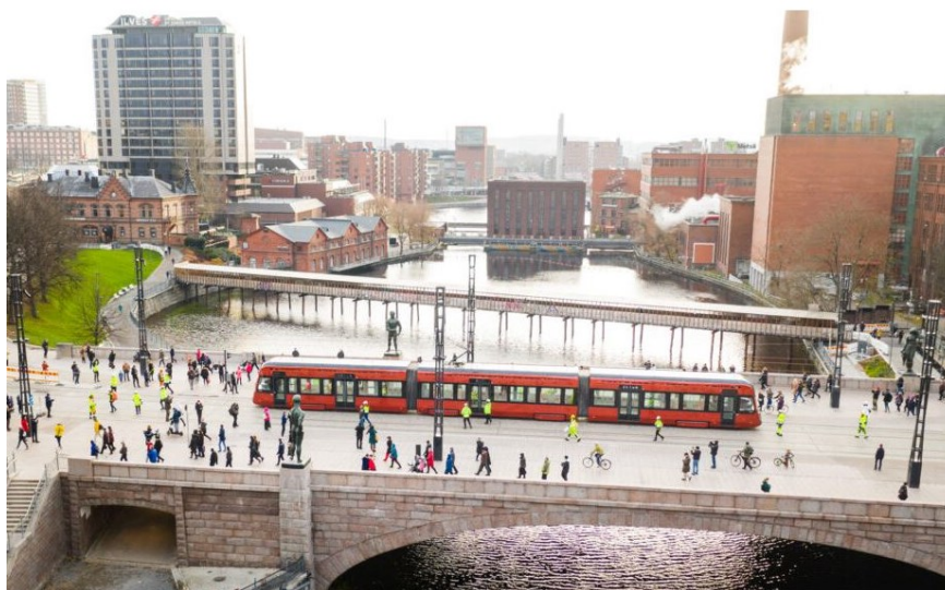
Kuva 72. Värjärinkujan väliaikainen silta, käytössä 2018–2021.
