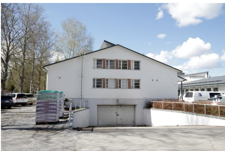
Kuva 190. 1950-luvun varastorakennuksen itäpääty on säilyttänyt alkuperäisen asunsa.
