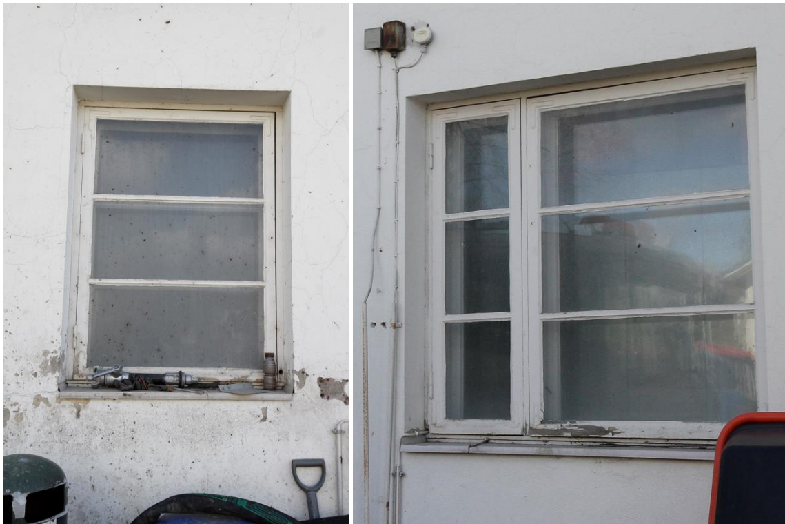
Kuva 186 (vasemmalla). Kuvassa on konekorjaamon pohjoisjulkisivulla oleva alkuperäinen ikkuna.
