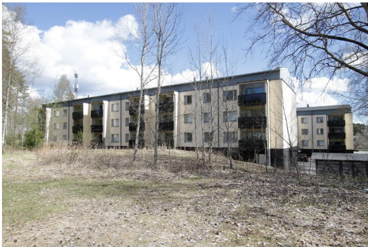
Kuva 204. Kohteen lamellitalojen länsijulkisivut ja eteläpäädyt.
