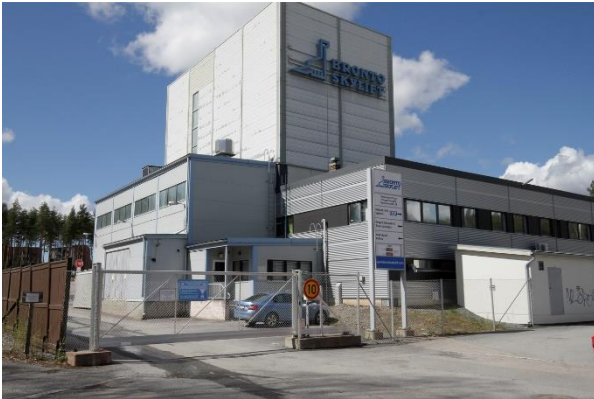
Kuva 90. Kohteen päärakennuksen etelä- ja itäjulkisivua Teerivuorenkadun päässä.
