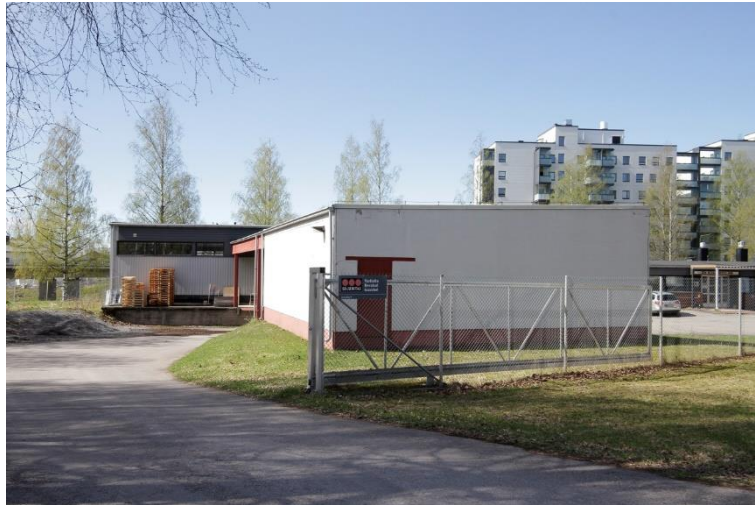
Kuva 148. Rakennuksen eteläpuolen pääty yhdistyy katoksella varasto- ja lastausalueeseen.
