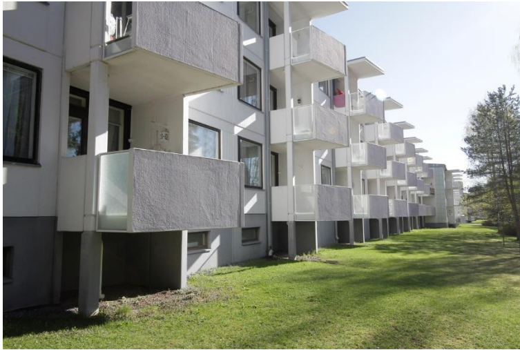
Kuva 126. Lamellitalojen parvekkeet on maalattu ja uusittu 2000-luvulla. Alkujaan parvekkeet eivät ole olleet yhtä syviä ja niiden etureuna on ollut seinän suuntainen. Sirojen rakenteiden ansiosta uudet parvekkeet sopivat kuitenkin hyvin rakennusten hahmoihin.
