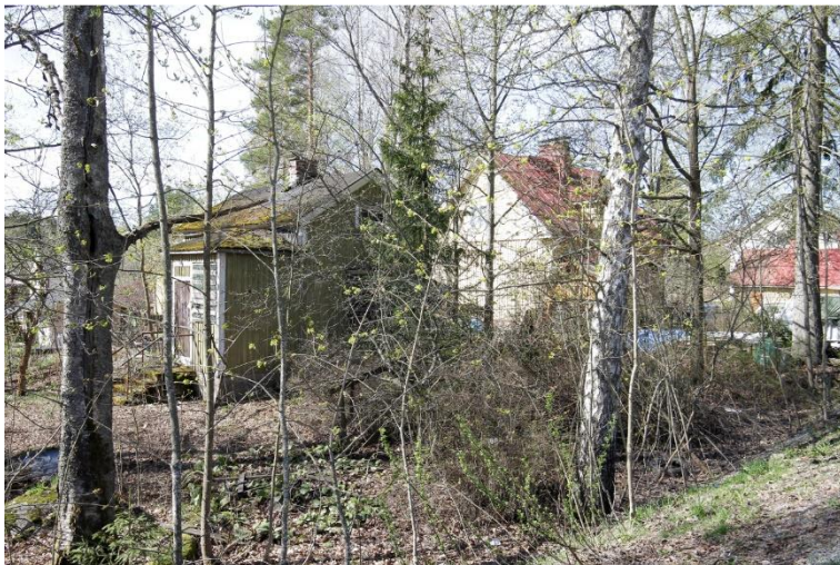
Kuva 219. Kuvassa etualalla Imarteenkuja 5:n pieni asuinrakennus. Rakennus on tyhjillään ja heikossa kunnossa. Se on valmistunut 1930-luvulla ja on pitkälti alkuperäisessä asussaan. Sen takana näkyvä suurempi puolitoistakerroksinen asuinrakennus on myös 1930-luvulta.
