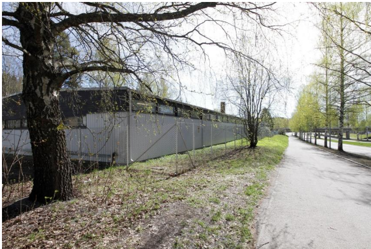
Kuva 145. Rakennus kuvattuna Tesoman valtatie puolelta kohti kaakkoa.
