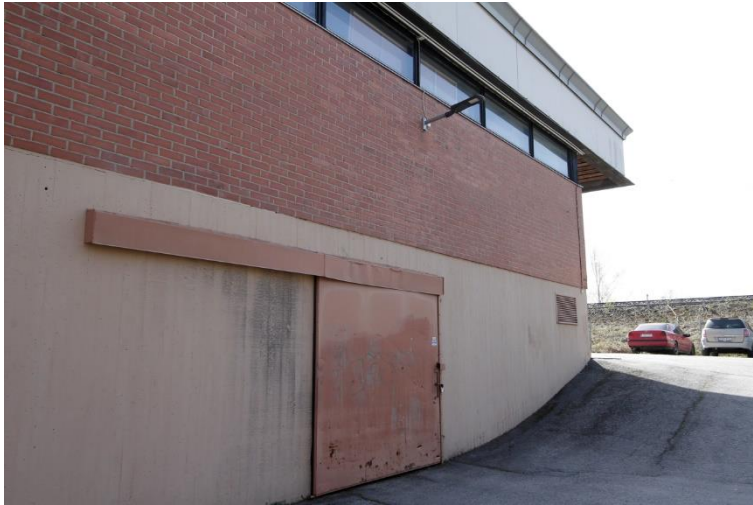
Kuva 166. Liukuovi kohteen länsipäädystä kellaritiloihin. Ovi vaikuttaa alkuperäiseltä. Levymäinen katto leijuu seinien yläosassa olevien nauhaikkunoiden päällä. Kuvan oikeassa reunassa näkyy ratapenger.
