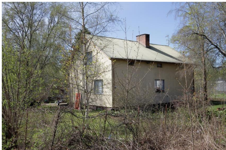
Kuva 156. Kohteen itä- ja pohjoisjulkisivut. Pohjoisjulkisivulla oleva ajoliuska kellarikerrokseen ei nykyisin juurikaan näy kasvillisuuden takia.
