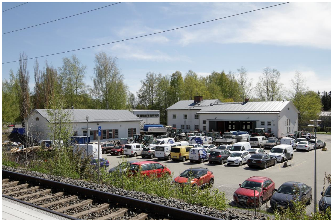
Kuva 172. Kohteessa oleva entinen konekorjaamo ja hitsaamo kuvattuna kohteen pohjoispuolelta junaradan henkilöliikenteen seisakkeelta.
