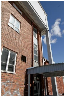
Kuva 11. Entisen Makkarakolmion vanhimman osan pääsisäänkäynti toimii nykyisin liikuntakeskuksen pääsisäänkäyntinä.
