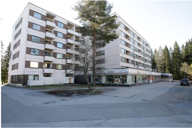
Kuva 114. Kohteen itäpäässä oleva korkea kerrostalo kuvattuna luoteispuolelta. Ensimmäisessä kerroksessa on liiketiloja ja se hahmottuu muusta julkisivusta ulkonevana rakennusmassana rakennuksen länsiseinustalla.
