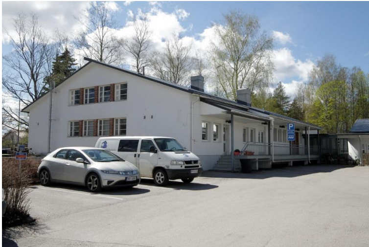
Kuva 181. 1950-luvulla valmistunut varistorakennus pihalta nähtynä. Kuvassa näkyy rakennuksen itäpääty ja pohjoisjulkisivu. Laajennusosa jää kuva-alan oikealle puolelle.
