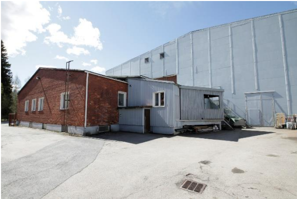
Kuva 42. Etualalla vuoden 1965 makkaratehtaan laajennus. Taustalla näkyvä peltivuorattu rakennusosa on 2000-luvun taitteen liikuntahallia.
