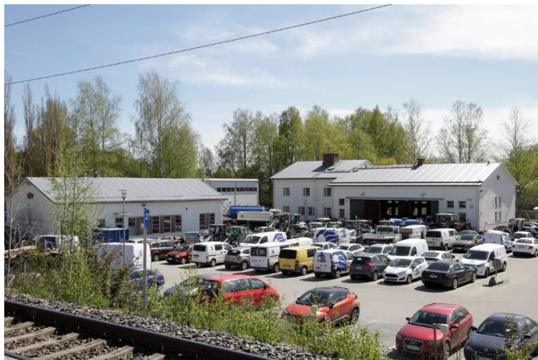
Kuva 9. Maataloushallituksen insinööriosaston konekorjaamo asuntosiipineen ja hitsaamo radan ja nykyisen Kokkolankadun välissä. Valkoiseksi rapatut rakennukset ovat 1950-luvulta.
