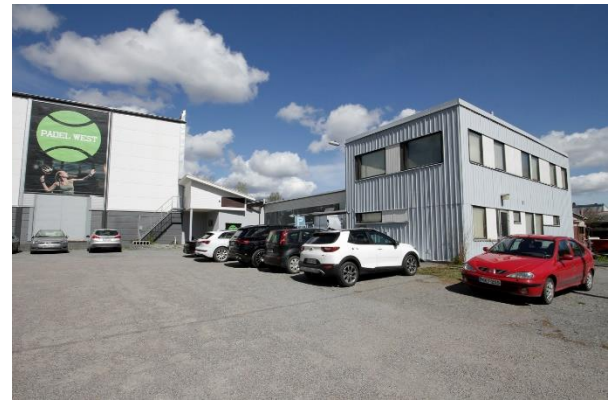
Kuva 76. Kohteen eteläjulkisivua. Vasemmalla näkyy uusi liikuntahalli, oikealla entistä teollisuusrakennusta.
