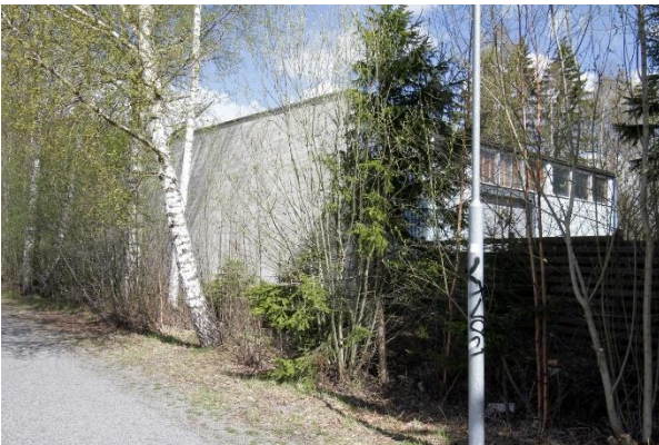
Kuva 81. Tontin takaosassa oleva varastorakennus.
