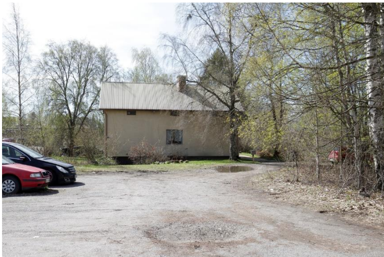
Kuva 151. Kohteen pohjoisjulkisivu. Kohteen ja Kohmankaaren välissä on pysäköintiin käytetty hiekkakenttä.
