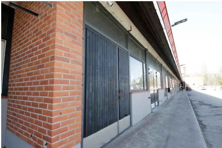
Kuva 169. Pohjoisjulkisivulla oleva alkuperäinen puuvorattu pariovi.
