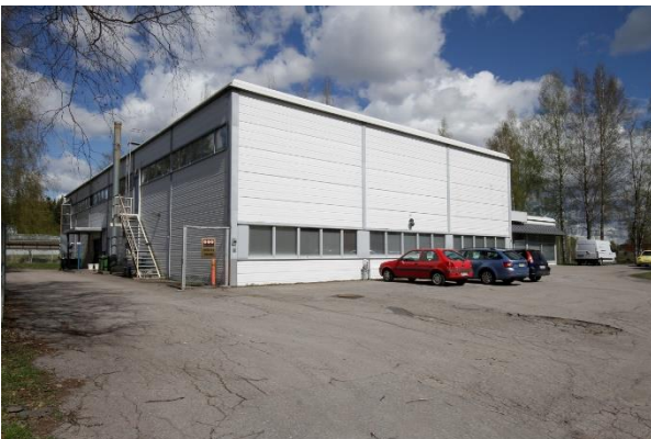
Kuva 39. Kohteen varasto-osan julkisivu Kokkolankadulle.
