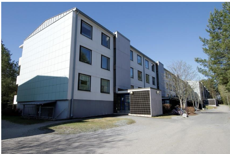
Kuva 125. Lamellitaloihin on lisätty tuulikaapit 1990-luvulla sisäänkäyntien yhteyteen ja päädyt on lisälämmöneristetty. Lisälämmöneristyksen takia päädyt ulkonevat katon harjakolmiosta. Muutoin rakennukset ovat alkuperäisessä hahmossaan.
