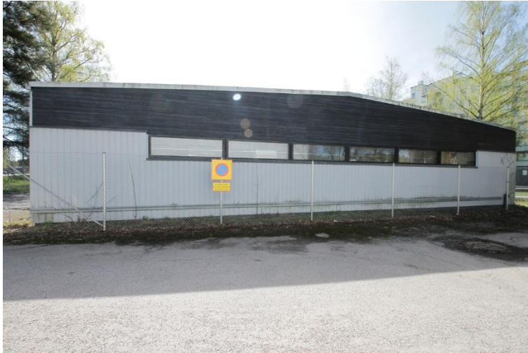
Kuva 144. Rakennuksen pohjoispuolen päätyjulkisivu.
