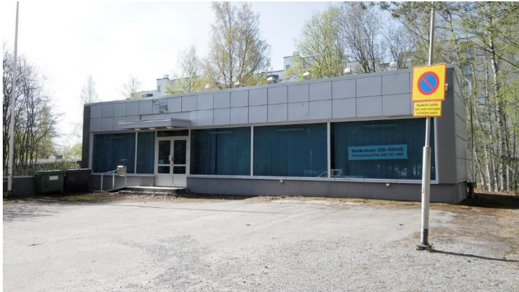
Kuva 134. Kohteen sisäänkäynti Kohmankaarelta. Julkisivua hallitsee suuret ikkunat.
