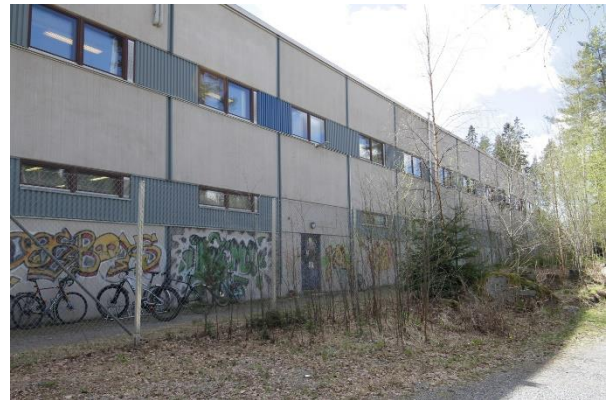
Kuva 94. Kohteessa olevan erillisen teollisuusrakennuksen pohjoisjulkisivu radanvarren kävelytieltä kuvattuna.
