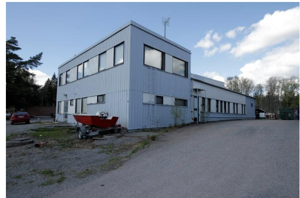
Kuva 75. Kohteen etelä- ja itäjulkisivu.
