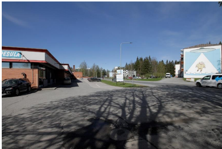
Kuva 170. Näkymä kohteen itäisemmästä tonttiliittymästä länteen Kohmankaarta pitkin. Kohteen teollisuushallin pitkä julkisivu reunustaa Kohmankaaren katunäkymää, vaikka kadun ja rakennuksen välissä onkin pysäköintialue. Kohmankaaren sisäkaarteessa kohteen pohjoispuolella on viuhkamaisesti sijoitettuja lamellikerrostaloja. Rakennusten päädyissä on Fingerpori-sarjakuva-aiheiset muraalit.
