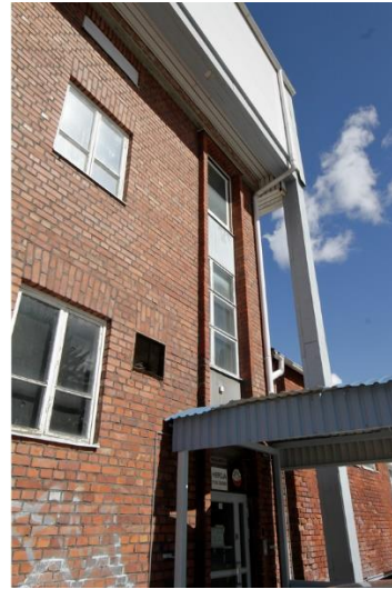
Kuva 45. Makkaratehtaan vanhassa osassa sisäänkäyntiä ja sen yhteydessä olevaa portaikkoa on korostettu julkisivussa korkealla tiilimuurauksen kehystämällä ikkunalla.
