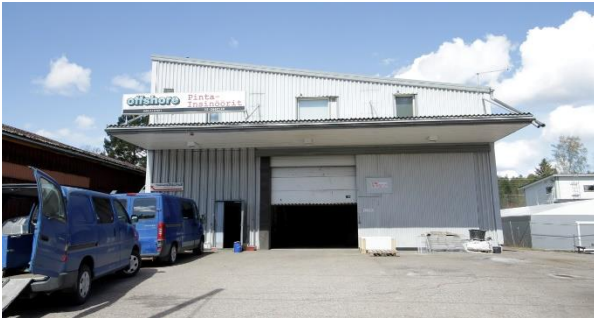
Kuva 60. Kohteessa olevan uudemman varastohallin eteläjulkisivu.
