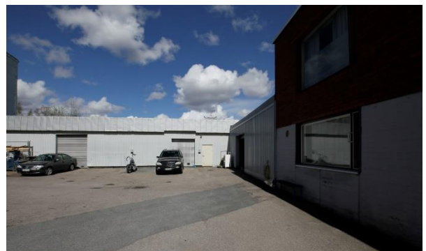
Kuva 47. Liikuntakeskuksen sisäpiha. Oikealla näkyy asuinrakennuksen länsijulkisivu.
