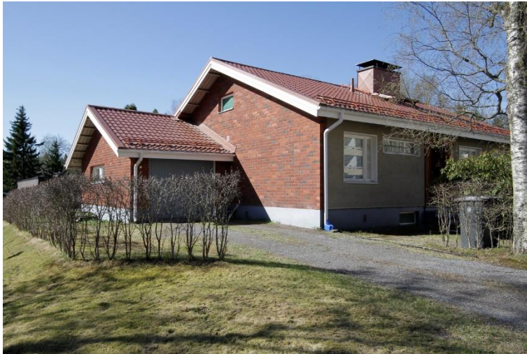
Kuva 228. Ristimäenkatu 27 (Keltanokuja 2) on tyypillinen 1960-luvun erillispientalo, jossa on yksi asunto yhdessä kerroksessa, loiva harjakatto ja autotalli omassa siivessä. Rakennuksen pitkät julkisivut ovat rapatut, päädyt ovat puhtaaksi muurattua punatiiltä.
