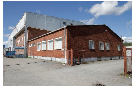
Kuva 41. Etualalla vuoden 1965 makkaratehtaan laajennus. Taustalla näkyy makkaratehtaan alkuperäinen rakennusosa, jota korotettiin vuonna 1960. Peltivuorattu rakennusosa on 2000-luvun taitteen liikuntahallia.
