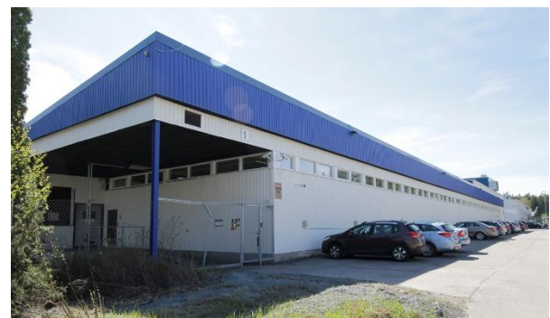
Kuva 109. Kohteen julkisivu Teerivuorenkadulle.
