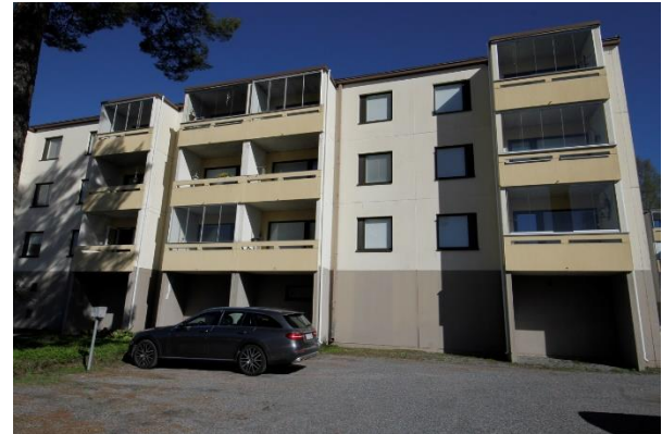
Kuva 33. Eteläisemmän lamellitalon eteläjulkisivu.
