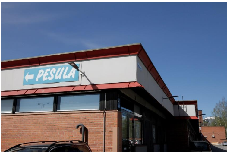
Kuva 167. Kohteen itäpäättyä ja pohjoisjulkisivua. Levymäinen katto leijuu seinien yläosassa olevien nauhaikkunoiden päällä.
