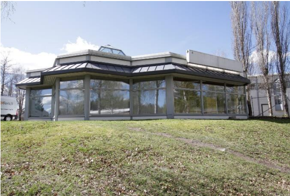
Kuva 38. Kohteen julkisivu Tesoman valtatie suuntaan.
