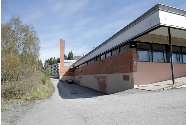
Kuva 164. Kohteen länsijulkisivu ja eteläjulkisivun lastauslaituria. Siipiosassa oleva keskuslämmityksen savupiippu näkyy hyvin radalle. Kohteen takaa näkyy Kohmankaaren varrella viuhkamaisesti olevia lamellitaloja.
