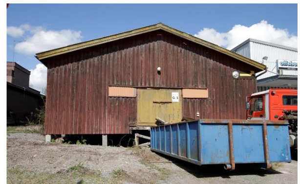
Kuva 59. Kohteessa olevan puuvuoratun kylmän varastohallin eteläjulkisivu.
