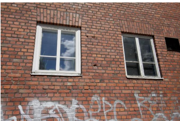
Kuva 44. Makkaratehtaan vanhassa osassa ikkuna-aukot on tiiliholvattu.
