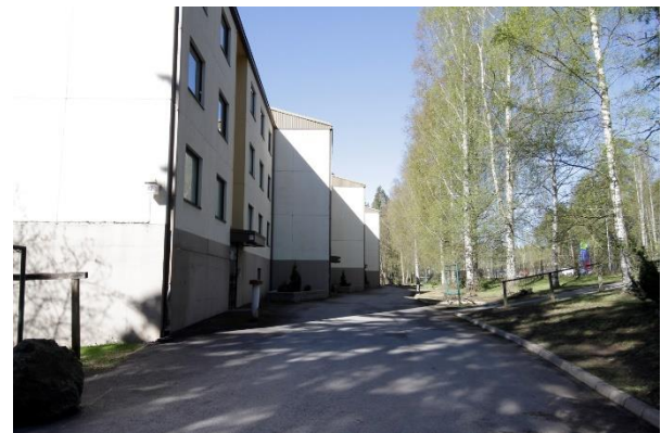
Kuva 35. Pohjoisemman lamellitalon pohjoisjulkisivu.
