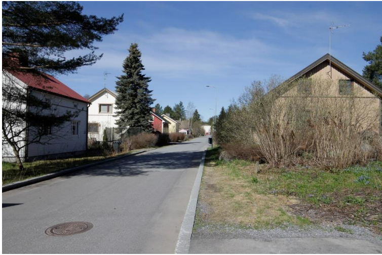
Kuva 226. Kuvassa vasemmalla Ristimäenkatu 3 ja sen takaa näkyy Ristimäenkatu 5. Ne ovat valmistuneet vuosina 1939 ja 1954. Hahmoltaan rakennukset ovat hyvin samanlaiset. Kuvan oikeassa reunassa näkyy Ristimäenkatu 12 (eli Tervakonkuja 2). Se on valmistunut vuonna 1942.
