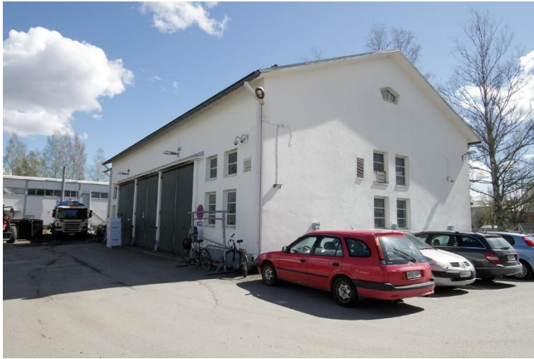
Kuva 185. 1950-luvulla valmistunut hitsaamo nähtynä kohteen pihalta. Kuvassa näkyy rakennuksen länsijulkisivu ja eteläpäätty.
