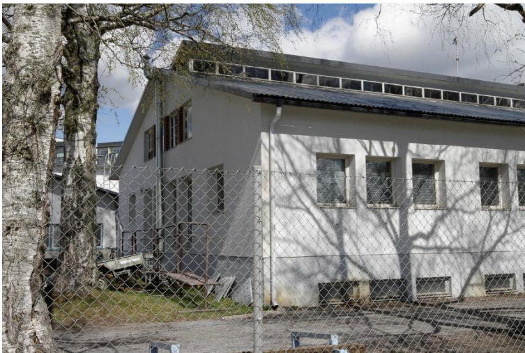
Kuva 189. 1950-luvun varastorakennuksen länsipääty ja eteläjulkisivua nähtynä Kokkolankadulta. Päädyssä on alkujaan ollut ajoluiska kellarikerrokseen, mutta se on laitettu umpeen. 1970-luvulla varastotilat muutettiin vesilaboratorioksi ja tällöin eteläjulkisivun matalat vaakaikkunat muutettiin korkeammiksi.
