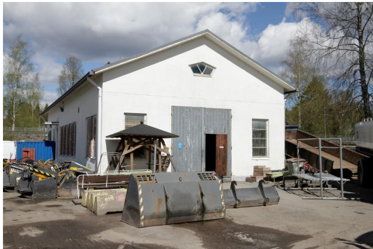
Kuva 192. 1950-luvun hitsaamorakennuksen eteläpäätty.
