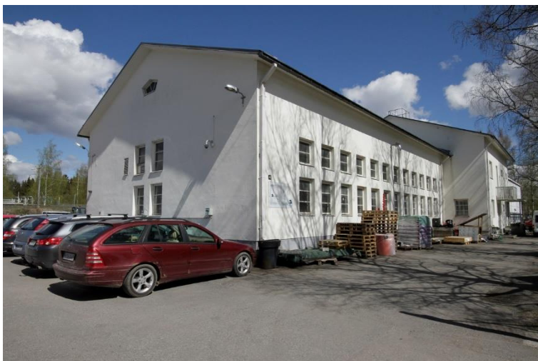
Kuva 182. 1950-luvulla valmistunut konekorjaamo tontin sisäänajoliittymästä Kokkolankadun varrelta nähtynä. Kuvassa näkyy rakennuksen länsipääty ja pohjoisjulkisivu.
