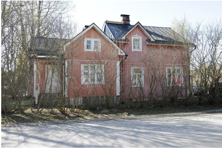
Kuva 218. Ristimäenkatu 23 on rakennettu monessa vaiheessa. Kuvan vasemmassa reunassa näkyvä rakennusosa on 1930-luvulta, isompi laajennusosa on luultavasti jälleenrakennuskaudelta.
