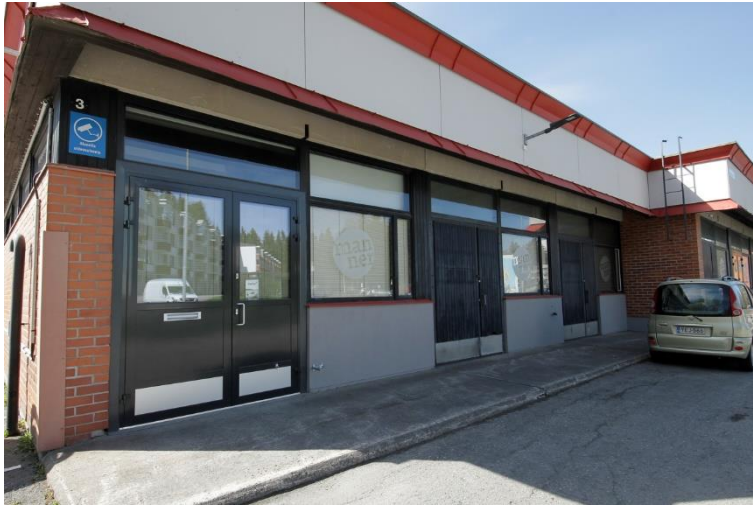
Kuva 168. Kohteen pohjoisjulkisivulla on leveät pariovet rakennuksessa oleviin teollisuus- ja varastotiloihin, joita on muutettu myös liiketiloiksi. Osa alkuperäisistä puuvoratuista ovista on vaihdettu metallikehyksisiksi ikkunallisiksi oviksi. Ovien välissä on tuuletusikkunalliset vaakakaikkunat. Sekä ovien että ikkunoiden yllä on matalat nauhaikkunat.
