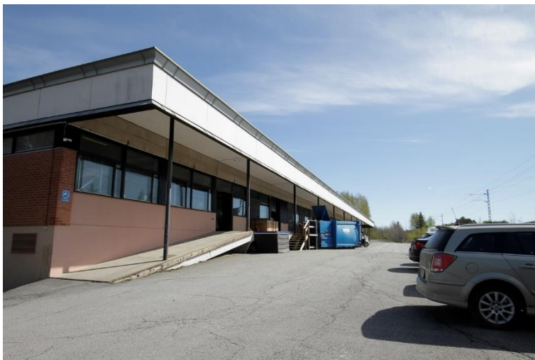
Kuva 165. Kohteen eteläjulkisivulla on lastauslaituri, jonka ylle katto jatkuu muodostaen suojaavan katoksen. Junaradan sähkölangat näkyvät kuvan oikeassa reunassa, itse junarata jää radan varteen pysäköityjen autojen taakse.
