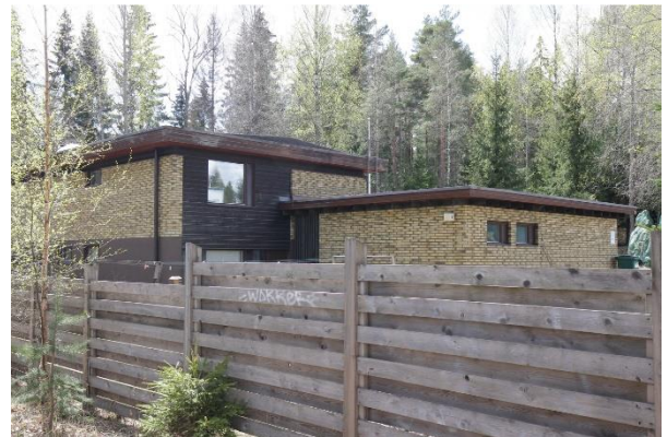
Kuva 99. Kohteen asuinrakennuksen pohjoisjulkisivu. Rakennuksen pohjoisseinustalla on autotalli.
