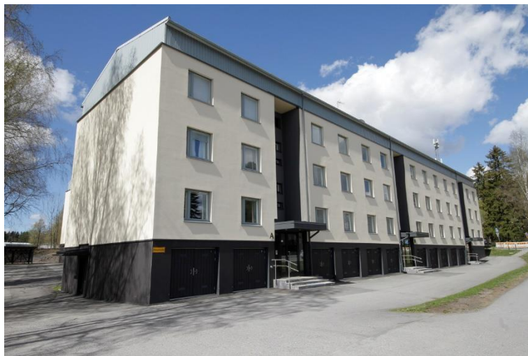
Kuva 198. Kohteen itäisemmän lamellitalon etelä- ja itäjulkisivut.
