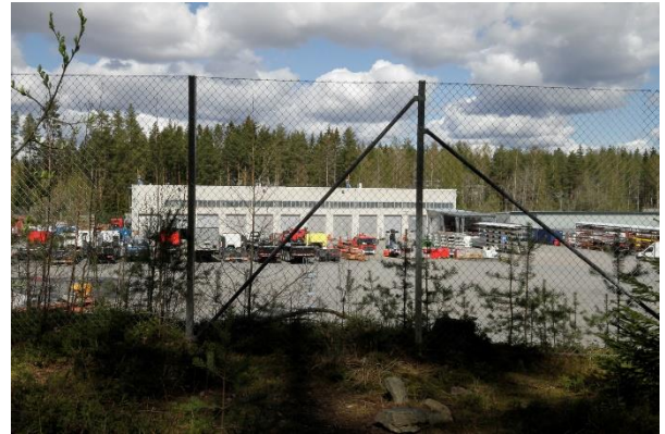
Kuva 93. Kohteen päärakennuksen siipirakennuksen eteläjulkisivu.
