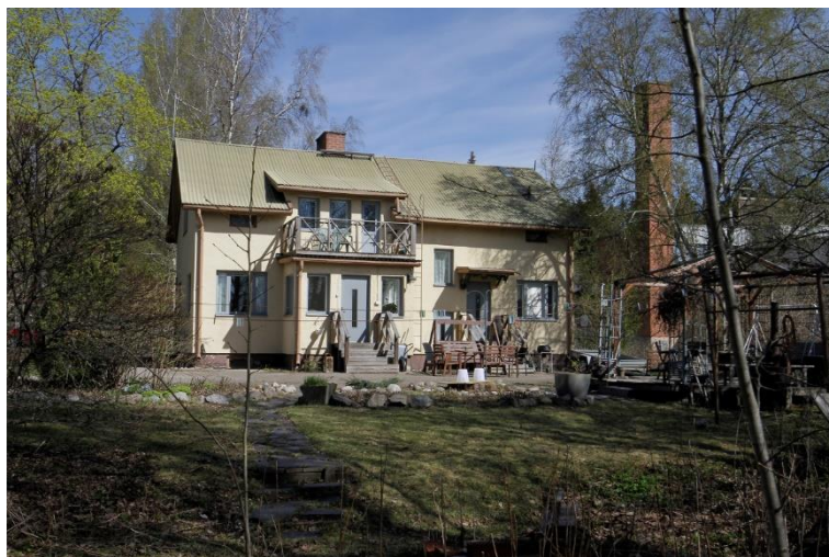
Kuva 155. Kohteen pihan puoleinen eteläjulkisivu. Kuisti sijaitsee alkuperäisen rakennusmassan keskellä. Rakennusta on laajennettu jo 1950-luvulla päädyistä itään, ja laajennusosan asuntoon johtaa eteläjulkisivulta oma ovensa. Kuvassa näkyy kohteen oikealla puolella kasvillisuuden takaa itäpuolisella tontilla olevan pienteollisuustalon keskuslämmityksen savupiippu.
