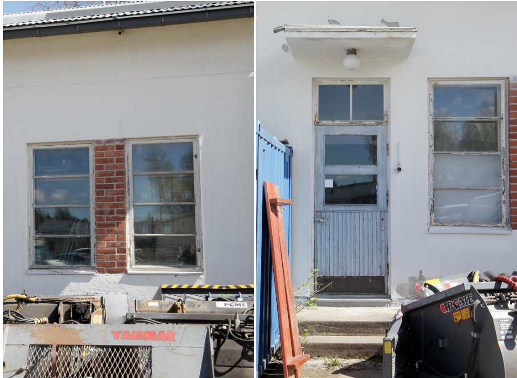
Kuva 193 (vasemmalla). 1950-luvun hitsaamorakennuksen ikkunoiden välit ovat puhtaaksi muurattua punatiiltä. Ikkunat ovat alkuperäisiä.
