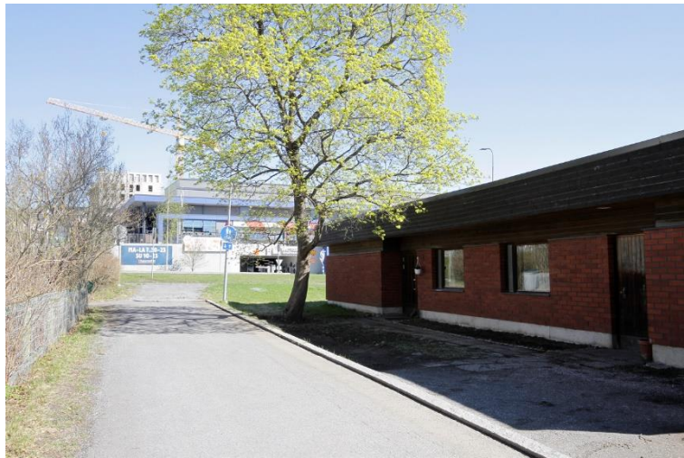
Kuva 229. Kuvassa näkyy tasakattoinen Tervakonkuja 6:n tiilivuorattu erillispientalo. Tervakonkujan päätteenä näkyy Tesomantien pohjoispuolinen ostoskeskus.
