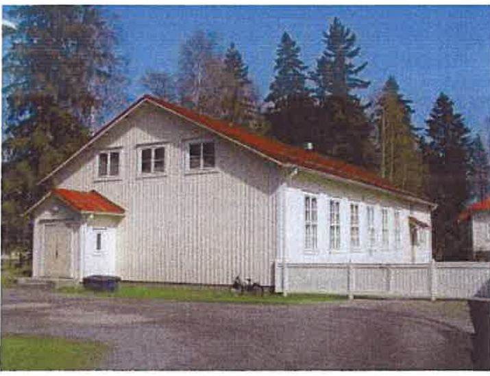
2. Uudempi koulurakennus satulakattoinen, katteena on konesaumattu pelti. Perustus on betonia. Rakennus on peiterimalaudoitettu ja väriykseltään samanlainen kuin vanhempi koulurakennus.
