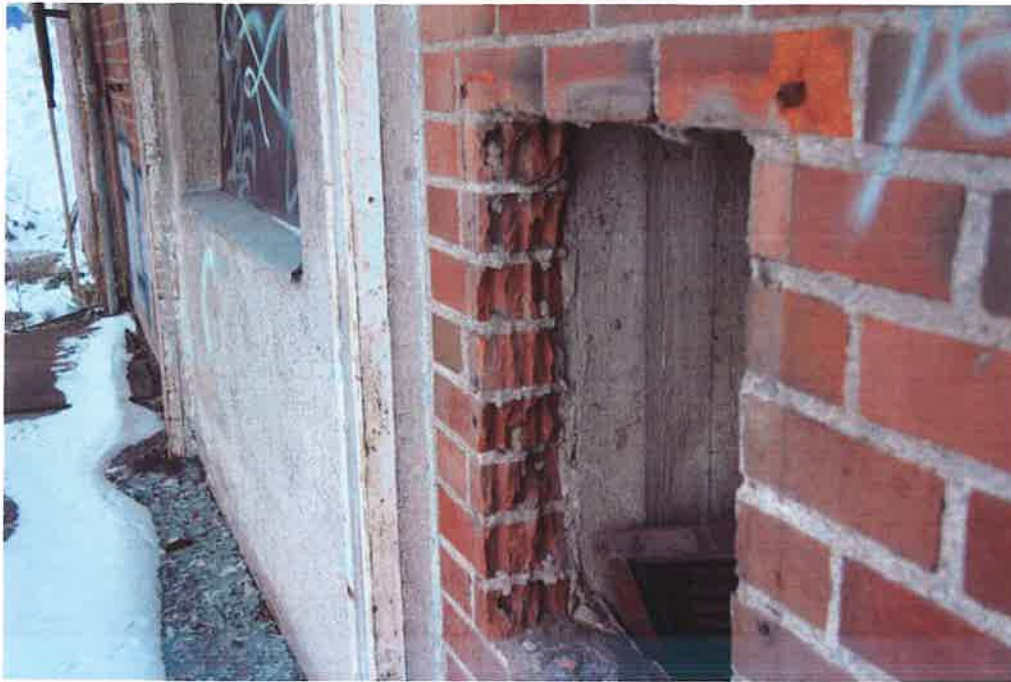
Kuva 7. Puolen kiven paksuinen julkisivurakenne kuivaamosiivessä.
