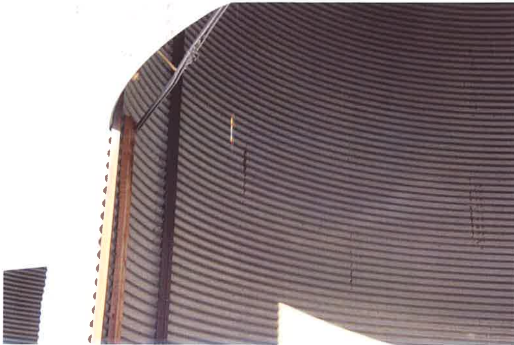
Kuva 13. Terässiilon rakenne
