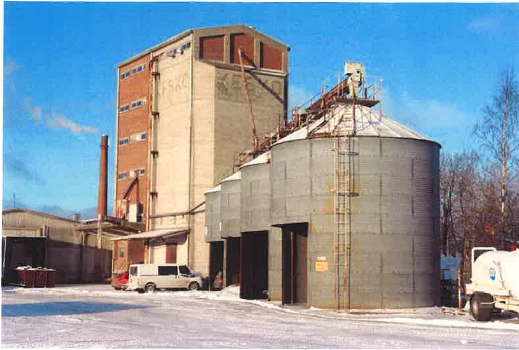
Kuva 3. Vasemmalta lukien varastosiipi, punatiilinen kuivaamo, betoniset siilot ja teräsrakenteinen siilo
