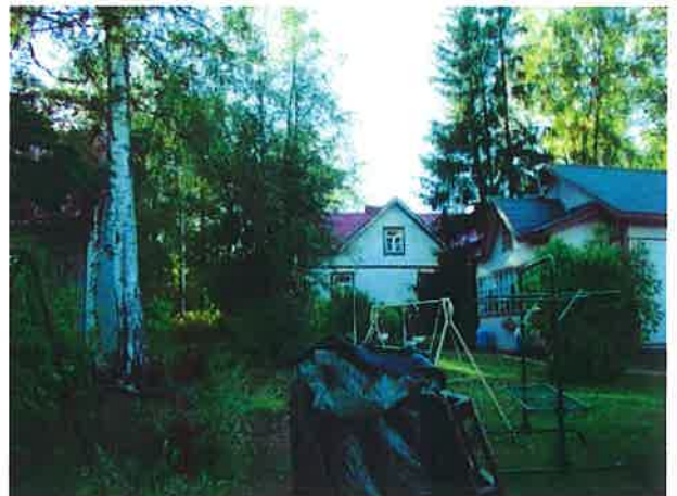
Vanhan koulun ja kahden asuinrakennuksen muodostama kokonaisuus Asematiellä, kuvattuna Karjasillantiellä.
