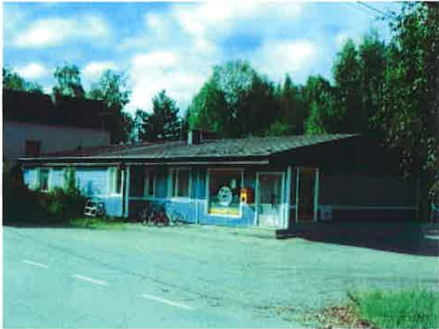
Puretun kestiekievarirakennuksen (kartalla merkintä A) tilalle rakennettu liikerakennus. Liikehuone on nykyisin käyttämätön. Rakennus rajaa eteläpuolelleen uudemman asuinalueen.
