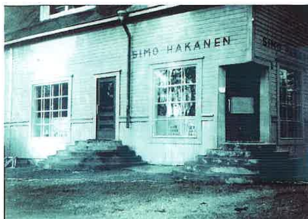
Entinen kihlakunnan kestikievarirakennus, jossa piti kauppaa vuosina 1938-1949 sittemmin Tampereelle leipuriksi siirtynyt Simo Hakanen. (Halimaan asemakylä teoksesta kuva, joka Maija-Leena Niemen kokoelmista)
