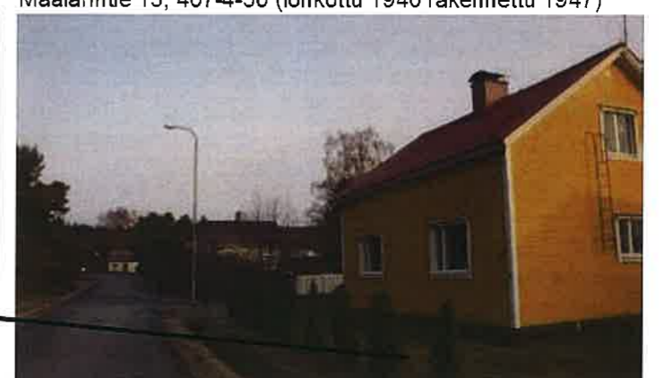
Maalarintie 13, 407-4-50 (lohkottu 1940 rakennettu 1947)
