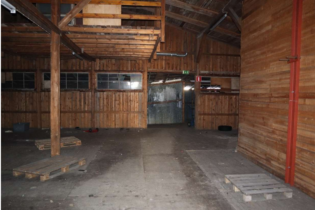
Kuva 18. Varastohallin pohjoispää. Kuvan yläreunassa varastoparvi. Taustalla lastauslaituri.
