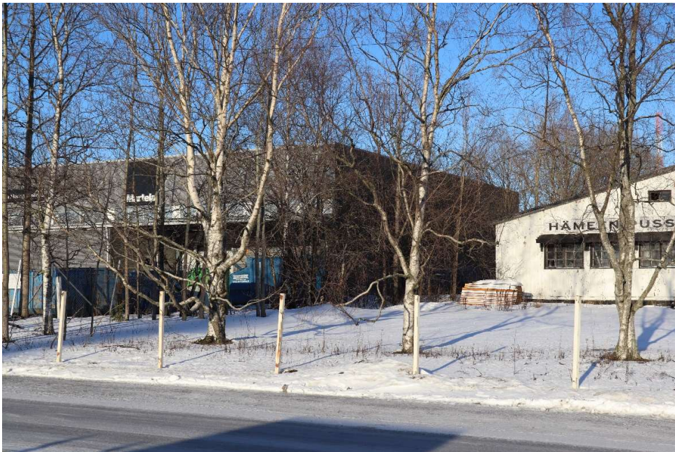
Kuva 2. Julkisivu etelään. Tontin lounaiskulmasta on purettu ulkorakennus.
