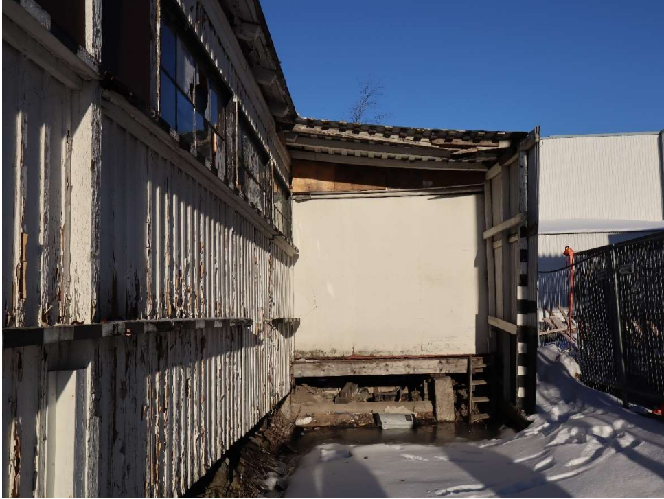
Kuva 3. Julkisivu itään ja alkuperäinen lastauslaituri. Lastauslaituri tukittu.
