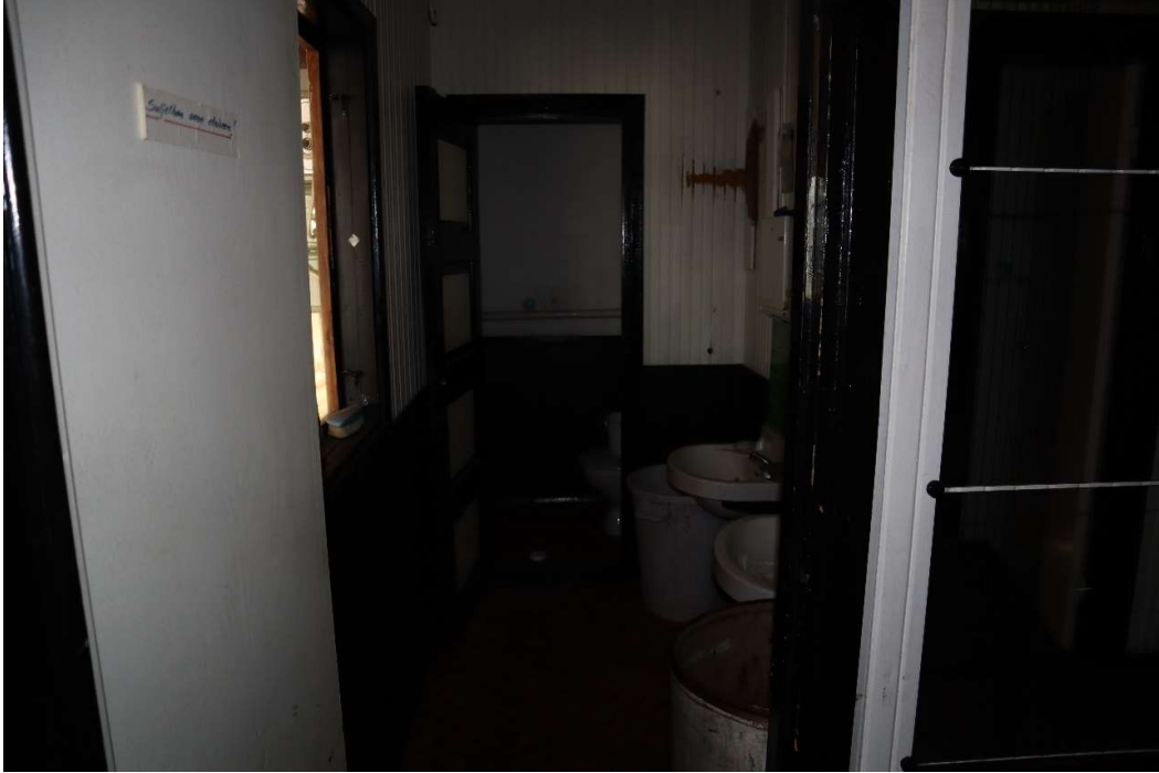
Kuva 26. Tehdashallin puoleinen WC
