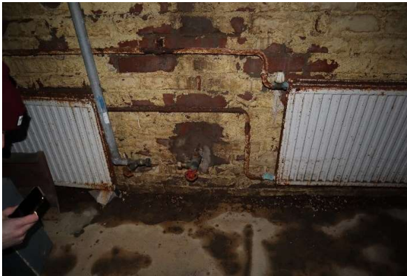
Kuva 36. Autotallin patterit, välistä poistettu vesimittari 2021
