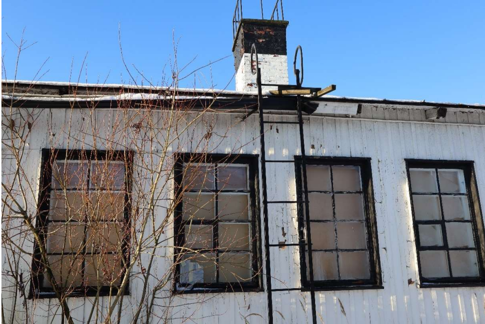
Kuva 8. Itäisen julkisivun ikkunat ja savupiippu.
