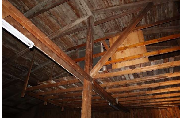
Kuva 31. Varastohallin pohjoispään rakennetta
