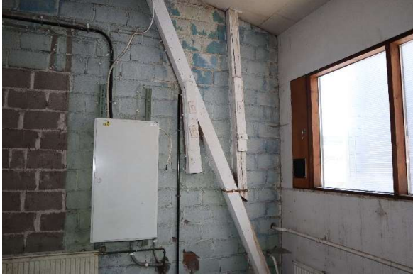
Kuva 30. Tehdas- ja varastohallin seinän rakennetta
