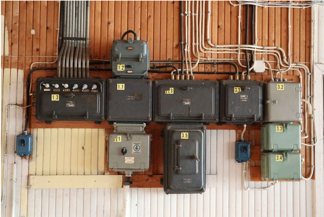
Kuva 28. Tehdashallin sähkökeskus
