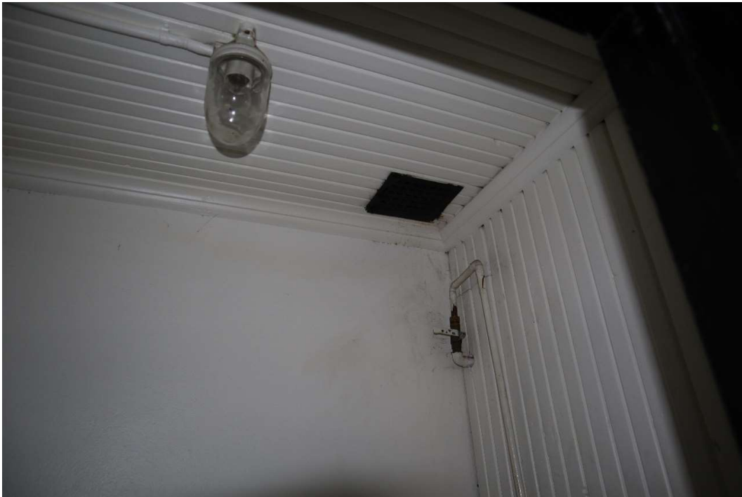
Kuva 29. WC:n kattovalo ja ilmanvaihtoluukku
