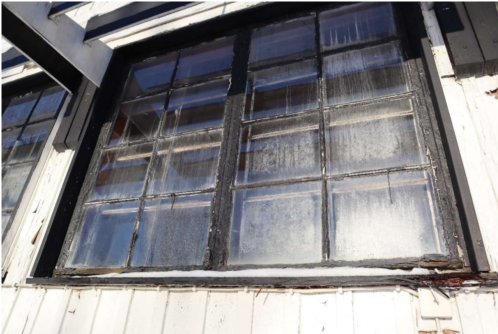
Kuva 7. Pääsisäänkäynnin viereinen ikkuna.
