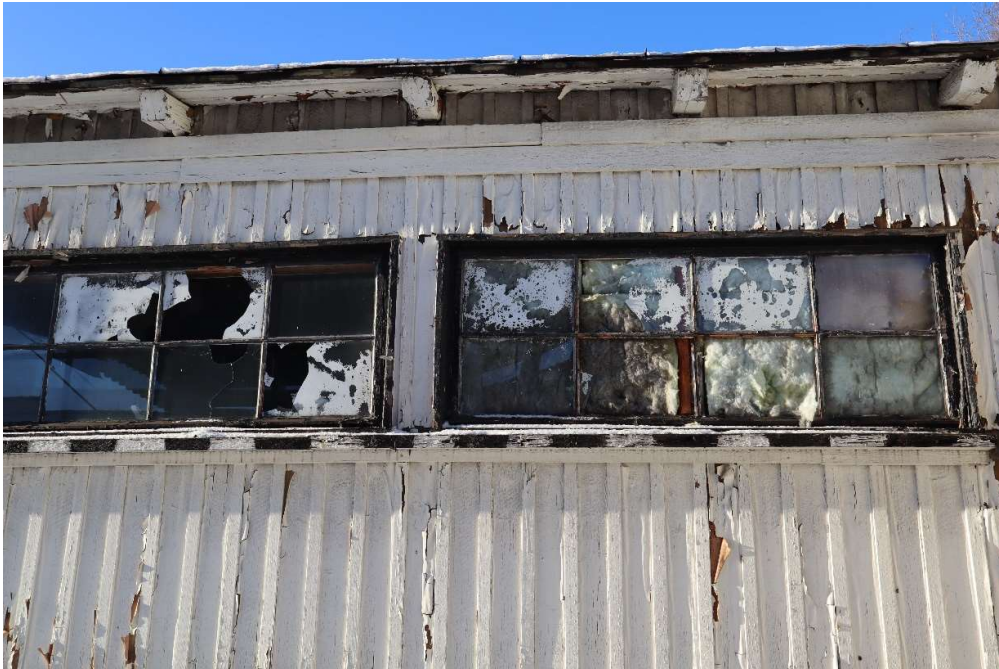
Kuva 9. Lastauslaiturin viereiset ikkunat.
