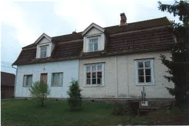
Asuinrakennus pohjoisesta Kirkkotieltä.
