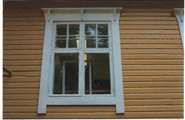
Ristikarmi-ikkuna pienin puittein länsisivu.
