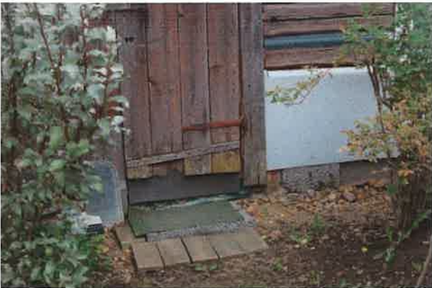
Saunan perustuksia ja korjauksia.
