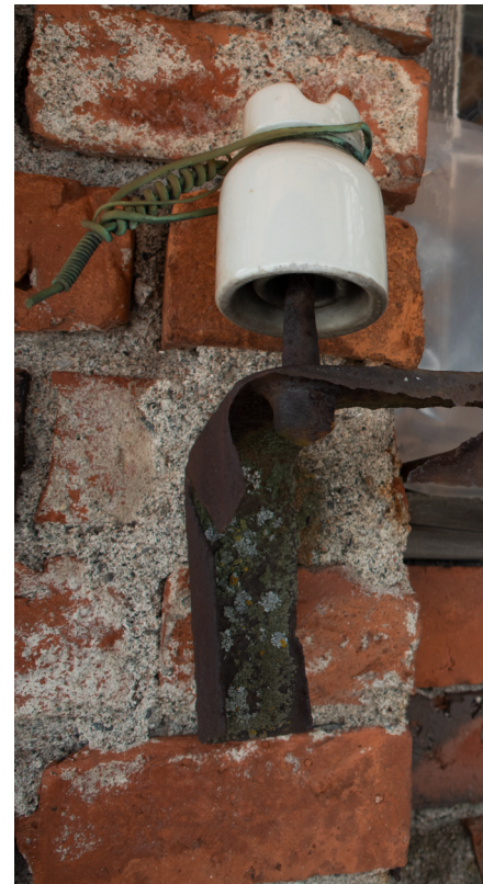
Sähkölinjan päate ylimmän kerroksen ikkunan yhteydessä.
