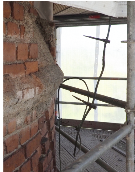
Ukkosenjohdatin kuparijohdin ja kiinnikkeet.
