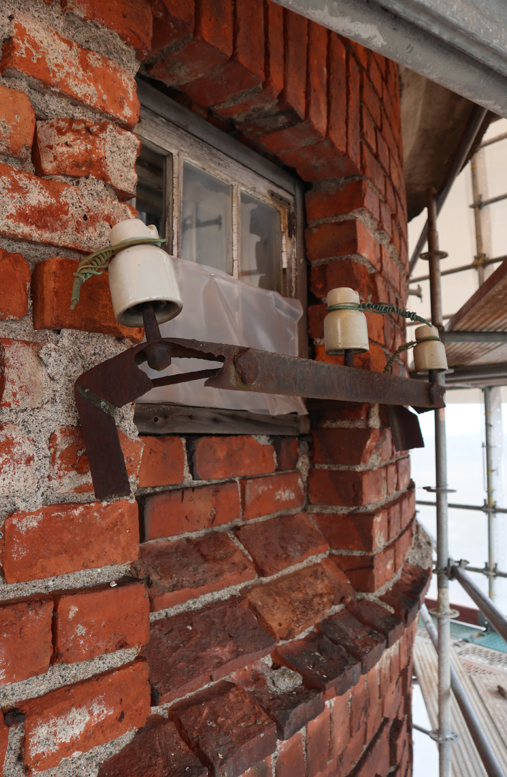
Sähkölinjan päate ylimmän kerroksen ikkunan yhteydessä.
