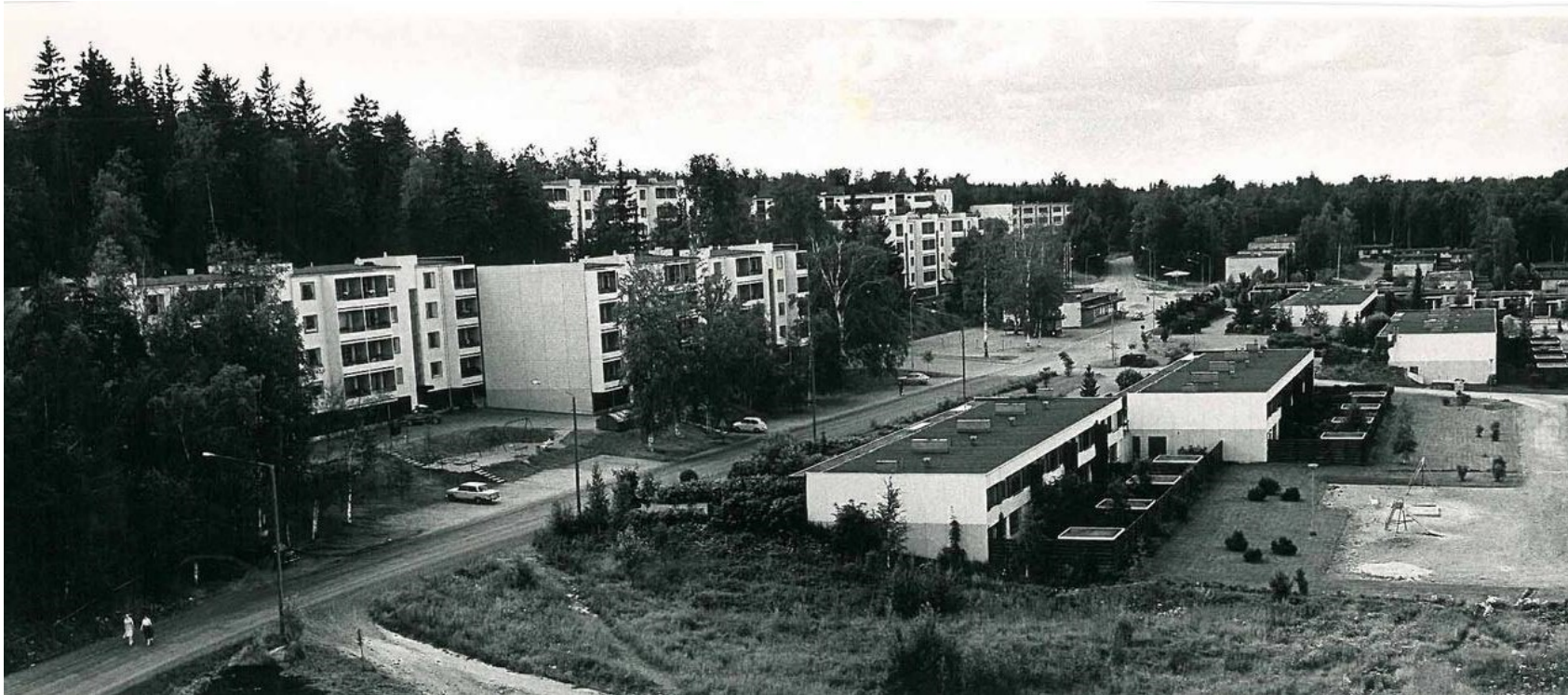
Loukonlahti 1970-luvulla, kerrostalokorttelit 211 ja 215 ja rivitalokortteli 212, jotka rakennusliike Noppa rakensi ja arkkitehti Pekka Ilveskoski suunnitteli. Kuva: Pirkkala-Seura.
