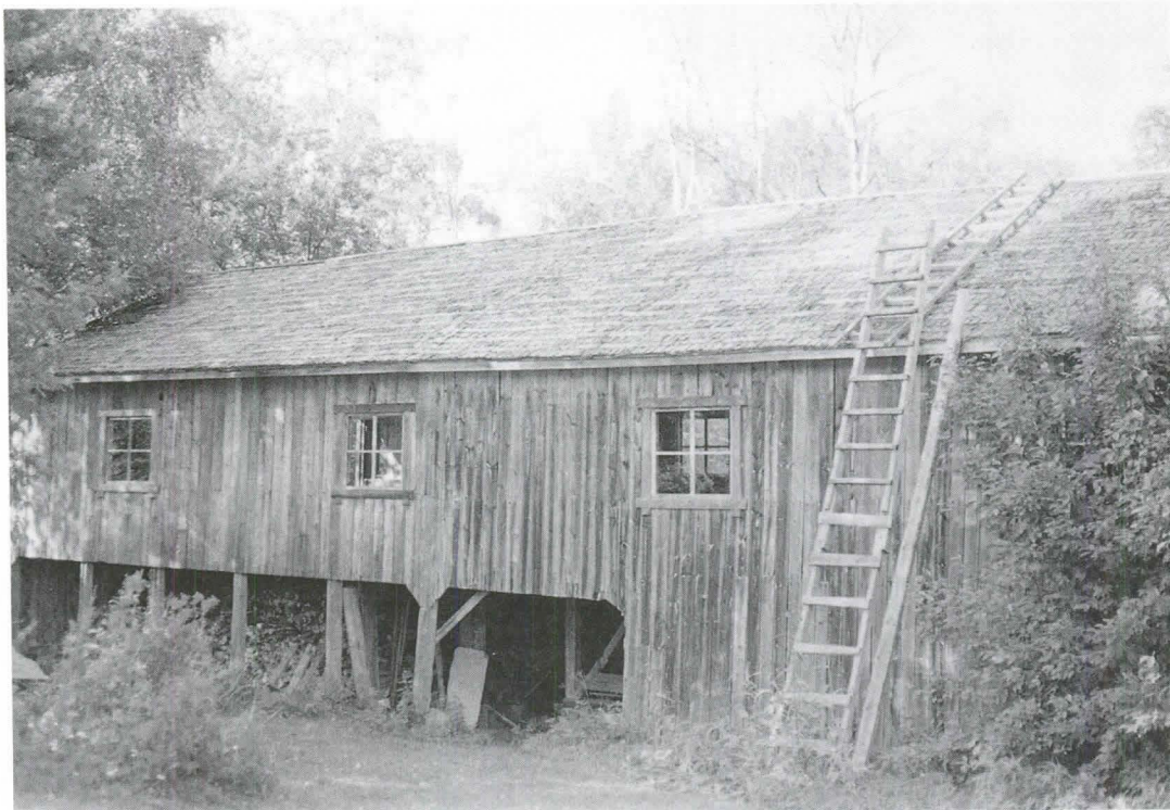
Mikkolan mylly- ja saharakennuksen sahaosa. Kohde on kunnostettu Temmeksen kotiseutuyhdistyksen toimesta. Valok. Timo Kantonen 1994. MV/RHO.
