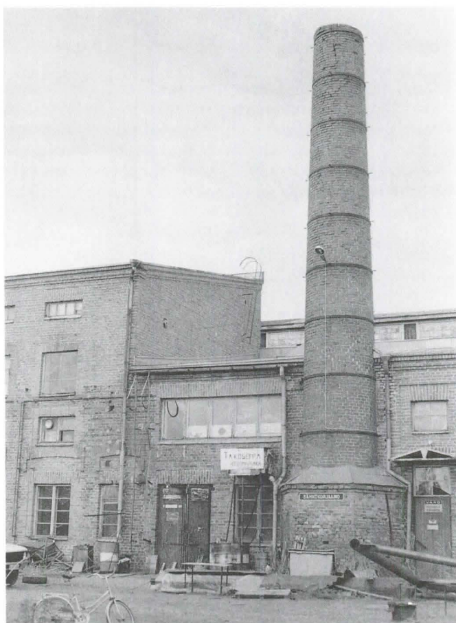
Martinniemen sahan entinen voima-asema ilmentää sahan tuotantorakennuksille yleistä piirrettä: useiden rakennusvaiheiden kerroksisuutta. Valok. Timo Kantonen 1994. MV/RHO.
