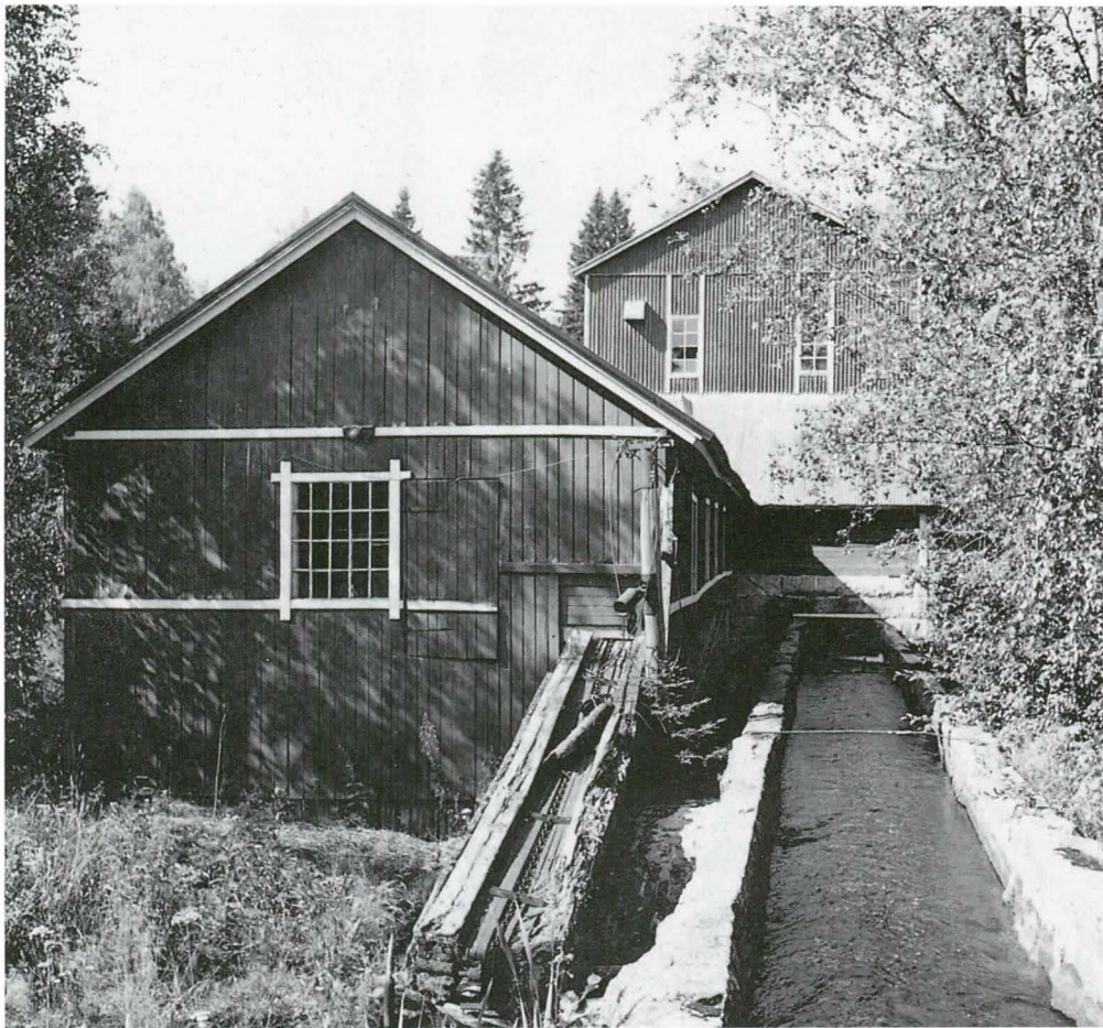
Palsan vesimylly jatkaa vuosisataista myllyperinnettä Päijät-Hämeessä. Myllyyn liittyy yksikehäinen saha, jonka pääty näkyy kivisen voimakanavan vieressä. Valok. Timo Kantonen 1994. MV/RHO.
