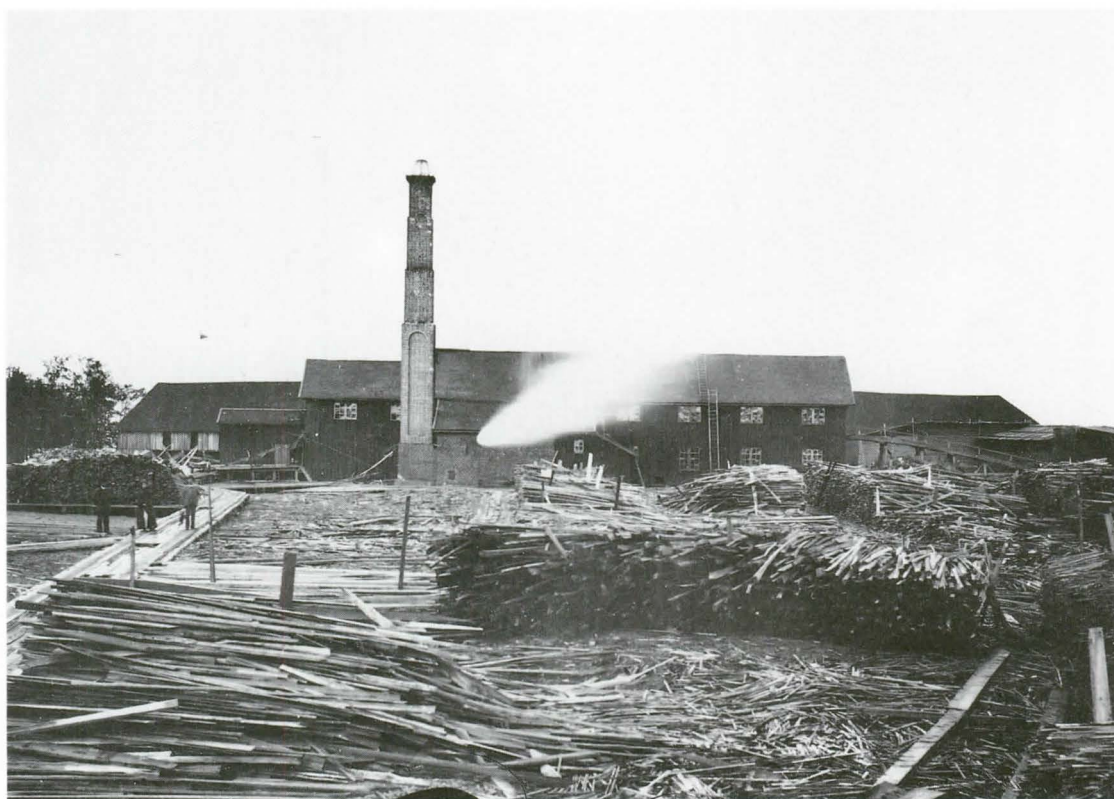
Stockholmenin vuonna 1860 valmistunut höyrystaha oli maamme toinen höyrystaha. Sahatoiminnan jäännöksinä on saarella säilynyt koneiden perustuksia ja vanhassa valokuvassakin näkyviä jäterimoja. MV/KKA.
