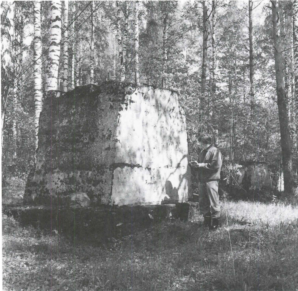
Inventoiija tekee muistiinpanoja kehäsahan betonisen jalustan juurella Härskiänsaaren höyrysahan raunioilla. Valok. Erkki Härö 1994. MV/RHO.
