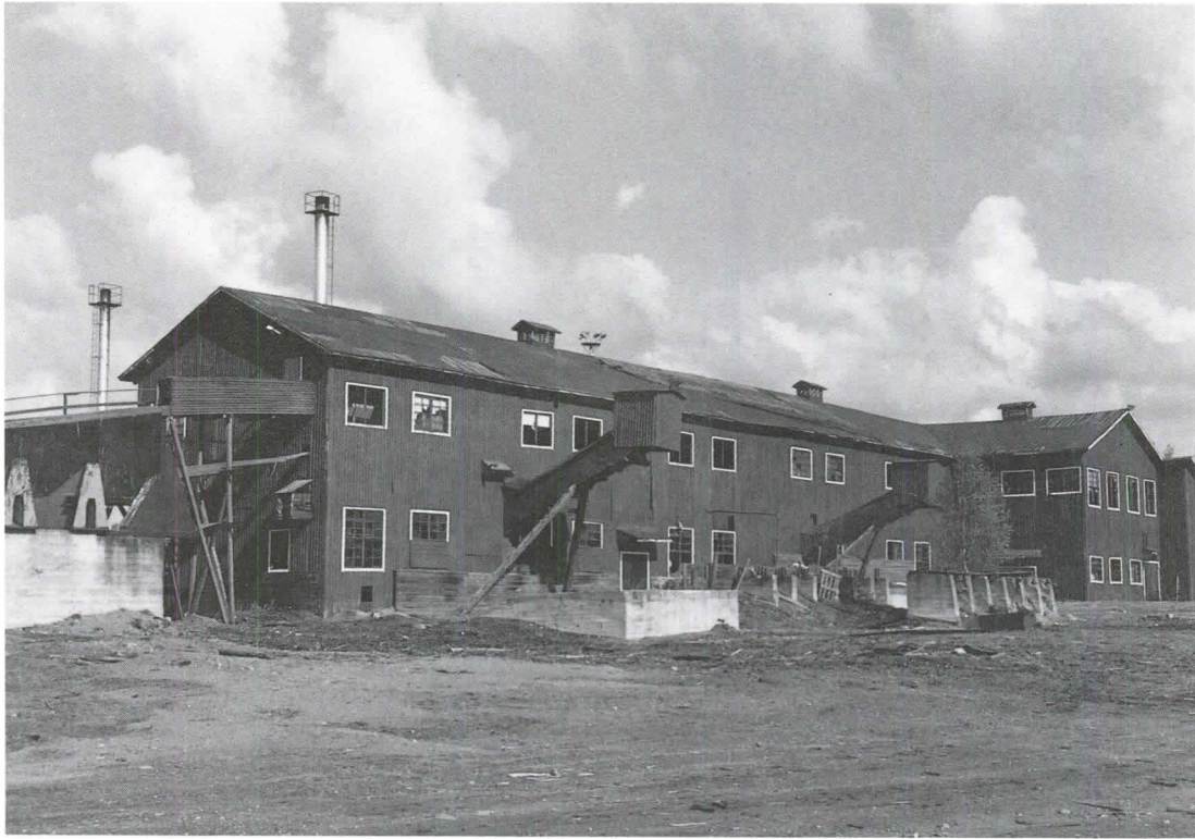
Tervasaaren saharakennus on vuodelta 1947. Jälleenrakennuskauden sahalaitoksissa seurattiin vielä useimmiten höyrystöjen perinteisiä ratkaisuja mm. rakennusmateriaalin osalta. Valok. Timo Kantonen 1994. MV/RHO.
