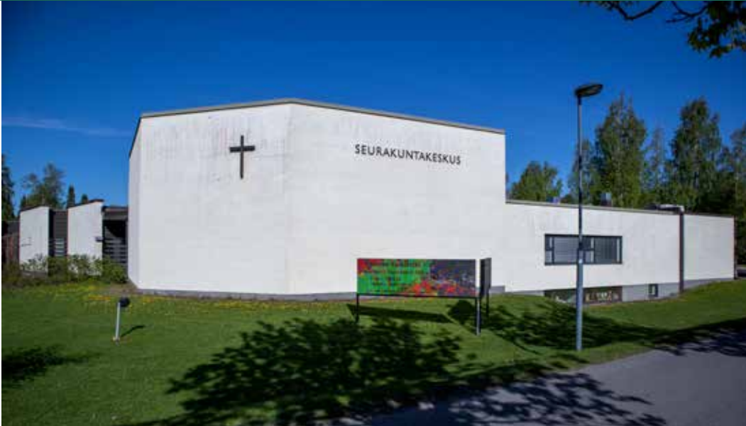
Ylöjärven seurakuntakeskus idästä. Kuva: Kerttu Loukusa 2022.
