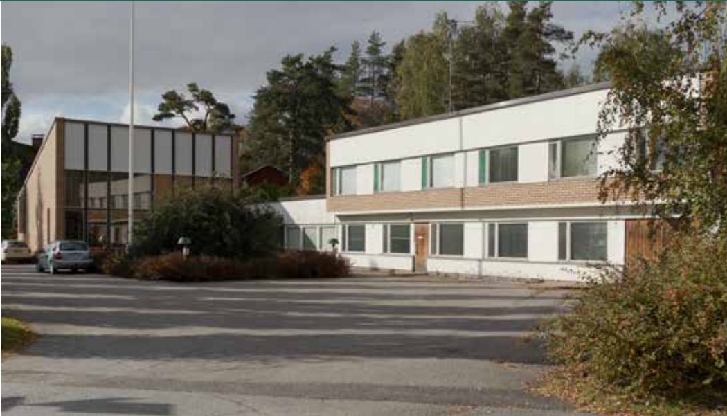
Urjalan seurakuntatalo, idästä katsottuna. Kuva: Kerttu Loukusa 2021.
