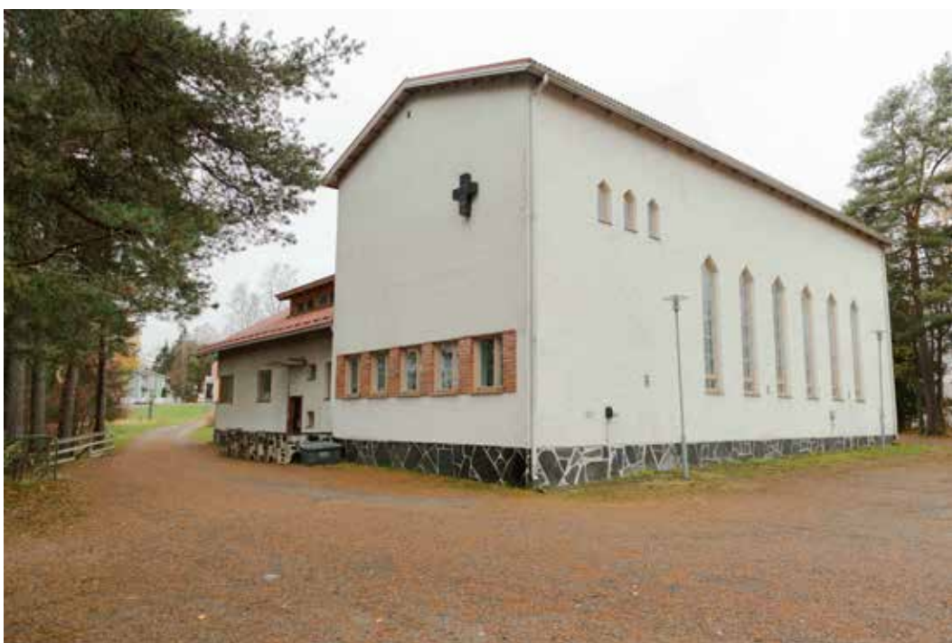
Kangasalan kirkonkylän seurakuntatalo ulkoa (arkkitehti Mikael Nordenswan, 1952). Seurakuntasaliosan kirkkomainen muotokieli viittaa historiaan, arkisemmat tilat ovat modernimpia ja pelkistetympiä. Kuva: Kerttu Loukusa, 2021.
