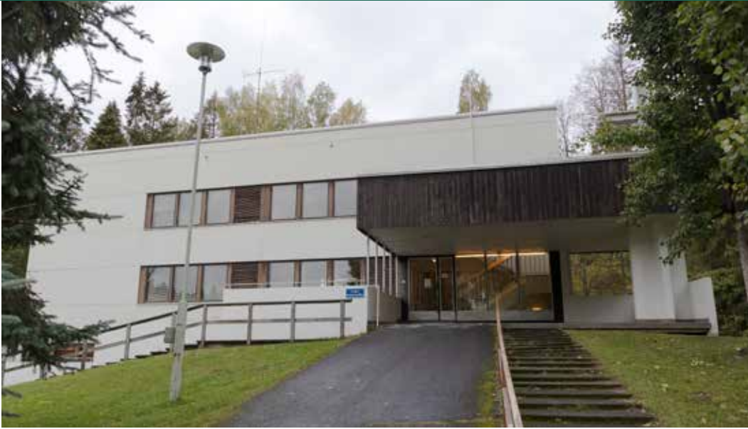
Peltolammin seurakuntakeskuksen pääsisäänkäynti idästä katsottuna. Kuva: Kerttu Loukusa 2021.
