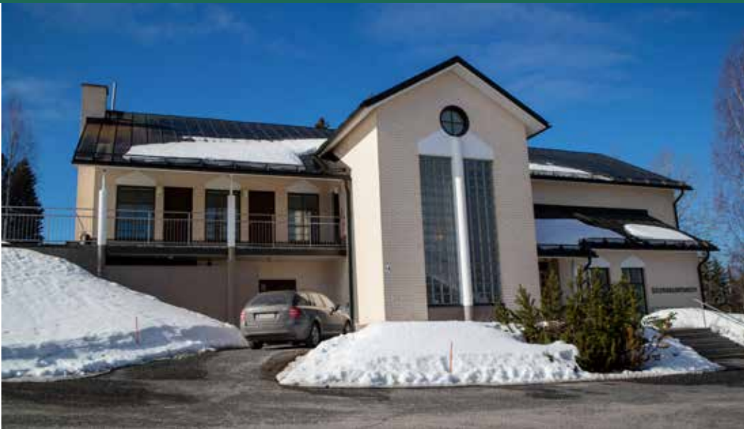
Kuhmoisten seurakuntakoti, sisäänkäyntijulkisivu. Kuva: Kerttu Loukusa 2022.
