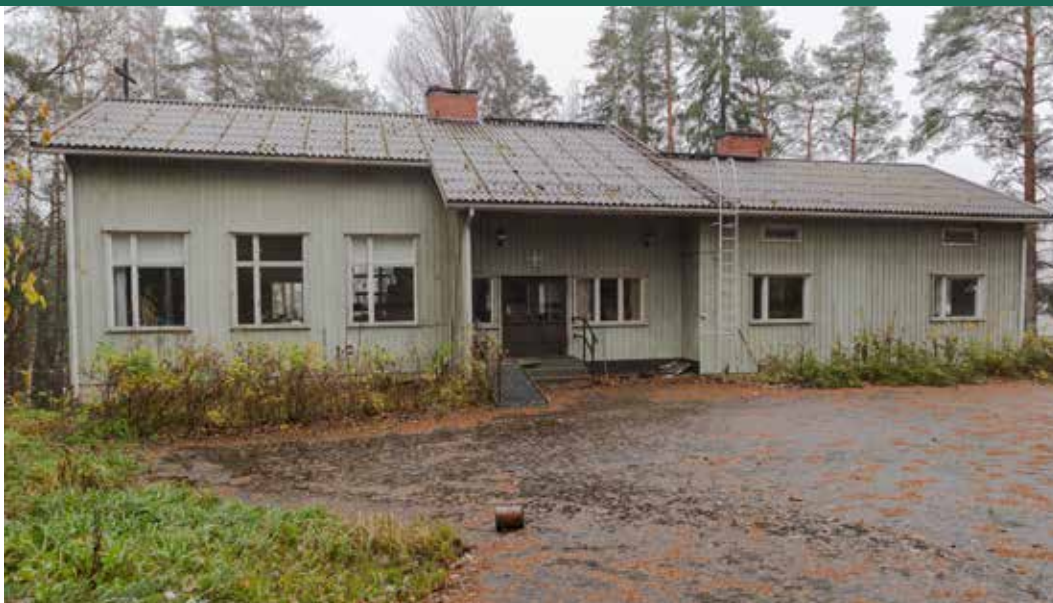
Kuljun vanha seurakuntatalo, sisäänkäyntijulkisivu. Kuva: Kerttu Loukusa 2021.
