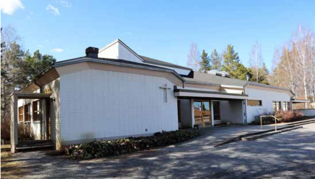
Keikyän seurakuntatalo, etelästä katsottuna. Kuva: Kerttu Loukusa 2022.
