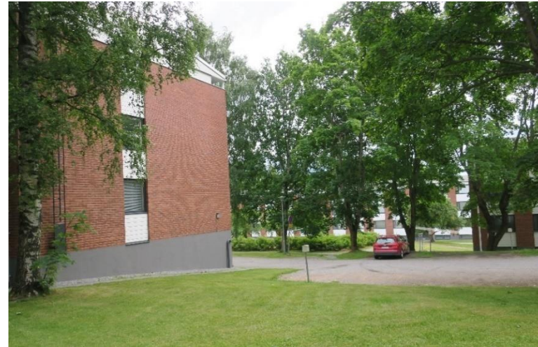
Kuva 52. Lamellitalojen väliin jää pysäköintialue.
