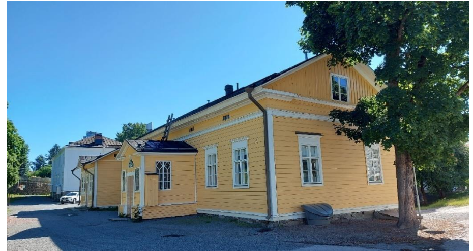
Kuva 72. Koulun vanha rakennus, itäpäätty Wivi Lönnin suunnittelema laajennus, takana oleva kuisti on entisen kappelikirkon kuisti.
