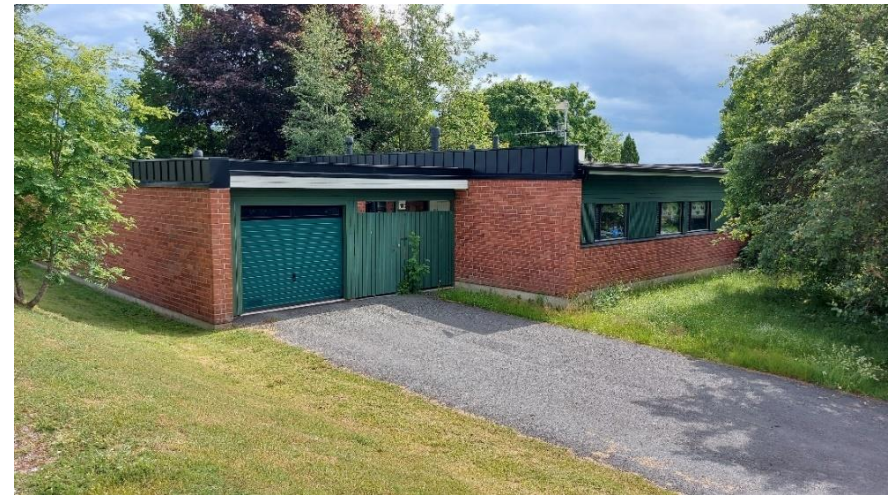
Kuva 56. Muutamissa atriumtaloissa oli kokonaisuudesta poikkeava julkisivuväriyty.
