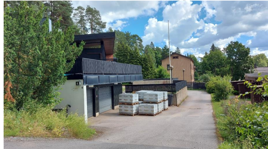
Kuva 60. 1960-luvun rakennus. Taustalla 1920-luvun pientalo.
