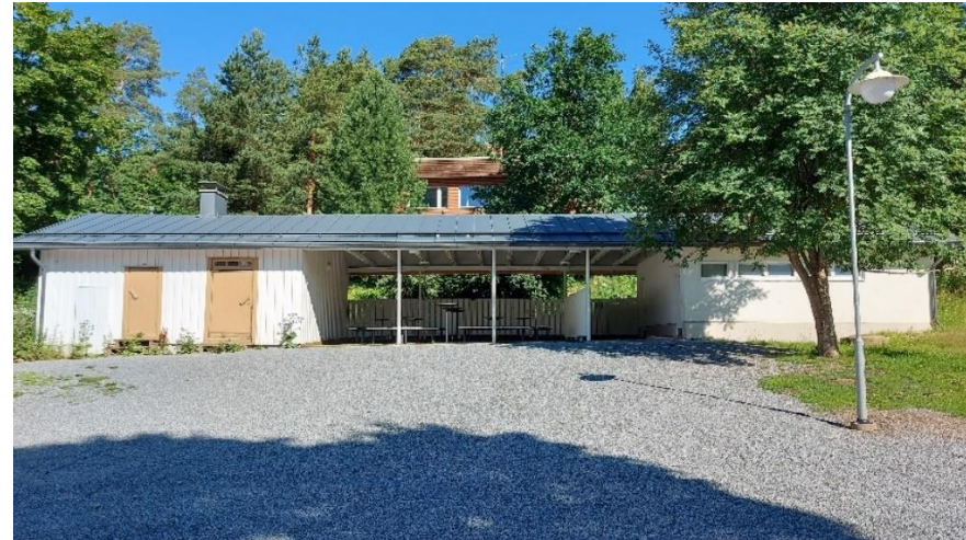
Kuva 77. Koulun pihapiirin huoltorakennus.
