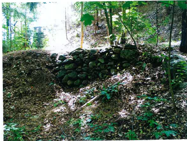
KUVA 34. Ylärinteen polku on tuettu kivimuurilla, josta enää osa on jäljellä. Osa on hautautunut puutarhajätteen alle. (Kuva Pauliina Siltanen)
