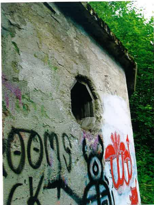
KUVA 47. Saunan kahdeksankulmainen ikkuna. (Kuva Pauliina Siltanen)
