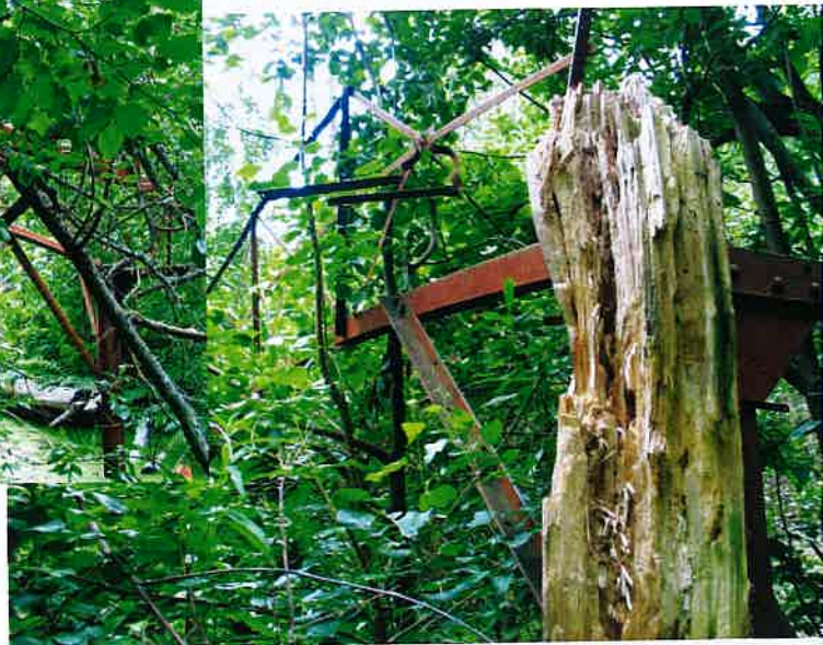
KUVA 40. Kaarisillasta ovat kaikki puuosat hävinneet ja jäljellä on vain punaiseksi maalattu rautarunko. (Kuva Pauliina Siltanen)
