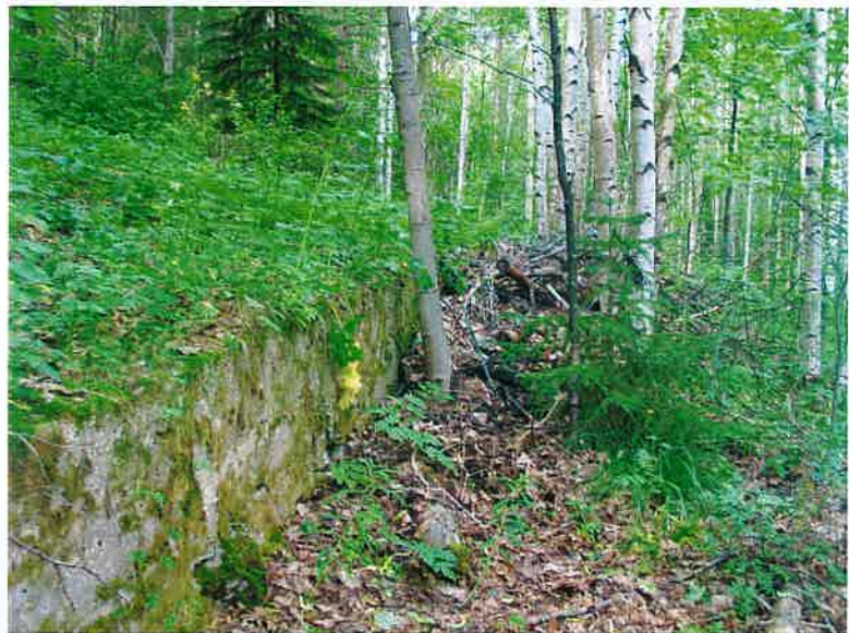
KUVA 30. Ylempi betonimuuri. Kuva otettu etelästä pohjoiseen. (Kuva Pauliina Siltanen)
