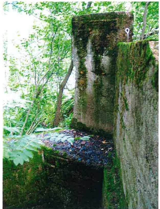
KUVA 43. Lammen muuri ja idän tonttia rajaava betonimuuri kohtaavat. Kulmassa on iso kolmion mallinen pylväs. Molemmat muurit päättyvät tähän. (Kuva Pauliina Siltanen)
