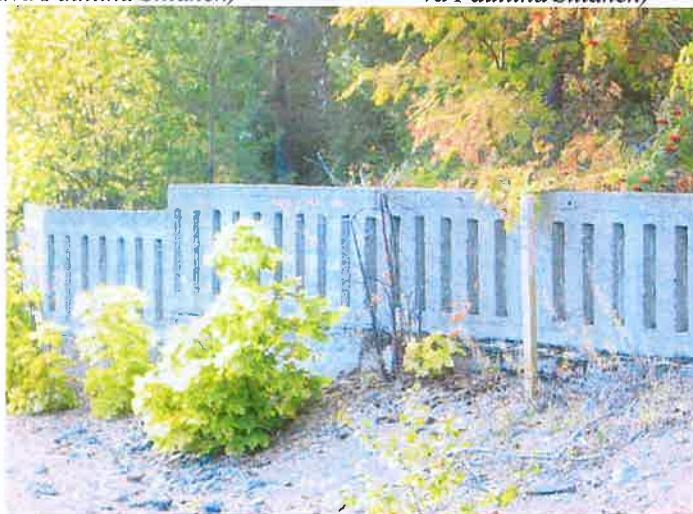
KUVA 19. Yläpuutarhaa kiertävä betoniaita. (Kuvan omistaa Janne Joki, kuvaaja Janne Joki)
