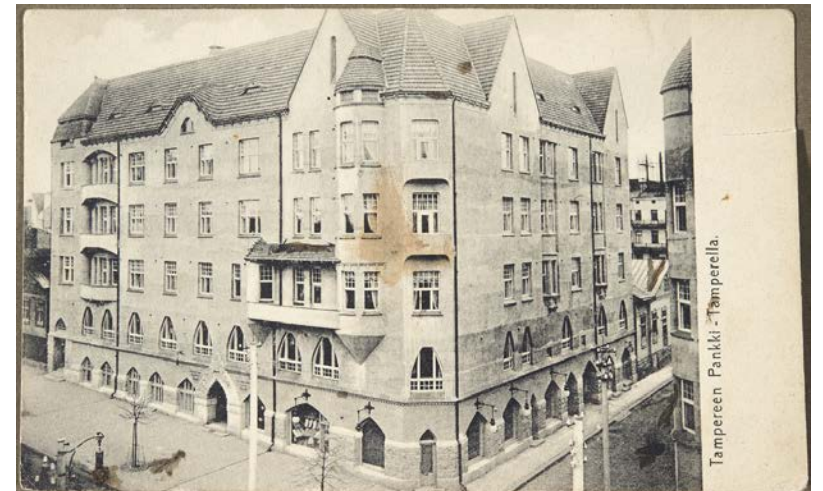
↑17 Ylläolevassa postikortissa (valmistusaika 1906-1909) havaittavissa toisen vaiheen osuus kokonaisuudessa valmistuttuaan. Kuninkaankadun kulmassa pilkistää vanha puinen toimistorakennus, jonka tilalle kolmas osa rakentu myöhemmin. Tässä kohtaa on siis nähtävissä toisen ja kolmannen osan raja. Liikehuoneistojen yläpuolelle ripustettuja valaisimia ei näy julkisivukuivissa. Kokonaisuudessaan rakennus on jyhkeän linnamainen ja katutason julkisivu muodostaa näyttävän ja tasapainoisen kokonaisuuden ylemmän rakennusmassan kanssa.
