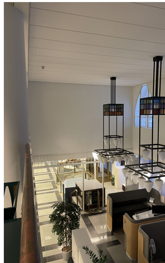
puolimmaisena kuva tilan länsipäädystä kaksikerroksista tilasta. Huomaa näyttävät valaisimet, jotka on todennäköisesti suunniteltu tilaan palauttavan peruskorjauksen yhteydessä. Alaslaskettu katto aiheuttaa ahtautta kaksikerroksisen tilan yläikkunoiden yläreunan kanssa.
