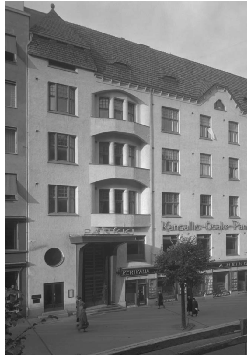
↑38 Kuvassa havaittavissa vuonna 1938 suunnitellut ja toteutetut funktionalismin nojaavat muutokset: asuinhuoneistojen sisäänkäynnin riisunta koristeista, ympyräikkunan lisäys, myymälöiden mainoskylttien korostaminen vaakasuuntaisella pohjapalkilla, toisen kerroksen ikkunoiden muutos suorakulmaisiksi ja koristeista riisutuiksi ja tietyksi pankin uusi sisäänkäynti.
