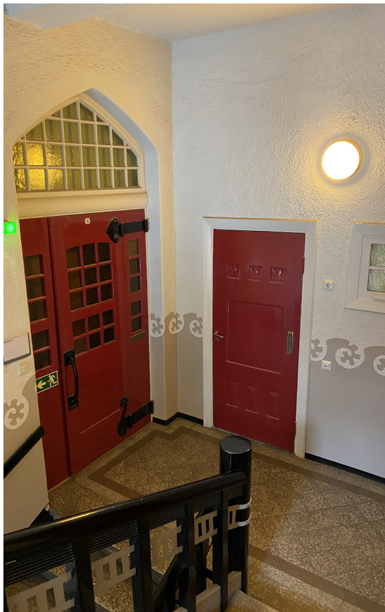
↑82, 783, 7784 Kuvissa Kauppakadun puoleinen porrashuone ylemmissä kerroksissa. Vasemmalta oikealle luettaessa ensinnä portaiden lepotaso, kerrastaso ovidetaljeineen ja portaan kaitteen detaljiikkaa.
