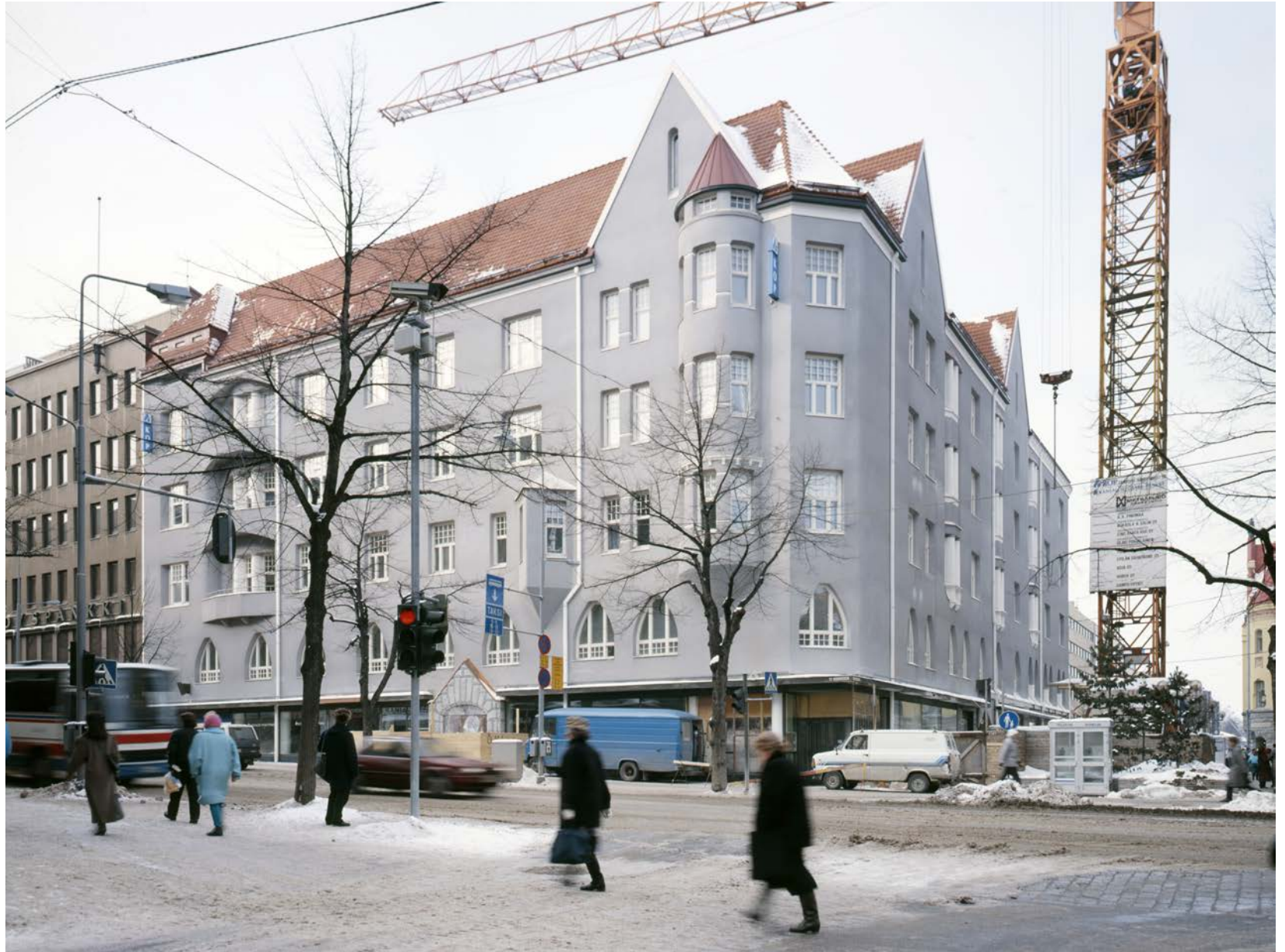
↑63 Kuvassa havaittavissa 1980-luvulla toteutettuja palauttavia muutoksia julkisivuun: toisen kerroksen ikkunoiden palautus, vuoden 1905 sisääkäynnin mukaelma (huomaa uusi kuparinen
