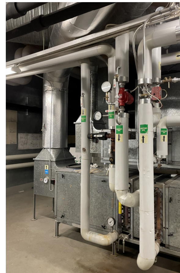
pohjoiseen. Oikealla kuvassa rakennuksen uusittua ilmanvaihtokonehuonetta. Lattiaan on tehty betonivalu.
