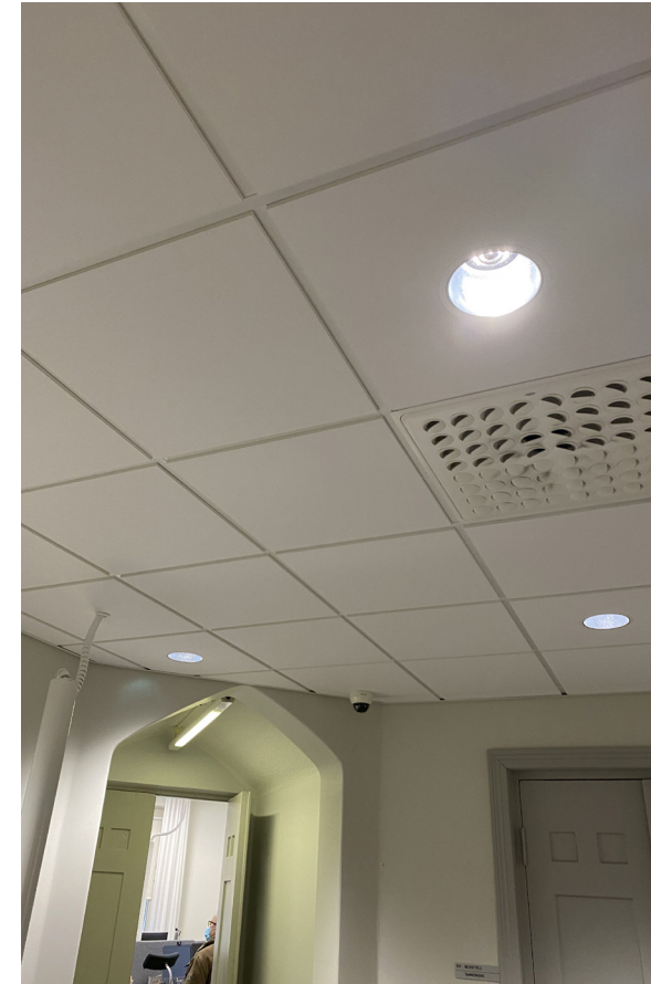
tun katon ja ikkunan kohtaaminen. Viimeisessä kuvassa 2010-lukulainen alaslaskettu järjestelmä-katto, jossa moderni iv-kuljetin, upotetut led-valaisimet ja liikkeentunnistin. Alaslaskun alareuna on tuotu aivan kulkuaukon yläreunaan mikä muodostaa esteettisesti sopimattoman detaljin.
