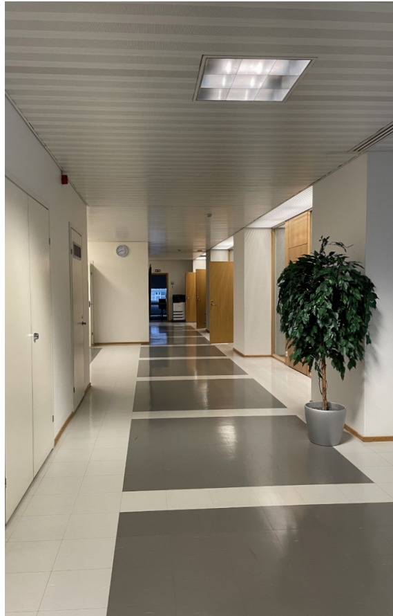
↑115, ↗116, ↗117 Kuussa erilaisia alaslaskettuja kattoja. Ensimmäisessä kuvassa tyyppillisin kattotyyppi peruskorjauksen ajalta eli matalalle tuotu valkoiseksi pulverimaalattu ja perforoitu metallikasetti, johon on upotettu myös valaisimia. Keskimmäisessä kuvassa kipsirakenteinen alaslaskettu katto toimistotilasta, jossa näkyy myös tyyppillinen detaljointi, jolla on hoidettu alaslask-
