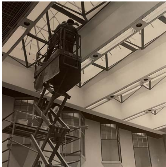
↶↶96, ↶97, ↑98 Kuvissa valopihan pankkisali eli nykyistä toimistotilaa. Yllä vasemmalla huomaa kuvassa seinien makasiiniosan erkkerimäiset ikkunat ja Kauppakadun portaikon umpeen laitettuja ikkunoita. Alla vasemmalla kuva peruskorjauksen ajalta, kun valokatetta asennetaan. Taustalla näkyvät samaiset erkkeri-ikkunat. Yllä valopihaa etelä suuntaan. Kuvan vasemmassa reunassa umpeen laitettu kulku vanhaan porttikonkkiin. Takaseinällä koristelasi-ikkunat, jotka saattavat olla alkuperäiset ikkunat vanhimmasta pankkisalista.
