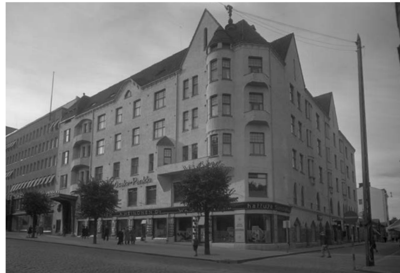
↑↑34, ↑35 Ylemmässä kuvassa (kuvattu 11.7.1932) katujulkisivu vuoden 1927 suunnitelmien mukaan ja alemmassa (kuvattu 25.9.1939) vuoden 1938. Huomaa pankkisalin sisäänkäynnin ja asuinhuoneistoihin johtavan portaan, myymälätilojen fasadin ja toisen kerroksen ikkunoiden muutos sekä parvekkeen katoksen poisto.
