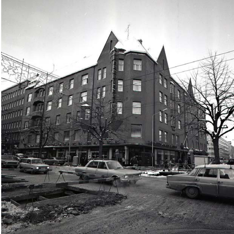
↑50 Kuva Hämeenkadun ja Kuappakadun kulmasta kohti rakennuksen koilliskulmaa talvelta 1974-1975. Huomaa vuoden -60 suunnitelmien mukaiset toisen kerroksen ikkunat sekä katutason sisäänkäynnit. Katon arkkitehtoninen ilme on yksinkertaistettu positamalla kattoikkunat ja räystäään detljiikka. Pyöreän erkkerin viereinen parveke sekä Hämeenkadun ja Kuninkaankadun kulmassa neljännessä ja viidennessä kerroksessa sijainneet parvekkeet on poistettu.
