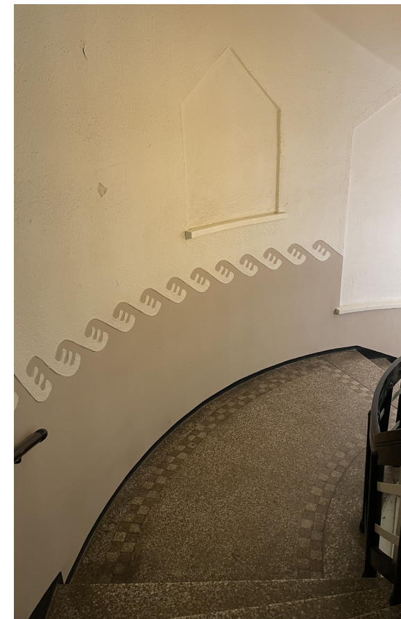
nien pinnassa. Toisessa ja kolmannessa kuvassa on kuvattu kolmannen ja ensimmäisen kerroksen syöksyä ja lepotasoa. Huomaa mosaiikkibetonin ja laatoituksen detaljoinnit.
