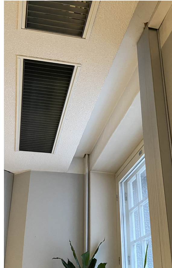
↑115, ↗116, ↗117 Kuussa erilaisia alaslaskettuja kattoja. Ensimmäisessä kuvassa tyyppillisin kattotyyppi peruskorjauksen ajalta eli matalalle tuotu valkoiseksi pulverimaalattu ja perforoitu metallikasetti, johon on upotettu myös valaisimia. Keskimmäisessä kuvassa kipsirakenteinen alaslaskettu katto toimistotilasta, jossa näkyy myös tyyppillinen detaljointi, jolla on hoidettu alaslask-
