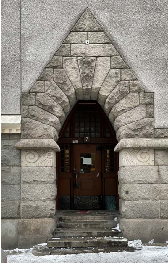
↑168, ↗69 Kuvissa Kauppakadun vanhin sisäänkäynti, joka on säilynyt hyvin alkuperäisenä. Ajallisia lisäyksiä ovat sisäänkäynnin kolmioaiheiset valaisimet, ovipuhelin seinässä ja kulkuoikeustunnistin ovesta sekä yritysten nimilaatat seinässä.
