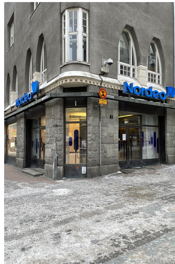
tiin ramppi kellaritiloihin. Oikealla sisäänkäynti sisäpihan pankkisaliin sekä piianportaan paikalle tehtyyn hissiin. Oikeanpuoleisessa kuvassa Kauppakadun ja Kuninkaankadun kulman sisäänkäynnit. Täysin kulmassa sijainnut sisäänkäynti on poistettu ja tilalla on nykyisin ikkuna. Huomaa myös vasemmanpuoleisessa kuvassa hammastetun koristelinjan loppuminen modernisoidun julkisivun kohdalla.
