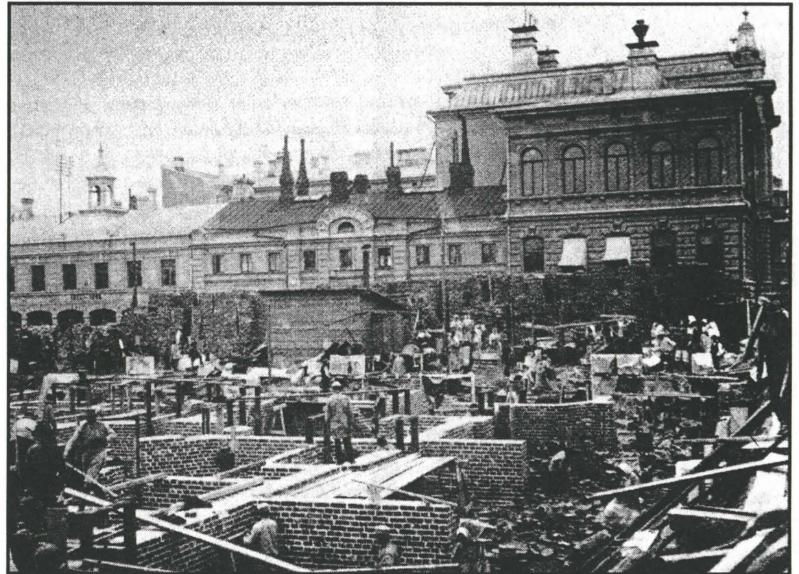
Commercen talon rakennustyömaa.
