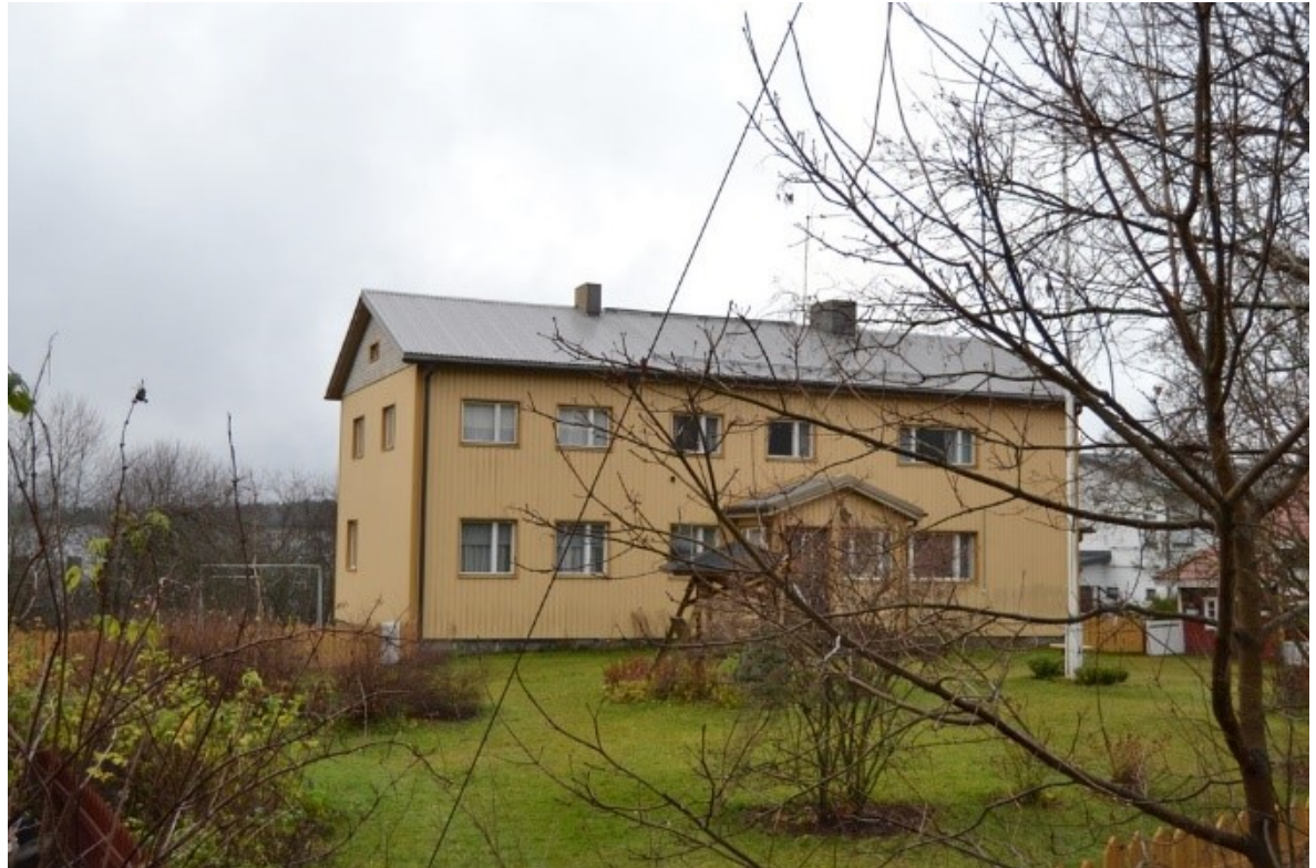
Kuva: Päärakennuksen pihan puoleinen sivu ja itäpääty kuvattuna Veijanmäenkadulta.
