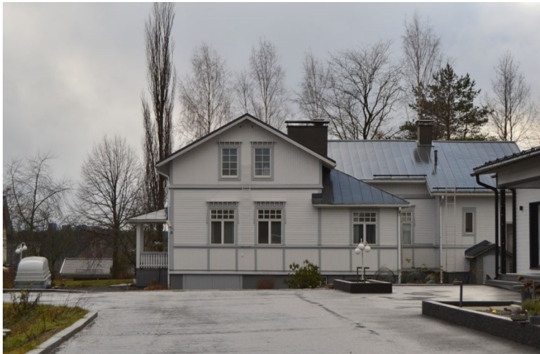
Kuva: Toivolan tilan asemakaavalla suojeltu päärakennus (sr-3) kuvattuna Loimolankadulta.
