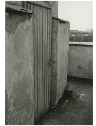
Kuvia letkujen kuivaustornista ennen peruskorjausta 1980-luvulla. PPK.
