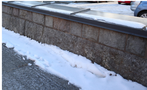
Palokunnantien puolella muuriin on asennettu konesaumattu peltikate.
