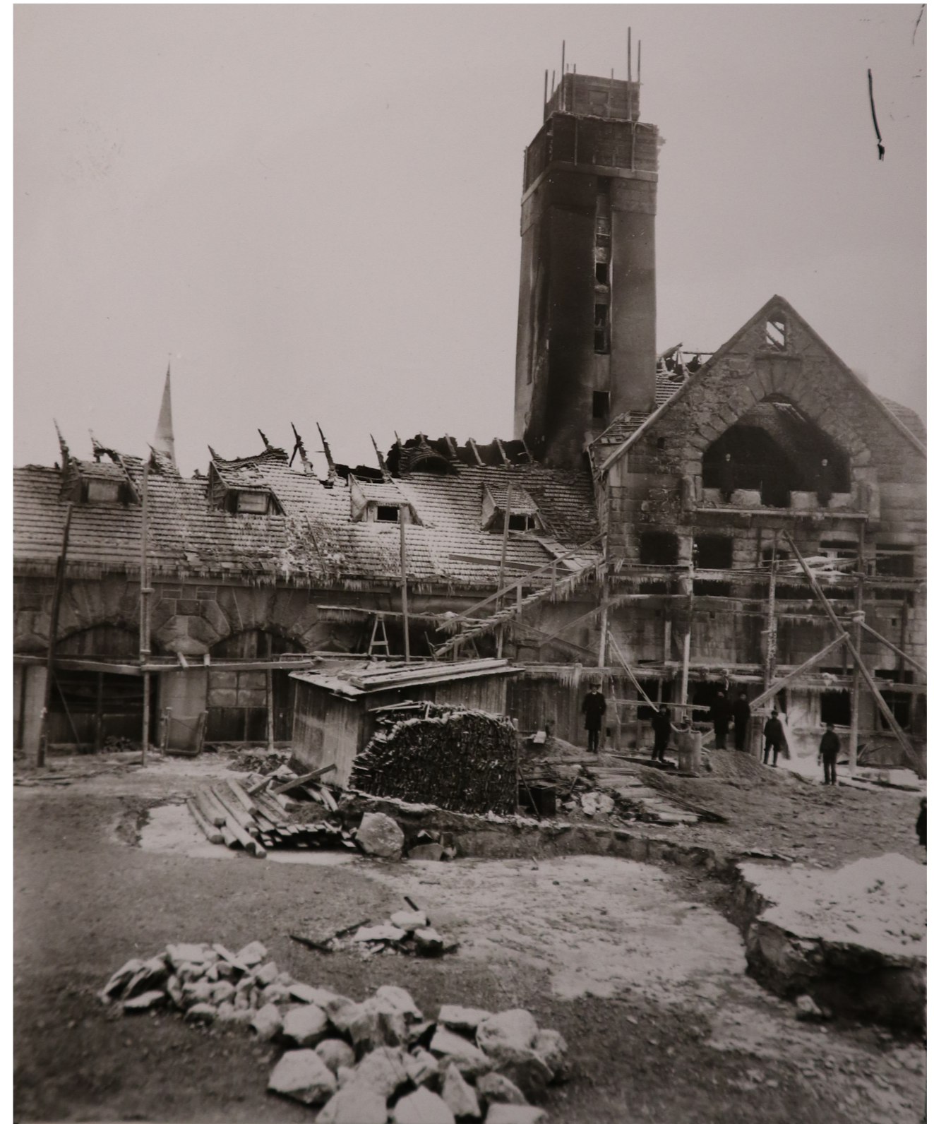
Tampereen keskuspaloasema rakennustöiden aikaisen tulipalon jälkeen jouluaattona 1907. VKA.
