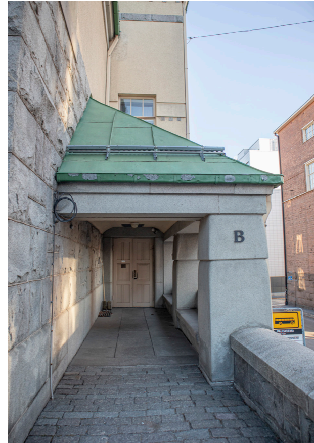
Rakennuksen läntinen sisäänkäynti. Peruskorjauk- sessa ladottu graniittikiveys yhdistyy alkuperäiseen gra- niittilaatoitukseen huomaamattomasti.
