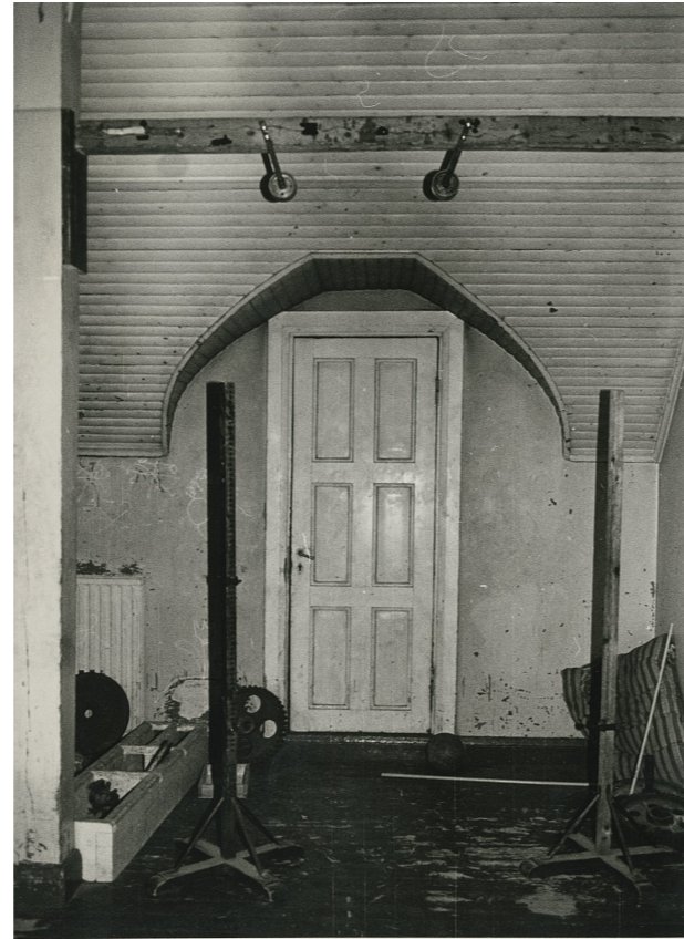
Varaston ovi ennen peruskorjausta. PPK.
