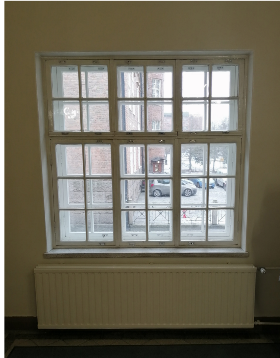
Suurin osa rakennuksen ikkunapenkeistä on vaihdettu peruskorjauksessa kivisiin. Kuvassa Satakunnankadulle antava ikkuna ensimmäisen kerroksen aulasta.
