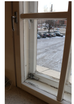
Suurimpaan osaan ikkunoita on vaihdettu modernit ikkunapainikkeet. Kuva länteen aukeavasta työhuoneesta rakennuksen pohjoisosassa.
