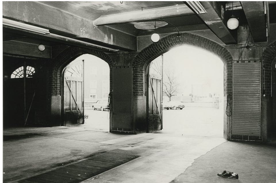
Kalustohallin oviaukot 1980-luvulla ennen peruskorjausta. PPK.
