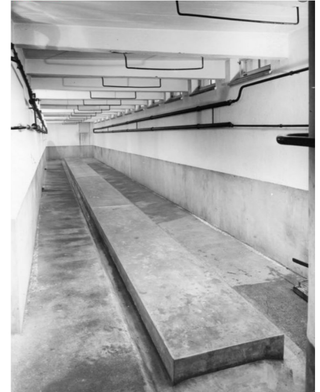
Paloaseman kellariin rakennettiin paloletkujen pesuun tarkoitettu tila, joka sijoitettiin Satakunnankadun suuntaisesti rakennuksen läntiselle puolelle. Tila purettiin 1980-luvun peruskorjauksessa. E. M. Staf 1952. PPK.
