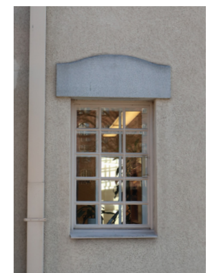
Toiselta puolelta pohjoista sisäänkäyntiä purettiin 1980-luvulla ulko-ovi jonka tilalle palautettiin Lönnin suunnitelman mukainen ikkuna.
