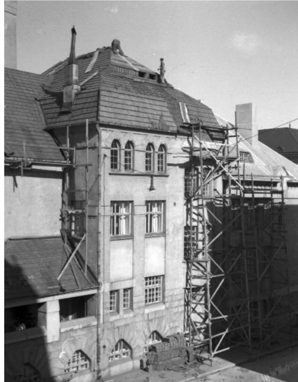
Paloaseman alkuperäistä tiilikattoa vaihdetaan peltikatoksi. Ensio Kauppila 9.9.1952. VKA.
