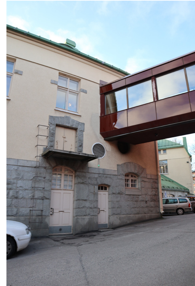
Kalustohallin takana oli hevostallit ja hevosten hoitoon liittyvät tilat. Heinävintille pääsi kulkemaan julkisivussa olevia tikkaite pitkin. Heinävintti ja alimman kerroksen huoneet ovat nykyään palokunnan varastotiloina. Ylimmän kerroksen ikkunarivi kuuluu 1920-luvulla rakennetulle ruokailusallille.
