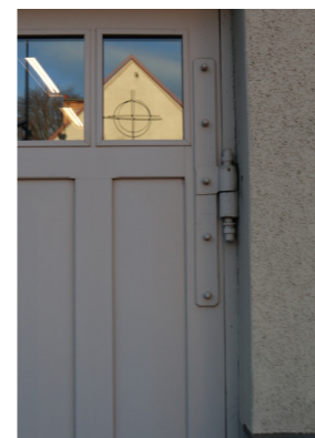
Autotalliovien sarana itäisellä julkisivulla.
