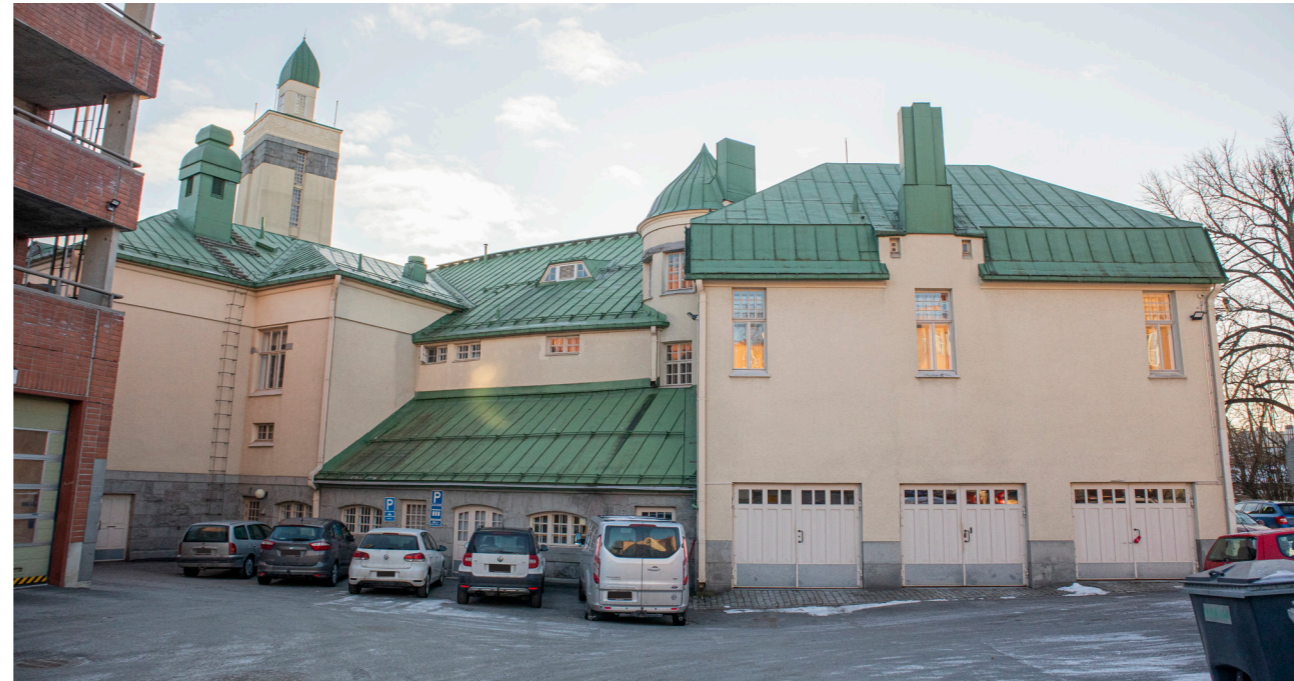
Yleisilme on lähellä alkuperäistä lukuunottamatta konesaumattua vihreää peltikattoa. Autotallien ovet ovat uudet ja pyöreän pihanportaan vierestä on poistettu savupiippu. 1980-luvulla katosta nousi lukuisia pieniä savupiippuja. Matalimmalla kattolappeella on nykyään myös modernit lumiesteet. Ullakolle aukeavan kattoikkunan keskelle on asennettu tuuletusritilä.
