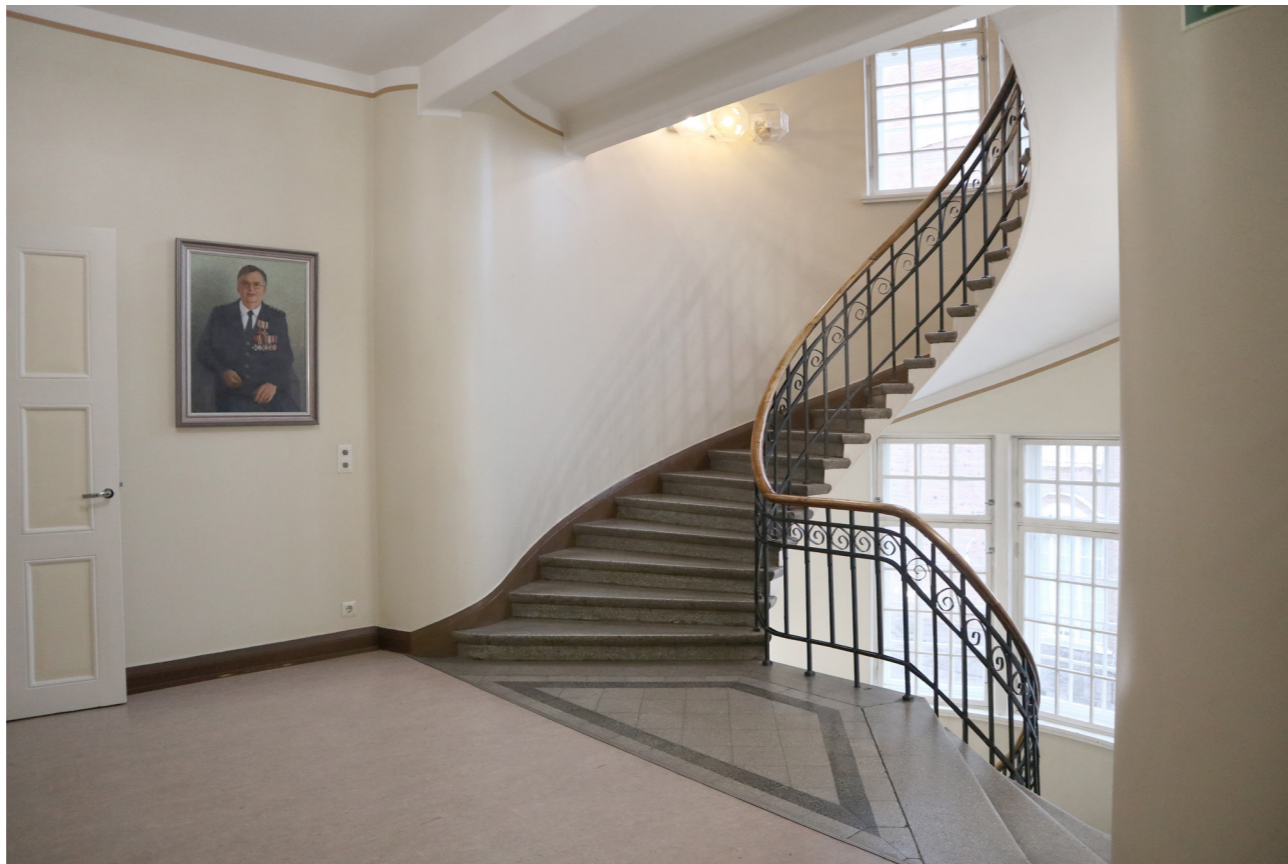
Toisen kerroksen aulasta oli Lönnin suunnitelmassa kulku muun muassa palomiesten lukuhuoneeseen ja sairastupaan. Seinällä olevan taulun paikalla oli oviaukko ruokailusaliin, joka muurattiin umpeen 1920-luvulla. Aulan puulattia on nykyisin päällystetty linoleumilla.
