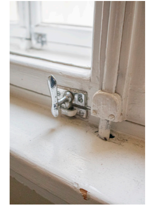
Rakennuksen ikkunoita ja ikkunaosia on uusittu vuosien saatossa aina tarpeen mukaan. Vanhoja kääntösulkimia ja puisia ikkunapenkkejä on säilynyt muutamia. Kuvassa ikkuna toisen kerroksen eteläisestä aulasta.
