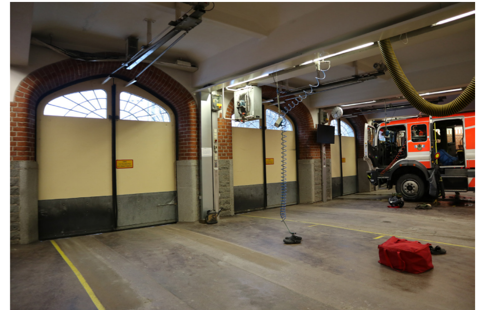
Ulko-ovet ovat nykyään modernit ja automatisoidut, mutta noudattavat alkuperäistä muotokieltä. Ensimmäiset vuosikymmenet tilassa oli tiilipermanto ja esimerkiksi valaisimet on uusittu useaan kertaan.
