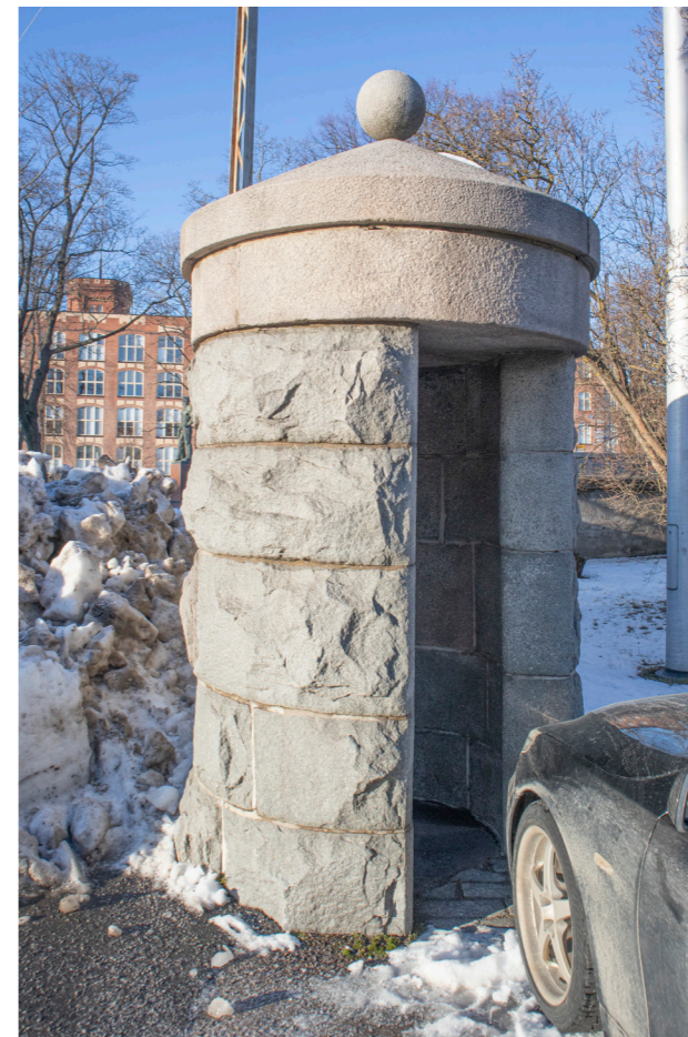
Alkuperäinen muuri oli tiilikatteinen, kuten vaikkapa lähes samanikäisessä Tampereen Tuomiokirkon muurissa. Graniittiset pääliskivet asennettiin vuonna 1919. Vasemmanpuoleisessa portissa on sisennys, jossa portilla päivystävä palomies oli valmiina ottamaan vastaan tiedon tulipalosta 1900-luvun ensimmäisinä vuosikymmeninä ennen moderneja hälytysjärjestelmiä. Portin oikeanpuoleisessa osassa on jugend-henkinen katuvälilais ja ilme on lähellä alkuperäistä.
