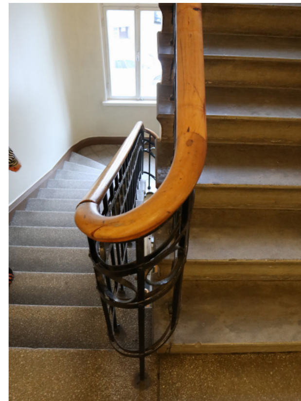
Askelmien kivilaatu muuttuu betoniksi kuljettaessa ylös ullakokerrokseen.
