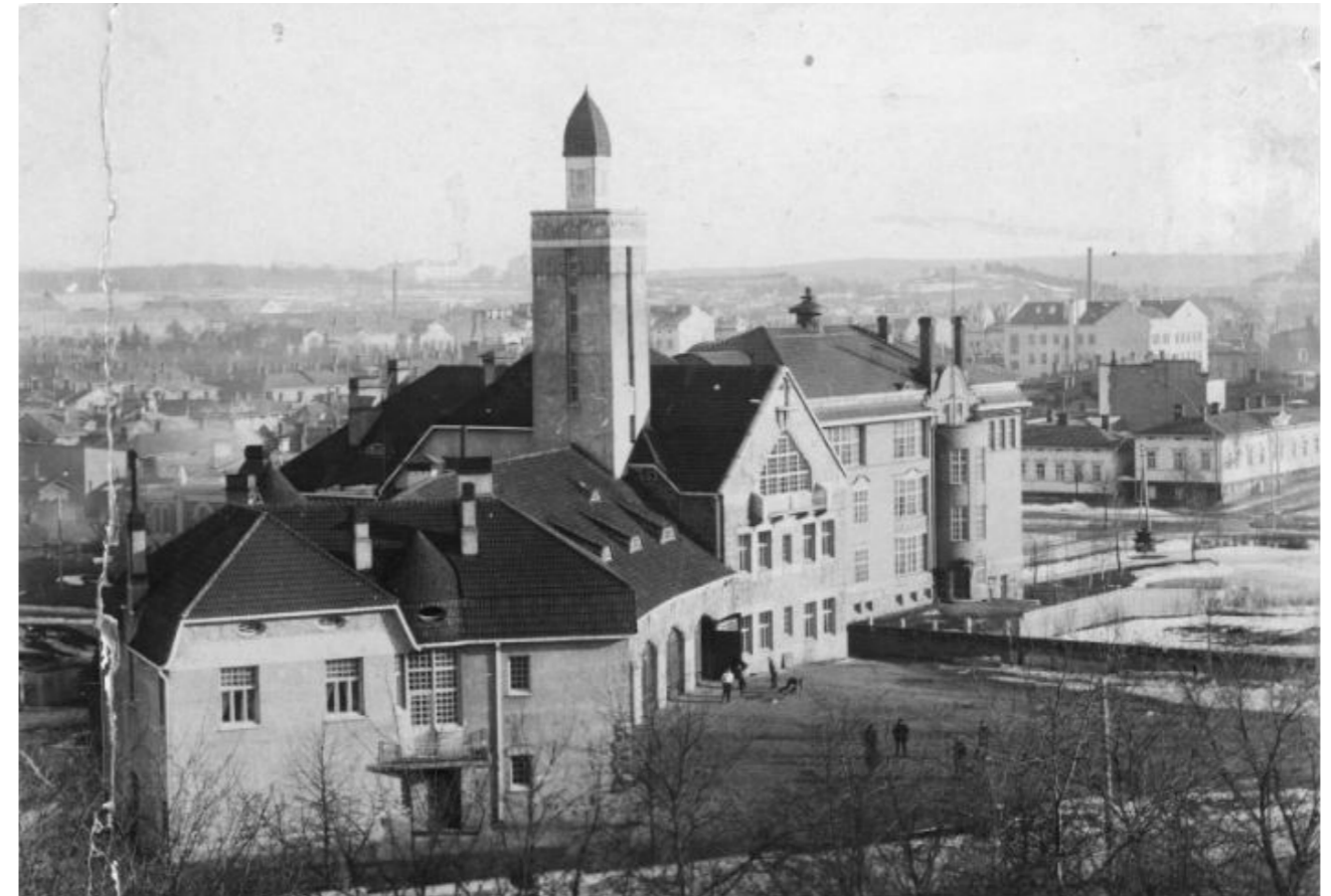
Keskuspalloasema pohjoista ulkoasua Lapintien suunnasta kuvattuna. Taustalla Kyttälän puutaloaluetta. Aika-arvio 1919-1921. PPK.
