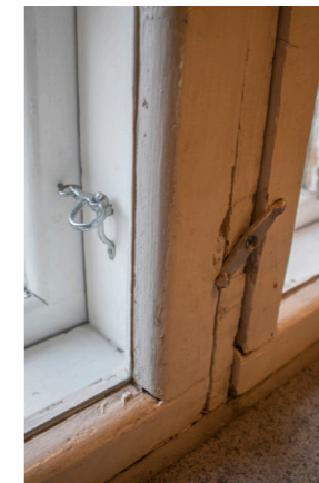
Kuvassa tallien ikkunat itään sisäpihan puolelle.
