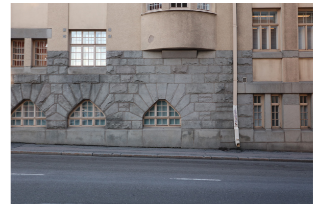
Satakunnankadun julkisivussa sisäporras näyttyytyy ulkonevana erkkerinä, jonka alapuolella on 1920-luvulla lisätty ikkuna.
