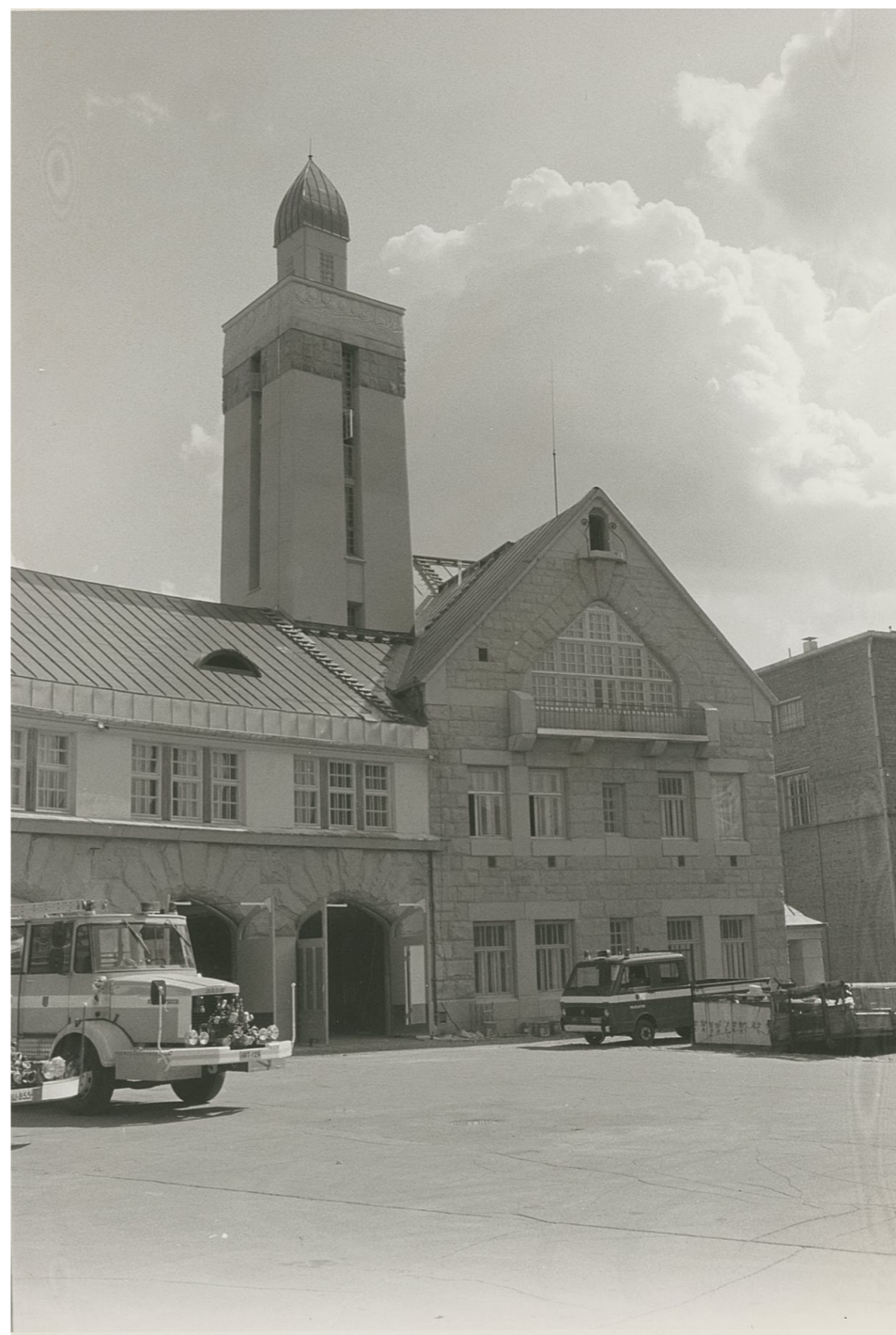
Peruskorjattu keskuspaloasema 1980-luvulla. PPK.
