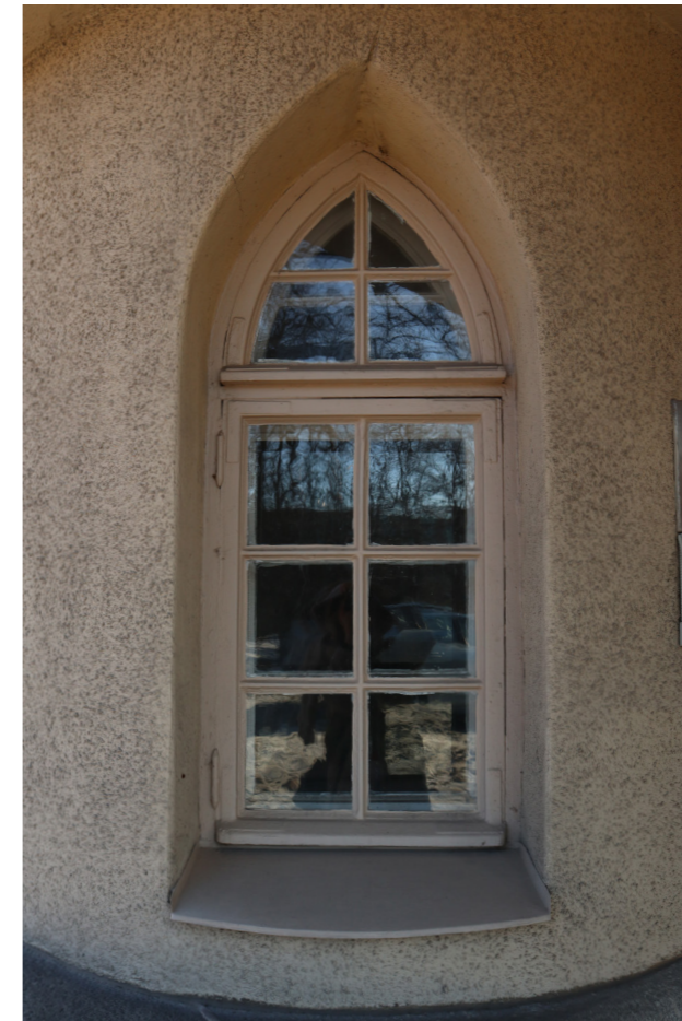
Pohjoisessa sisäänkäynnin vieressä on suippokaarinen ikkuna joka on säilynyt lähes alkuperäisenä.
