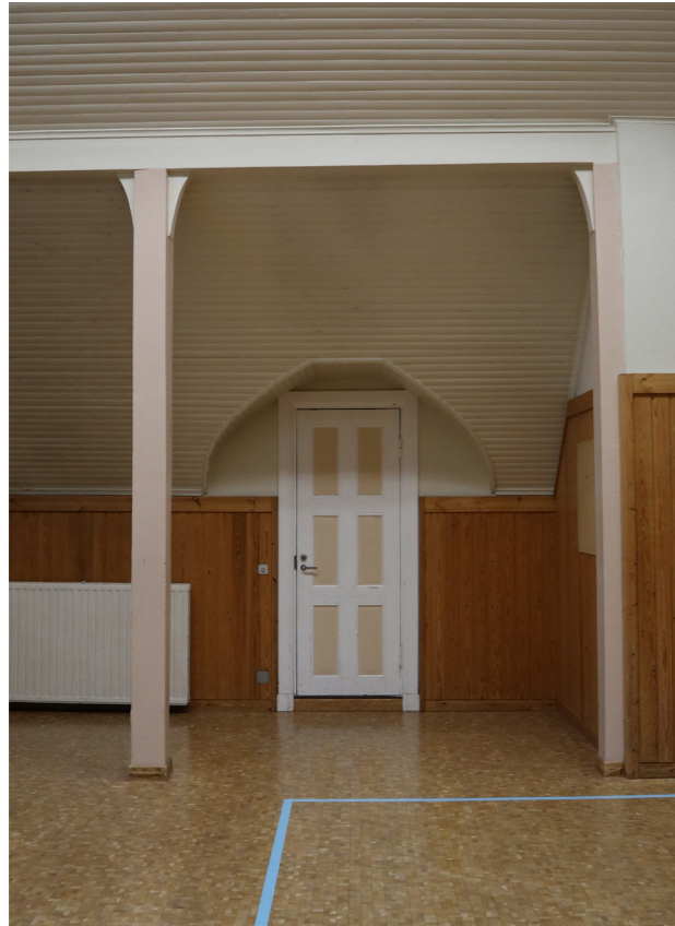
Pohjoisen suuntaan avautuneen ikkunaaukon paikalle rakennettiin 1920-luvun kattokorotuksen aikana varastotila.
