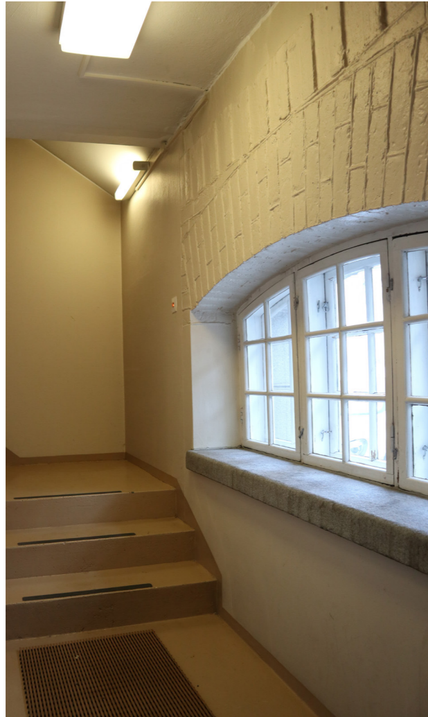
Alkujaan hevostalleista itäiselle sisäpihalle avautunut kaariholvattu ikkuna.
