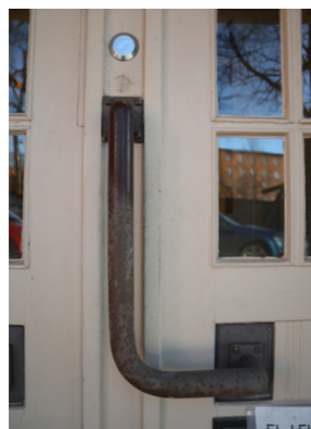
A-rapun ulko-ovessa on säilynyt sekä sisä- että ulkopuolella alkuperäiset lankavetimet.
