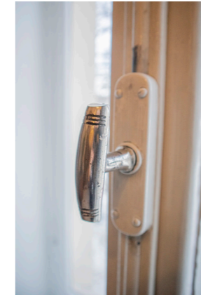
Niklatusta messingistä valmistettuja 1900-luvun alun espanjoletteja löytyy edelleen muun muassa ruokasalista ja pohjoisjulkisivun parvekkeen ikkunoista.
