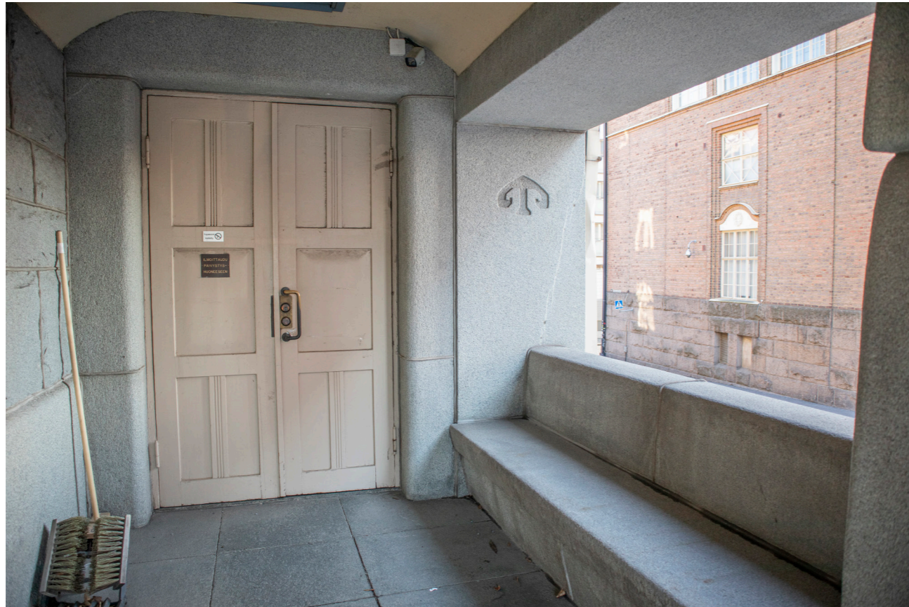
Rakennuksen pääsisäänkäynti läntisellä julkisivulla. Aiemmin ovi johdatti muun muassa perheellisten palomiesten asuntoihin, nyt kulku on tarkoitettu toimistosiiven työntekijöiden lisäksi paloasemalla vierailville sekä palomuseon asiakkaille. Sisäänkäynnillä on rakennuksen ulkoasulle tyypilliset vaaleat maalatut peiliovet ja messinkinen lankavedin abloyn lukolla. Ulko-oven oikealla puolella on kiven istuskelupaikka.
