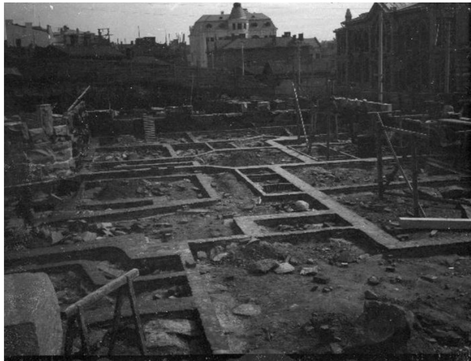
Keskuspaloaseman perustuksia rakennetaan. 1907. VKA.
