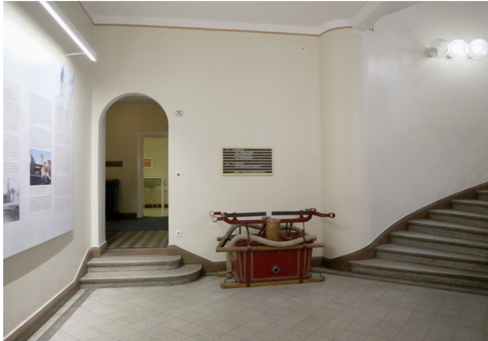
Ensimmäisen kerroksen aulatilojen kiviset porraskelmat ja lattia ovat alkuperäiset.
