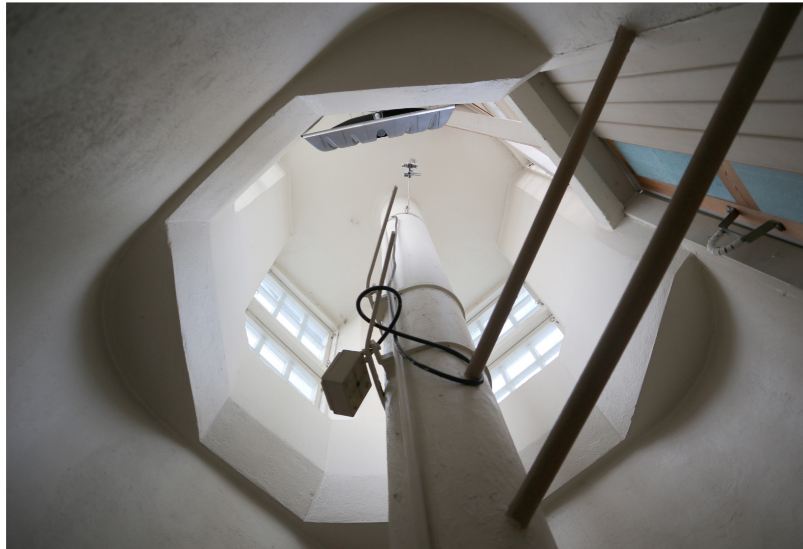
22-metrinen letkujen kuivaustornin kiertoporras johdattaa kellarista ylös tähytysparvekkeelle. Tornissa on useampi porrastasanne ja keskellä tila paloletkujen kuivaukselle. Kesäisin letkuja kuivattiin myös itäiseen julkisivuun kiinnitetyssä työtelineessä, joka purettiin 1980-luvulla.
