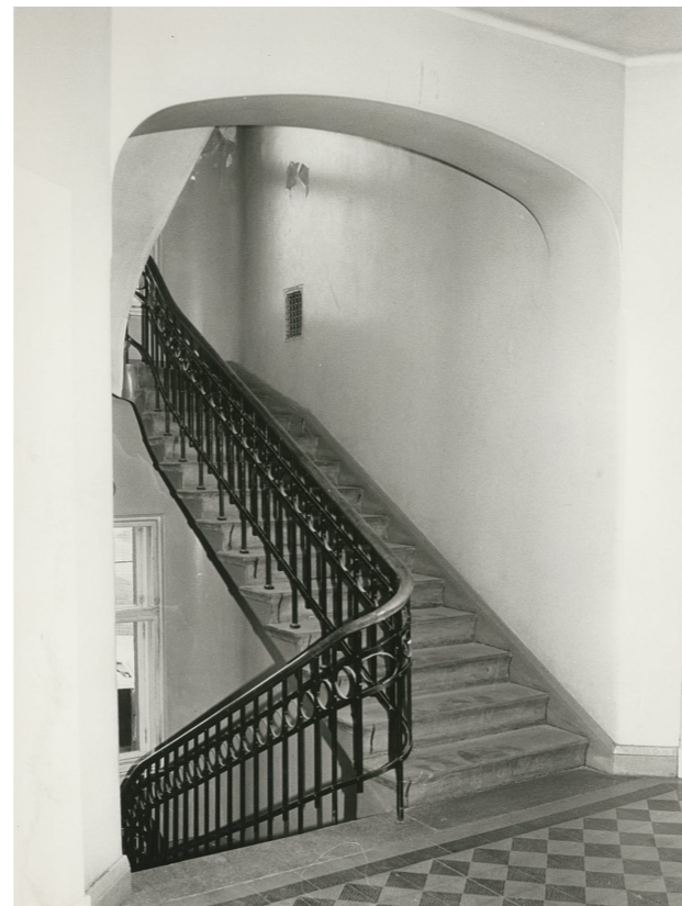
Porrashuone ennen peruskorjausta. PPK.
